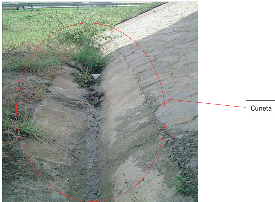
FIGURA 157. PROTECCIÓN DEL TERRAPLÉN MEDIANTE CUNETAS.
