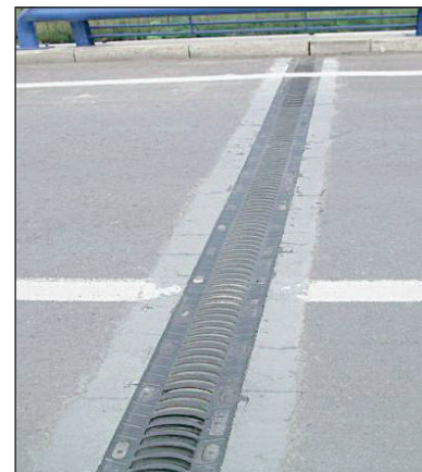
FIGURAS 133 Y 134. JUNTA DE TIPO «ELASTÓMERO ARMADO».
