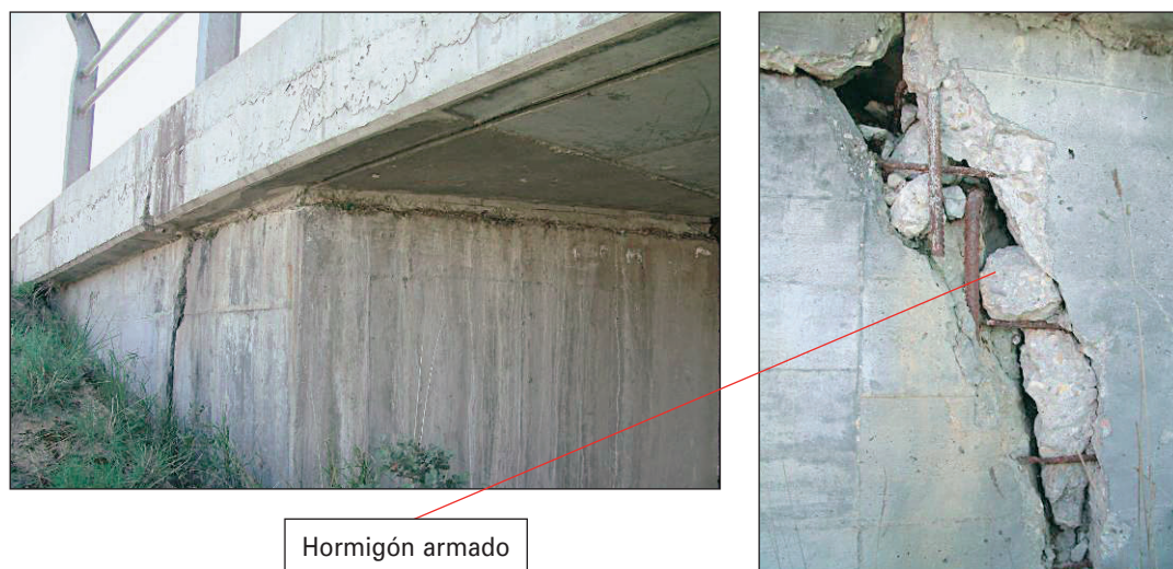
FIGURAS 289 Y 290. MATERIAL: HORMIGÓN ARMADO.
