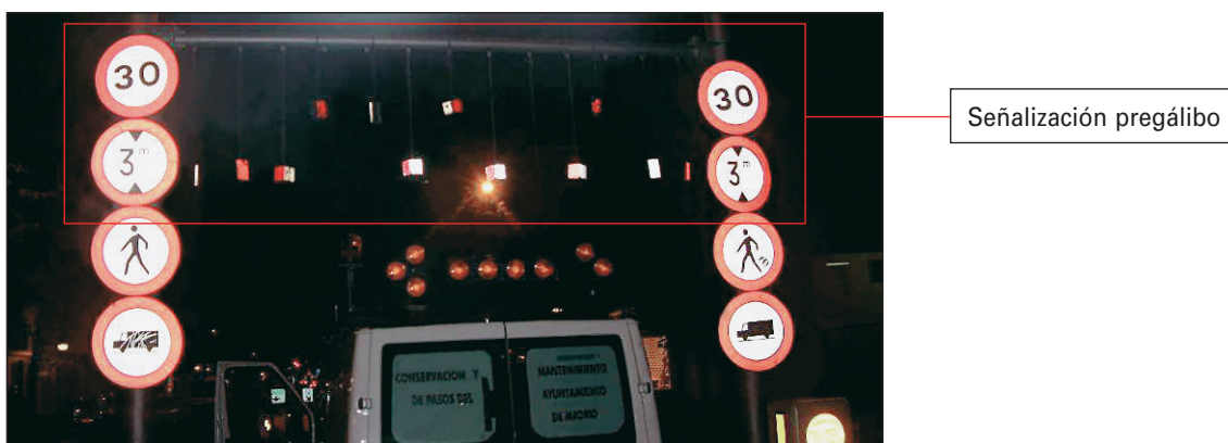
FIGURA 144. PÓRTICO PREGÁLIBO COMO ELEMENTO DE PROTECCIÓN.
