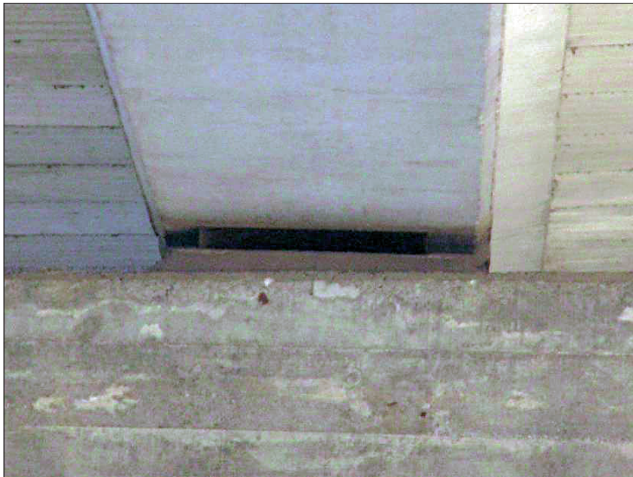
FIGURA 91. APOYO SIMPLE.
