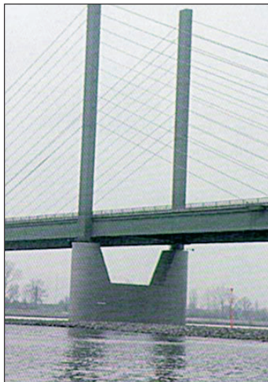
FIGURAS 248, 249 Y 250. TIPOLOGÍA DE PILONOS: TORRE SIMPLE, TORRES DOBLES EXENTAS Y TORRES DOBLES ARRIOSTRADAS.
