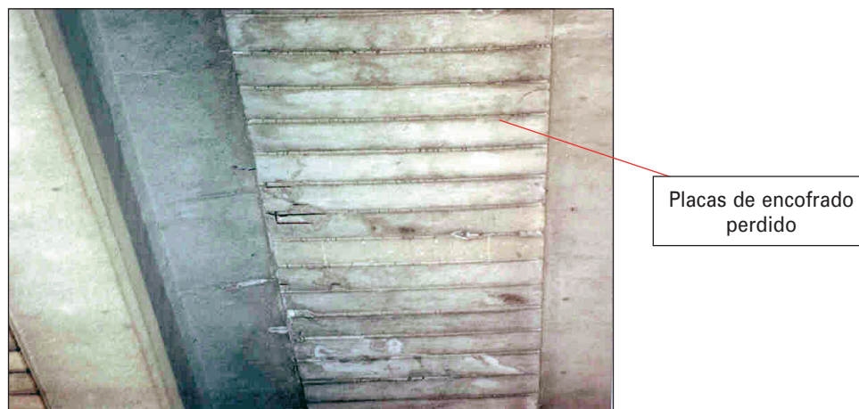
FIGURA 51. PLACAS DE ENCOFRADO PERDIDO.
