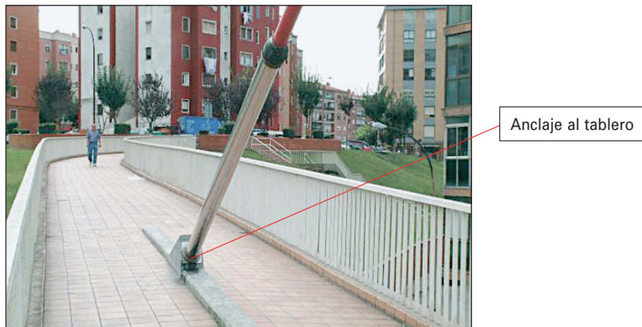
FIGURA 274. ANCLAJE TIRANTE/TABLERO.
