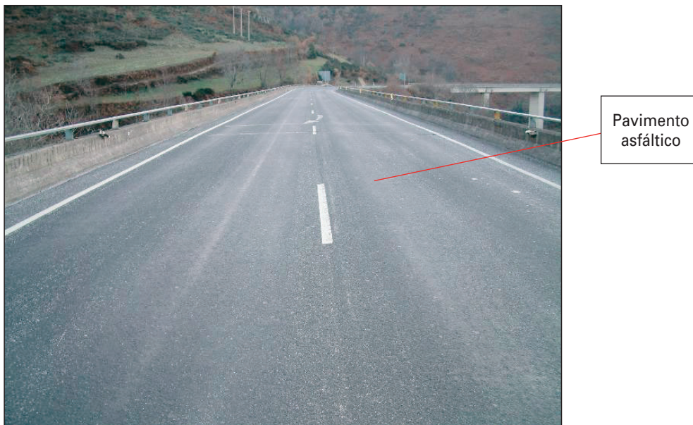
FIGURA 158. PAVIMENTO DE TIPO ASFÁLTICO.
