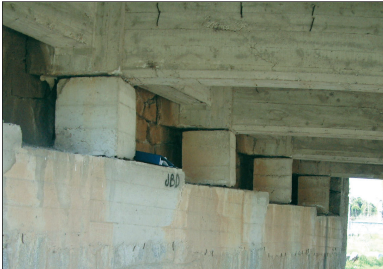
FIGURA 78. DADO DE HORMIGÓN.
