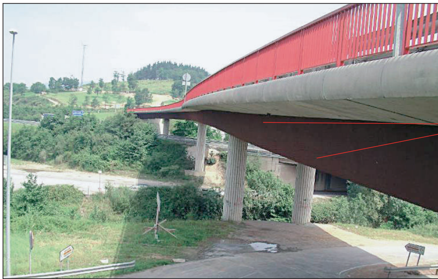
FIGURA 61. PILAS DE FUSTES MÚLTIPLES EXENTOS.
