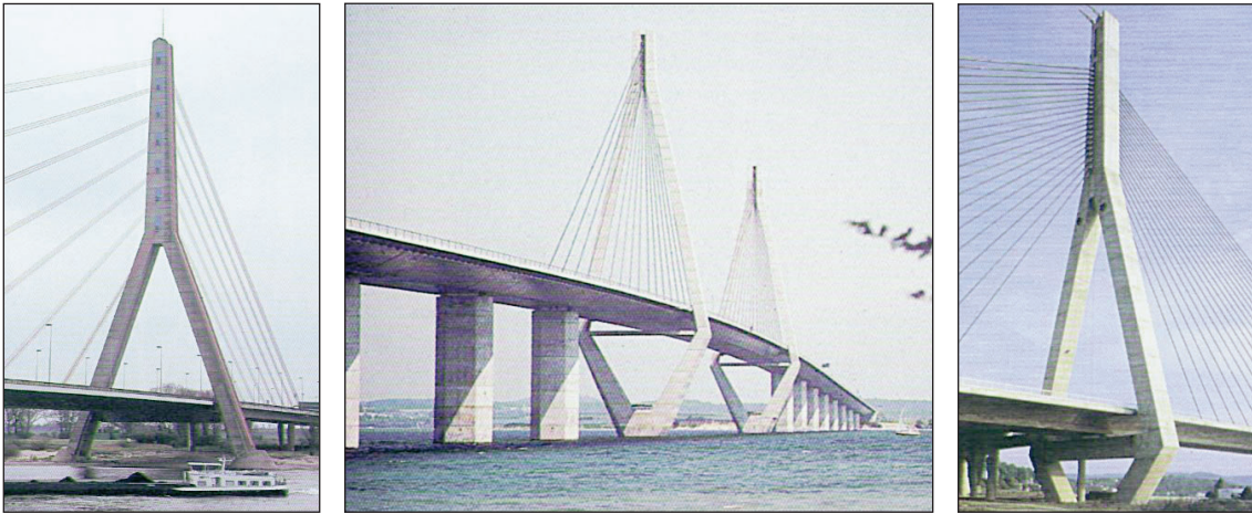
FIGURAS 251, 252 Y 253. TIPOLOGÍA DE PILONOS: EN A PROLOGADA, EN DIAMANTE Y EN DIAMANTE PROLONGADO.
