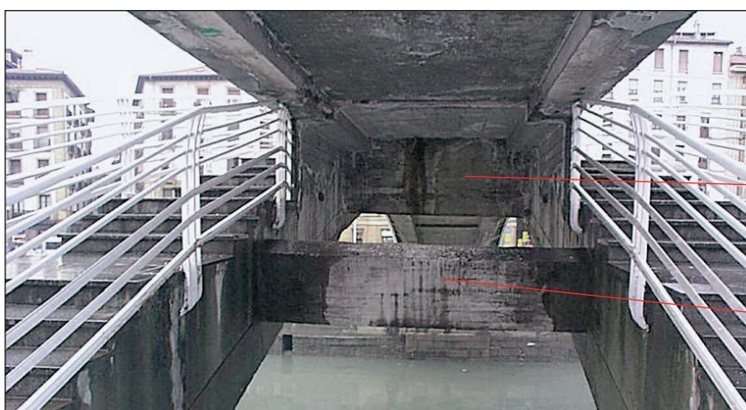
FIGURA 217. TRAVIASAS EN INTERMEDIAS Y EN CONTACTO ARCO-TABLERO.
