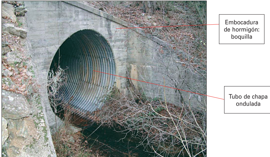
FIGURA 236. ELEMENTOS DE UN TUBO.
