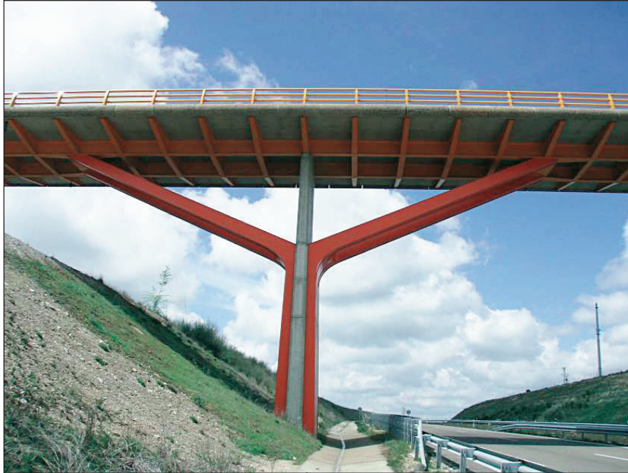
FIGURA 94. JABALCONES EN PILAS.
