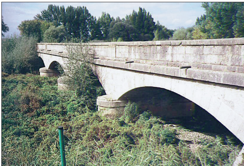
FIGURA 25. TABLERO TIPO BÓVEDA
