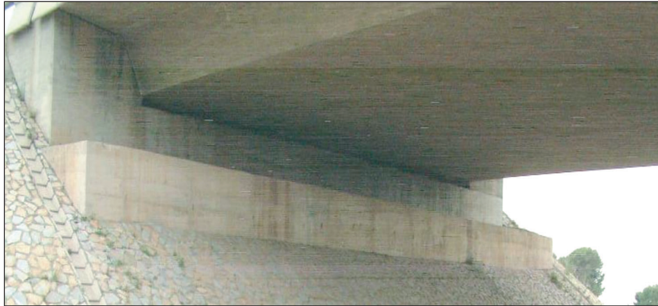
FIGURA 117. CONEXIÓN ESTRIBO - TABLERO EN UN ESTRIBO.
