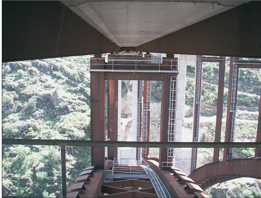
FIGURA 229. TIPOLOGÍA DEL TABLERO: TABLERO SOBRE PILAS/ESTRIBOS.
