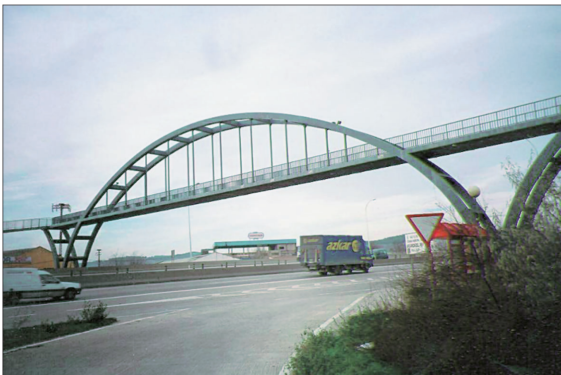
FIGURA 212. ARCO TIPO «TABLERO INTERMEDIO».
