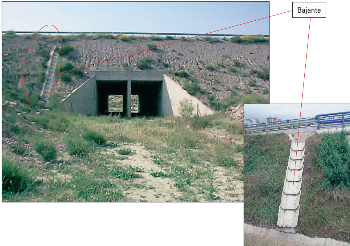
FIGURAS 155 Y 156. PROTECCIÓN DEL TERRAPLÉN MEDIANTE BAJANTES.
