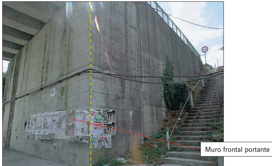
FIGURA 111. MURO FRONTAL PORTANTE.
