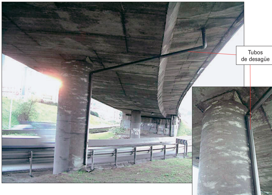
FIGURAS 176 Y 177. ELEMENTOS DEL SISTEMA DE DRENAJE: TUBOS DE DESAGÜE.
