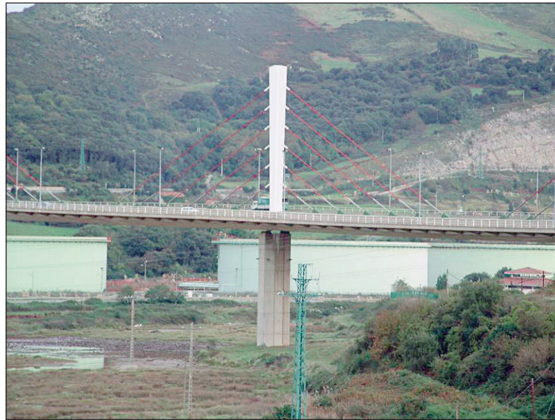
FIGURA 258. TIRANTES SEGÚN UN PLANO VERTICAL.
