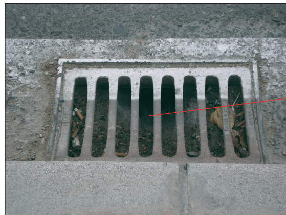
FIGURA 173. ELEMENTOS DEL SISTEMA DE DRENAJE: SUMIDERO.
