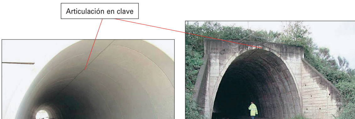
FIGURAS 204 Y 205. BÓVEDA CON ARTICULACIÓN EN CLAVE.
