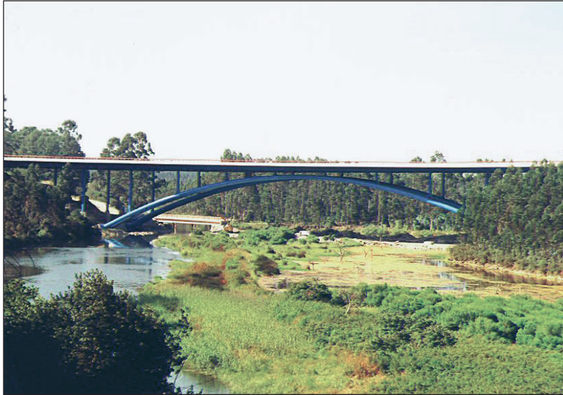
FIGURA 24. TABLERO TIPO ARCO.
