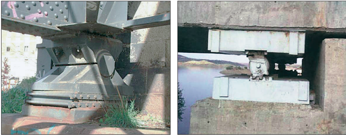
FIGURAS N.º 80 Y N.º 81. EJEMPLOS DE RODILLO.
