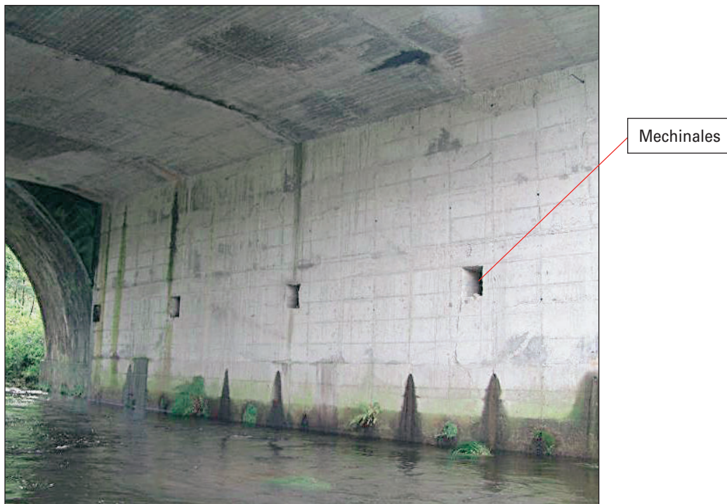
FIGURA 182. OTROS ELEMENTOS: MECHINALES EN MUROS.
