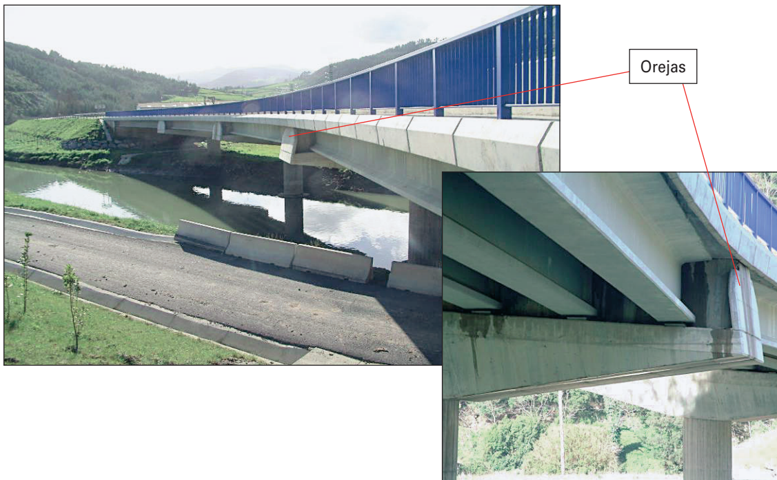
FIGURA 95 Y 96. OREJAS EN PILAS.
