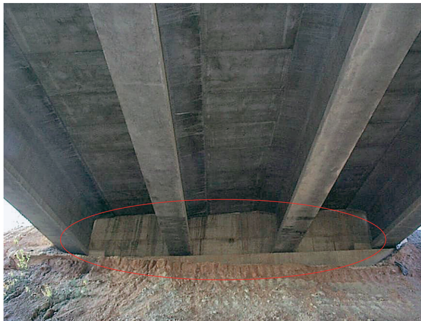
FIGURA 118. MURETE DE GUARDA.
