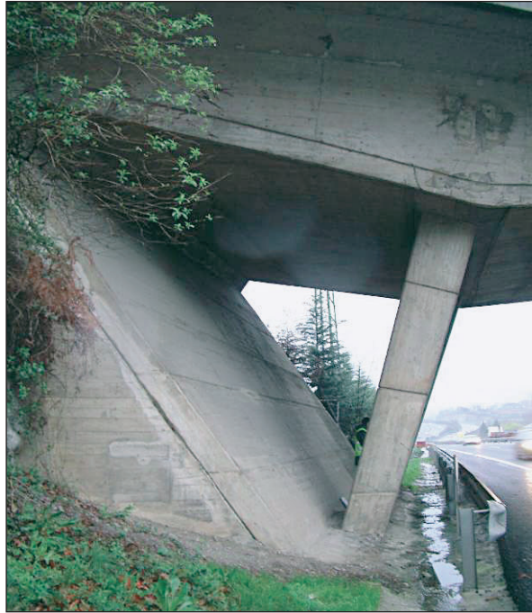
FIGURA 63. PILA TIPO CÉLULA.
