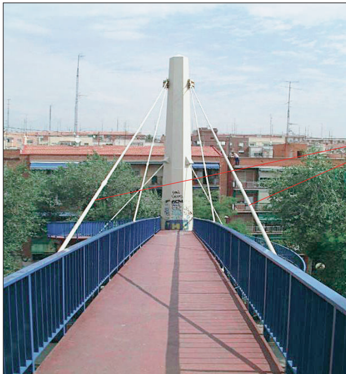
FIGURA 257. ATIRANTAMIENTO A BORDE DE TABLERO.
