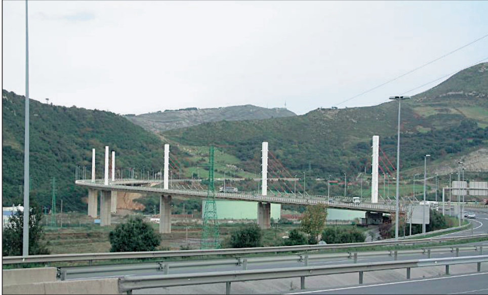
FIGURA 28. TABLERO TIPO ATIRANTADO.
