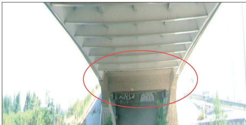
FIGURA 216. TRAVIASAS EN ARRANQUES.
