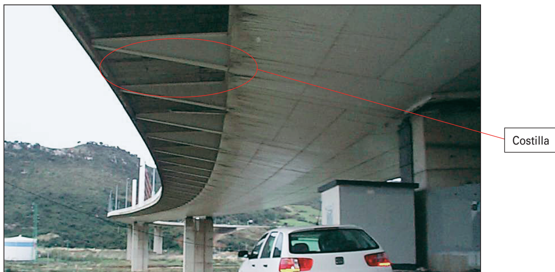
FIGURA 46. COSTILLAS EN TABLERO.
