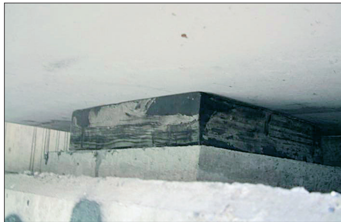
FIGURA 88. ELASTÓMERO ZUNCHADO.
