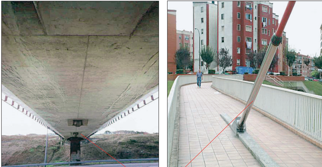
Atirantamiento al eje del tablero (ANCLAJE AL TABLERO)
