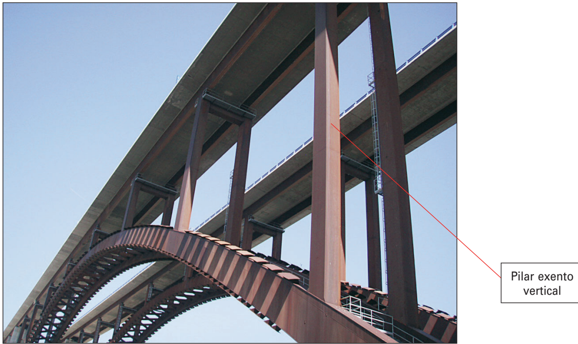
FIGURA 227. CONEXIÓN ARCO/TABLERO: PILARES VERTICALES.
