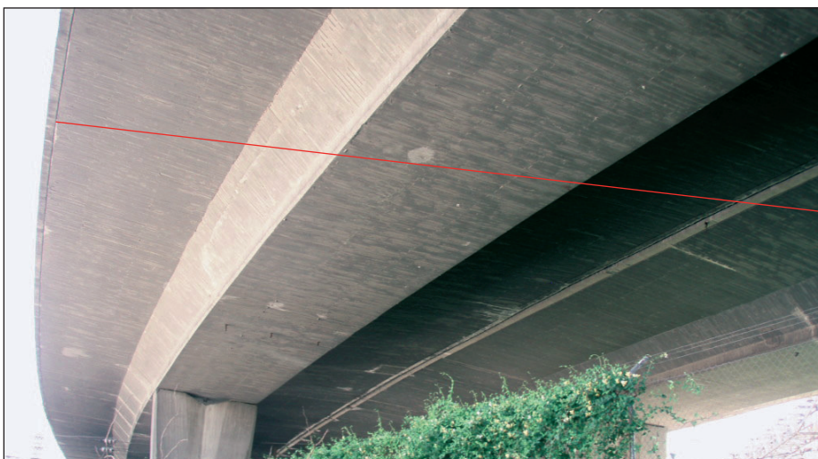
FIGURA 180. ELEMENTOS DEL SISTEMA DE DRENAJE: GOTERÓN.
