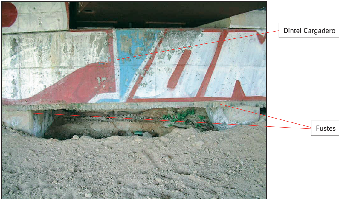
FIGURA 115. CARGADERO SOBRE FUSTES.
