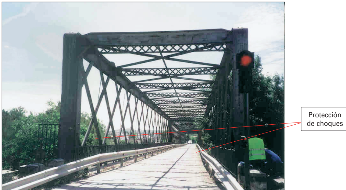
FIGURA 146. PROTECCIÓN FRENTE A IMPACTO.
