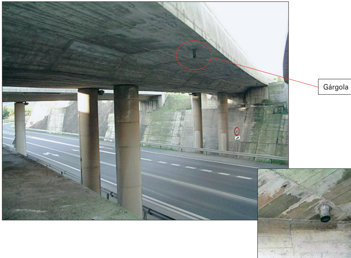
FIGURAS 174 Y 175. ELEMENTOS DEL SISTEMA DE DRENAJE: GÁRGOLA.
