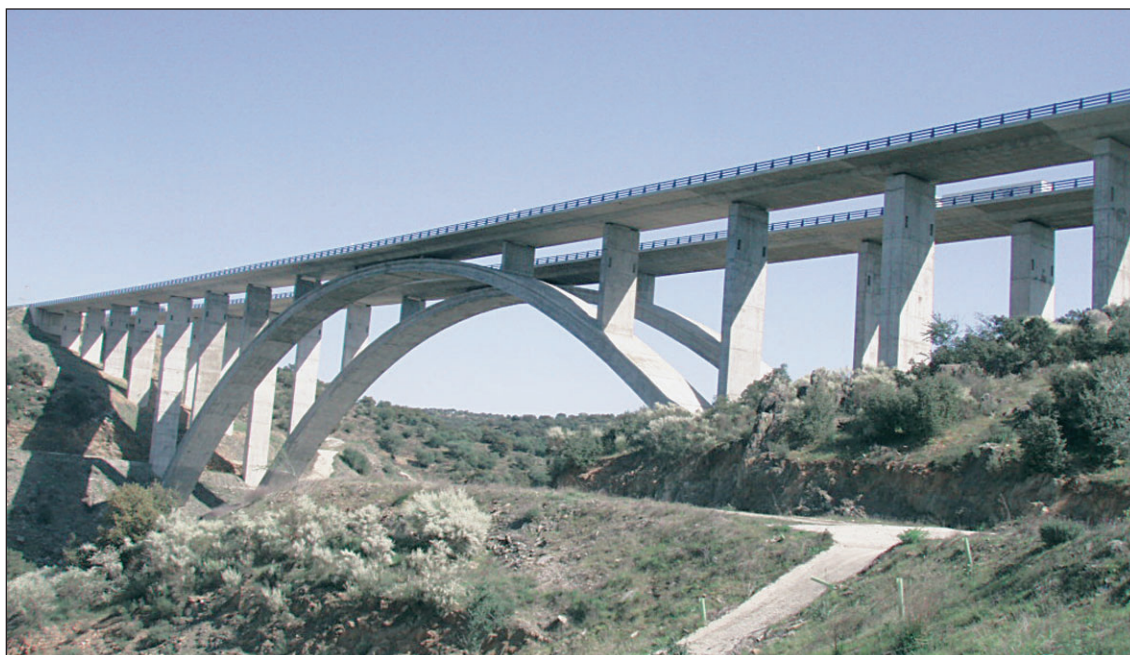
FIGURA 210. ARCO TIPO «TABLERO SUPERIOR».
