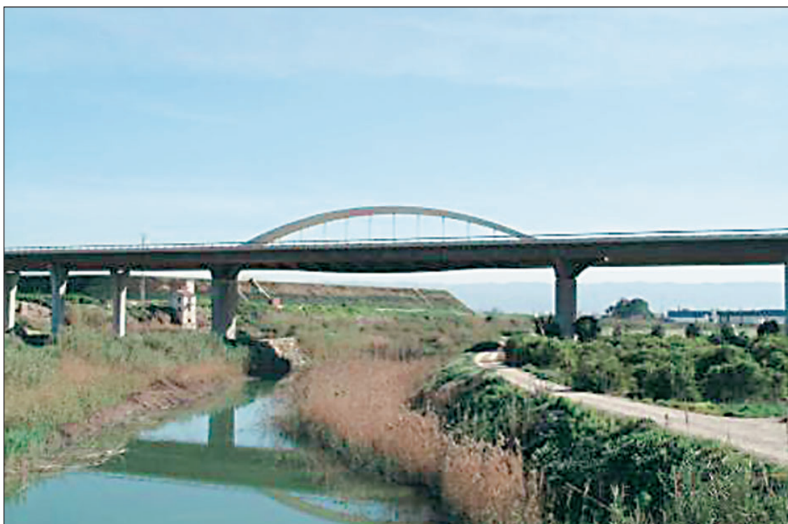
FIGURA 211. ARCO TIPO «TABLERO INFERIOR».
