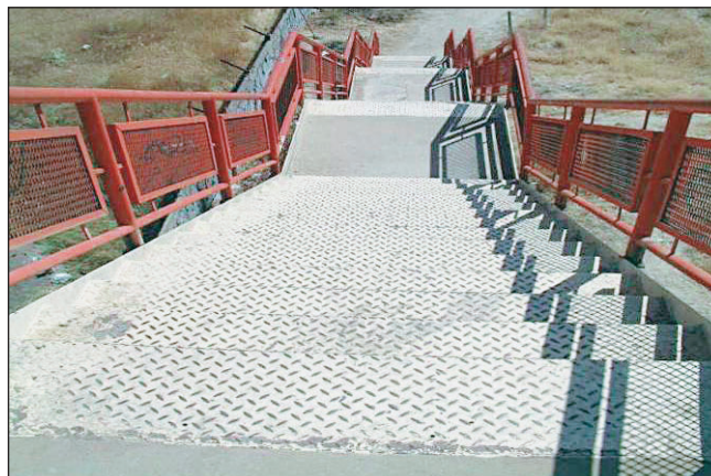
FIGURA 185. ESCALERAS DE ACCESO.
