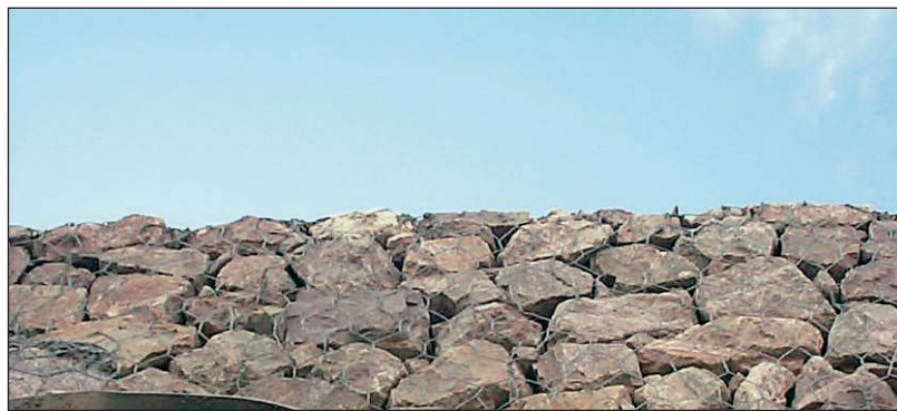
FIGURA 152. PROTECCIÓN DEL TERRAPLÉN MEDIANTE ESCOLLERA.
