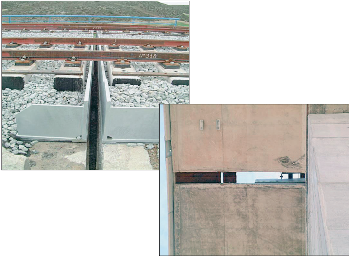
FIGURAS 138 Y 139. JUNTA DE TIPO «CHAPAS METÁLICAS».
