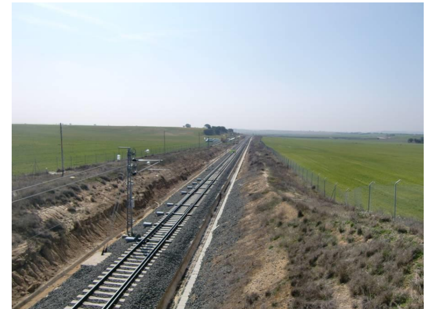
VISTA HACIA EL SUR, DESDE EL P. S. DEL CAMINO DE CUARTE A TABERNAS SOBRE LA LÍNEA FERROVIARIA
