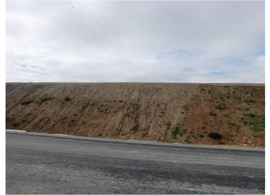
TERRAPLÉN EN EL QUE HABRÁ DE EJECUTARSE EL P. I – 0 67 BAJO LA A – 22. VISTA DESDE MARGEN IZQUIERDA DE LA AUTOVÍA (SENTIDO ZARAGOZA)
