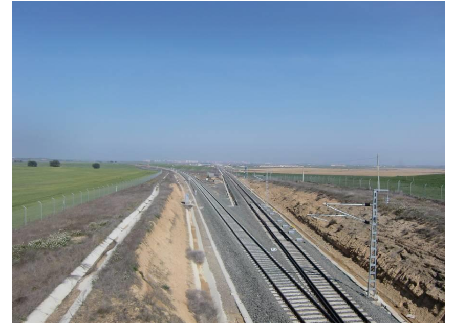
VISTA ZONA DE CRUCE LÍNEAS FERROVIARIAS
