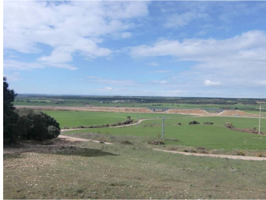
VISTA TRAMO FINAL DE LA A – 22 DONDE SE UBICARÁ LA CONEXIÓN CON ESTA AUTOVIA (ENLACE SIÉTAMO).
