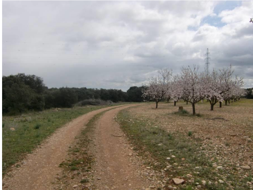
VISTA CAMINO CRUZADO EN EL ENTORNO DEL PK 14+710. REPOSICIÓN MEDIANTE PASO INFERIOR.
