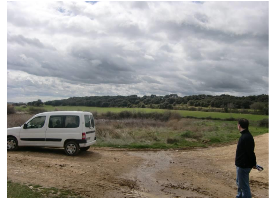
VISTA ZONA DEPRIMIDA CON ACUMULACIÓN DE AGUA. EL PROYECTO CONTEMPLA EL RELLENO DE ESTA ZONA Y LA REPOSICIÓN DE LA Balsa.
