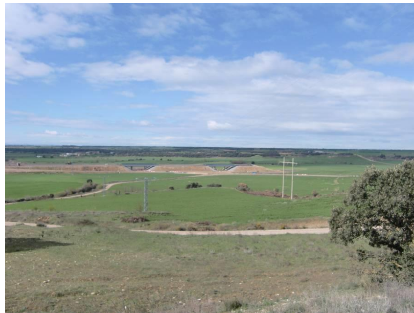
VISTA TRAMO FINAL DE LA A – 22 DONDE SE UBICARÁ LA CONEXIÓN CON ESTA AUTOVIA (ENLACE SIÉTAMO).
