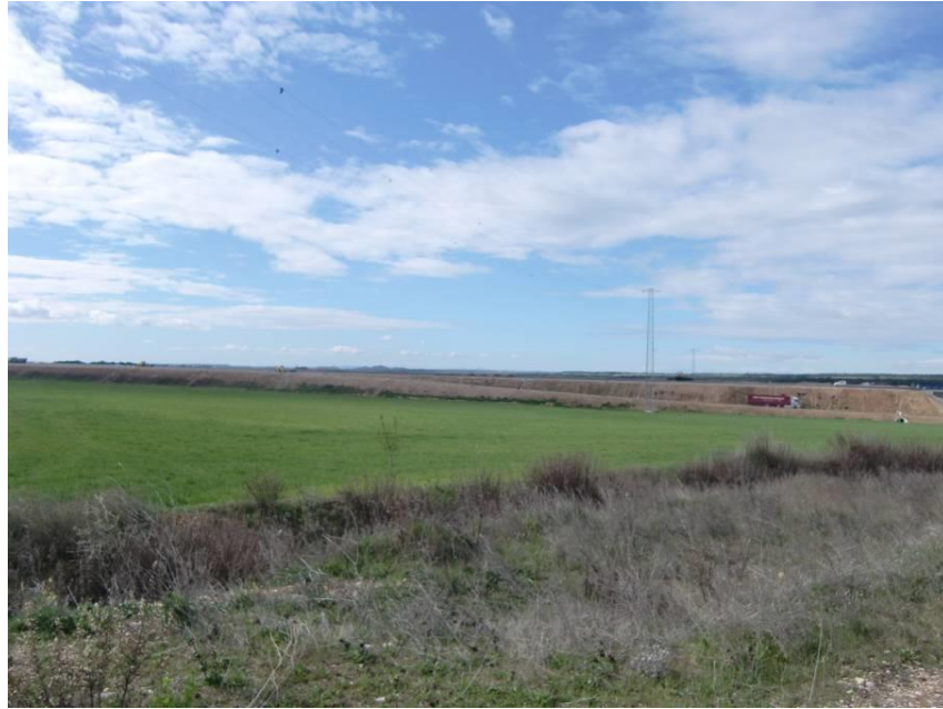
VISTA DESDE MARGEN IZQUIERDA DE LA AUTOVÍA A – 22. EN CONSTRUCCIÓN. ZONA CORRESPONDIENTE AL RAMAL LLEIDA – GLORIETA A – 22 (EJE 101) DEL ENLACE DE SIÉTAMO.
