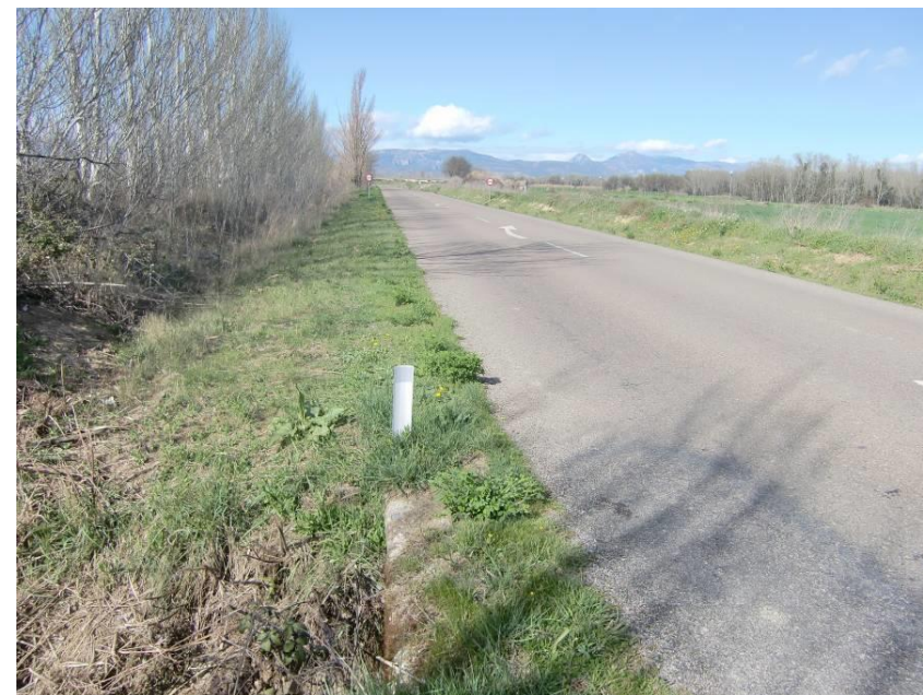
VISTA CARRETERA A-1212 SENTIDO HUESCA
