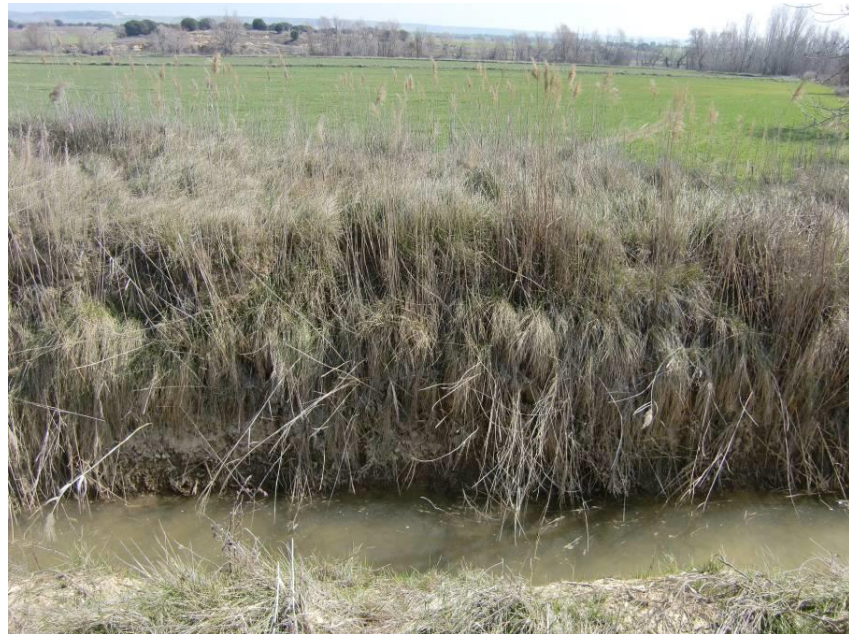
VISTA LLANURA DE INUNDACIÓN DEL RÍO FLUMEN AL OTRO LADO DE LA ACEQUIA MADRE. VISTA DE LA ACEQUIA EN PRIMER PLANO
