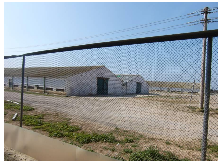
VISTA DE LA SEGUNDA DE LAS GRANJAS NO AFECTADA POR EL TRAZADO.
