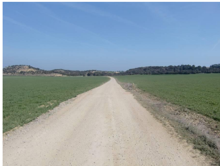
VISTA ZONA DE CRUCE DE LA VARIANTE SOBRE EL CAMINO DEL CARRASCAL
