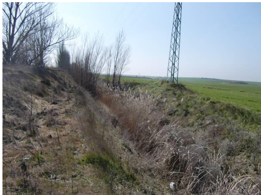
VISTA ACEQUIA PARALELA A LA CARRETERA A - 1212.
