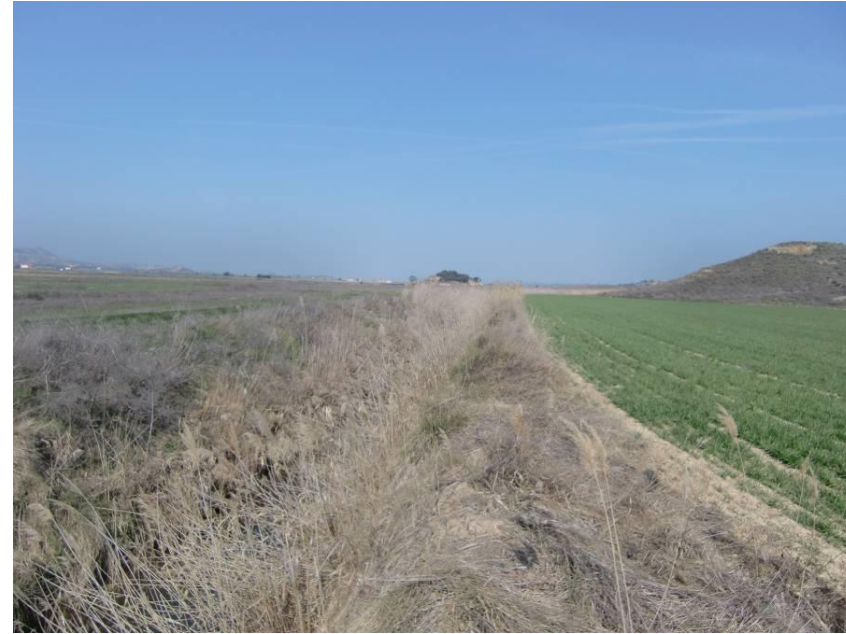
BARRANCO DE VALDABRA. VISTA AGUAS ARRIBA
