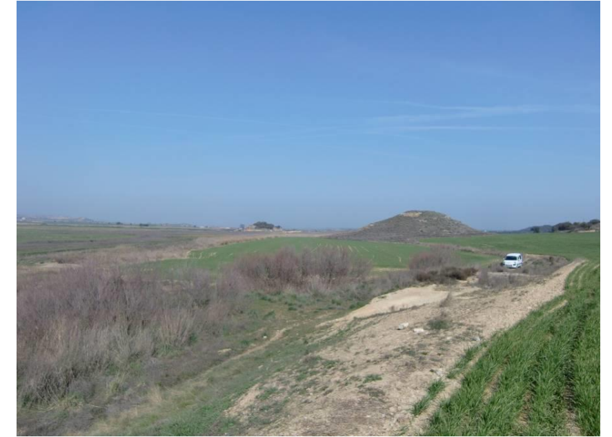
VISTA TRAMO ENTRE PPKK 1+ 300 – 1+500. MARGEN IZQUIERDA.
