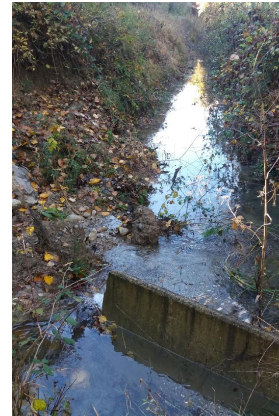
Fotografía 3.- Inicio del tramo en tierras
