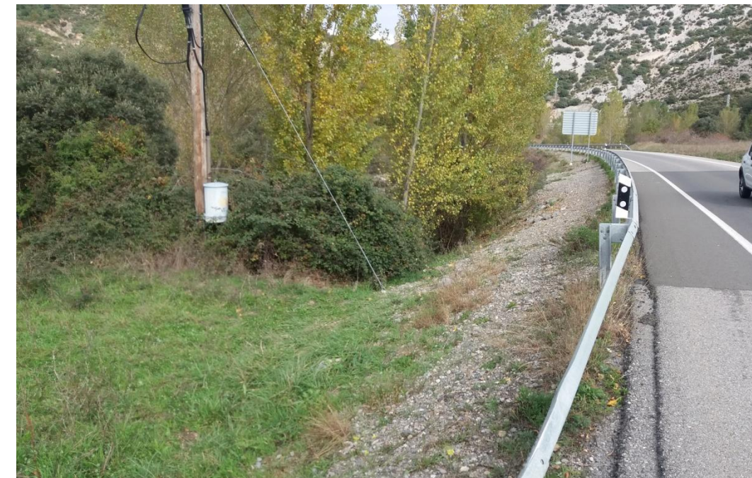
Fotografía 1.- Vista del apoyo nº 3, PK 0+265
