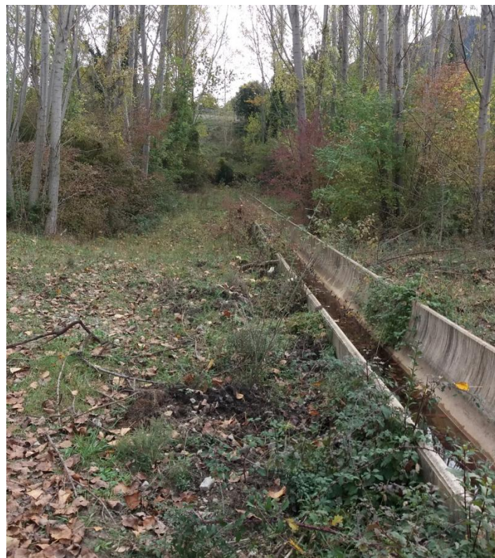
Fotografía 2.- Vista del tramo de acequia ejecutado con canal de hormigón prefabricado
