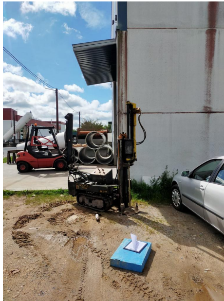
Ensayo de penetración dinámica P1
