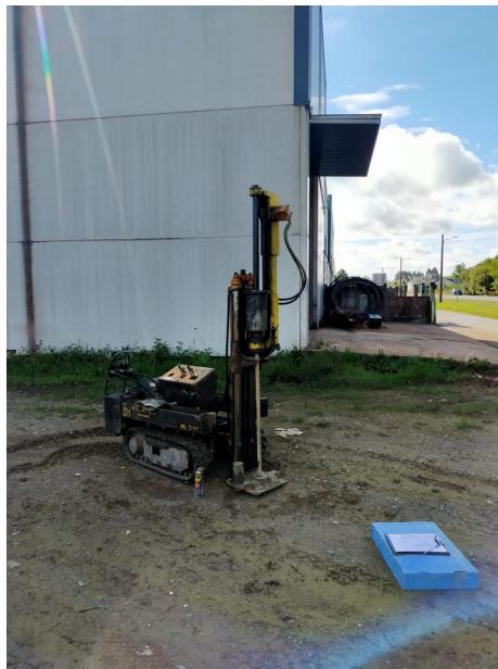
Ensayo de penetración dinámica P2
