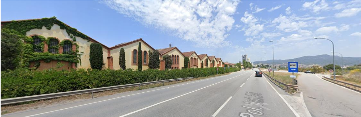
PK 1240+350. Edificio Cavas Rondel de 1948
