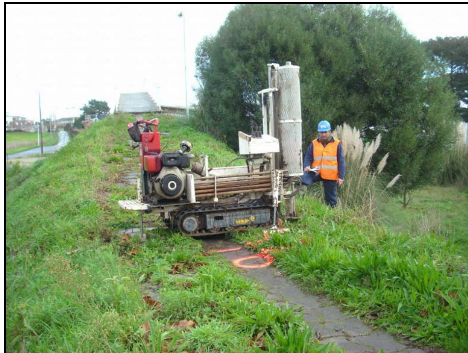
VISTAS PDC-6 (PASARELA PEATONAL ZONA MARISTAS)
