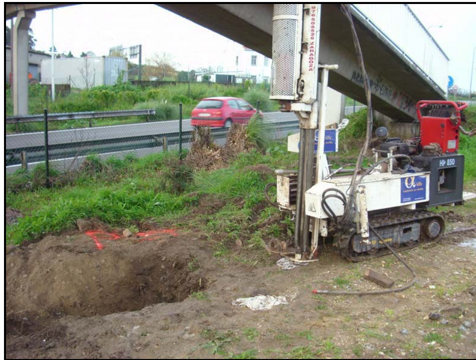
VISTAS PDC-5 (PASARELA PEATONAL ZONA MARISTAS)
