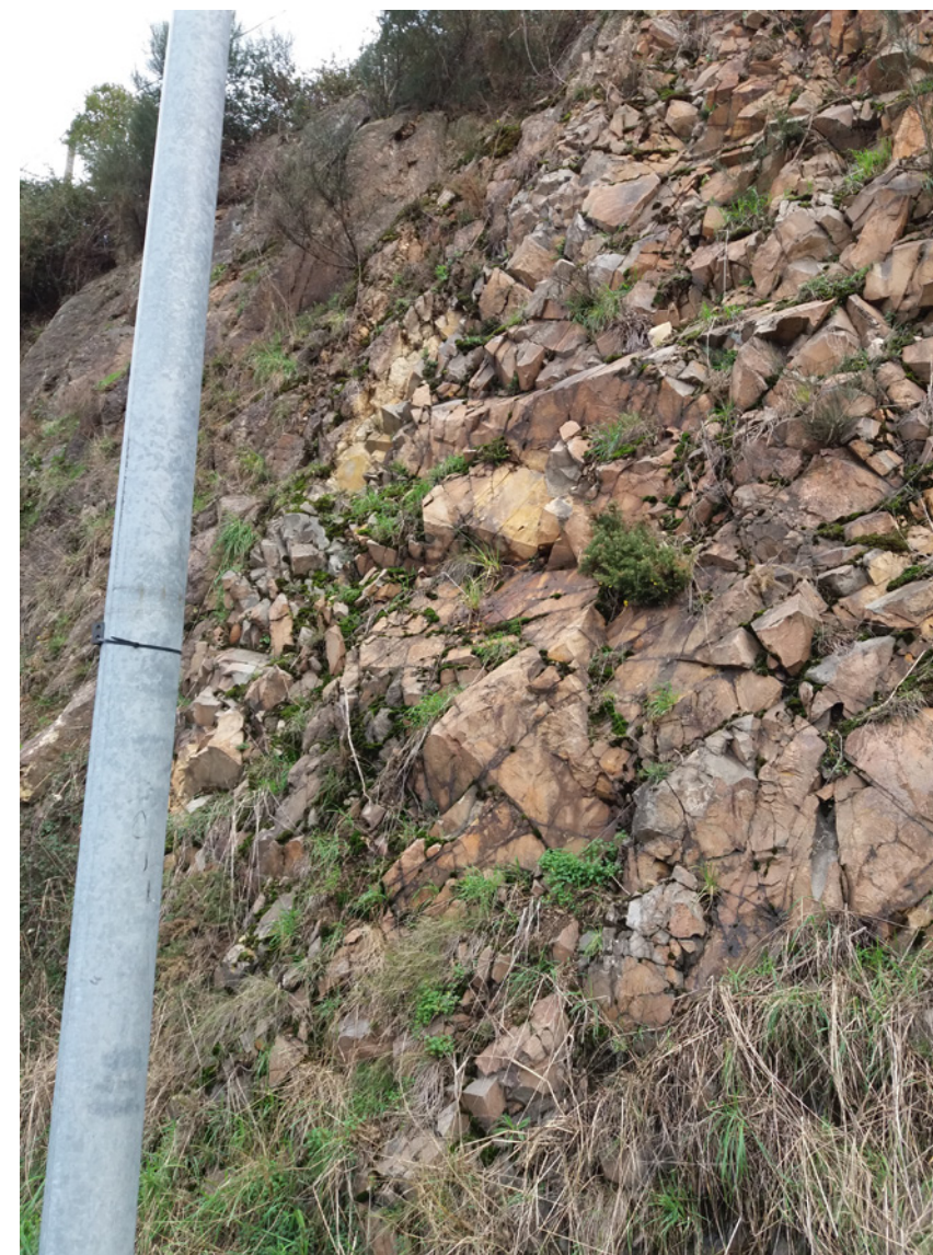
Fotografía 9. Dique de aplita en un desmonte situado hacia el PK1+110 del Eje -11. Obsérvese su aspecto brechoide
