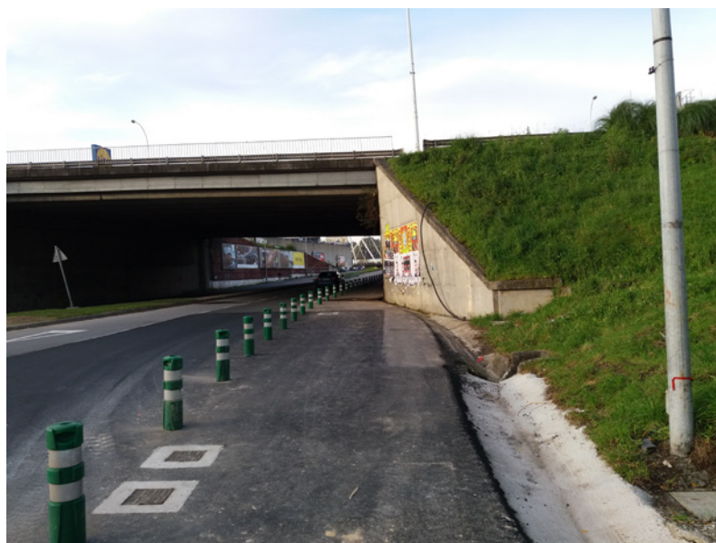
Fotografía 1. Vista panorámica de relleno en el Paso Inferior situado en el PK.1+300 del Eje-11.
