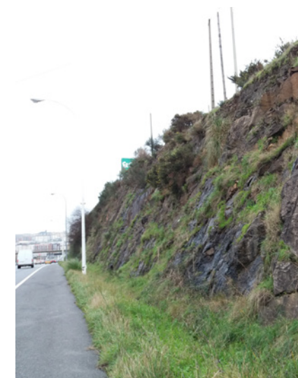
Fotografía 5. Desmonte en la carretera donde se ha realizado la estación geomecánica EG-1.
