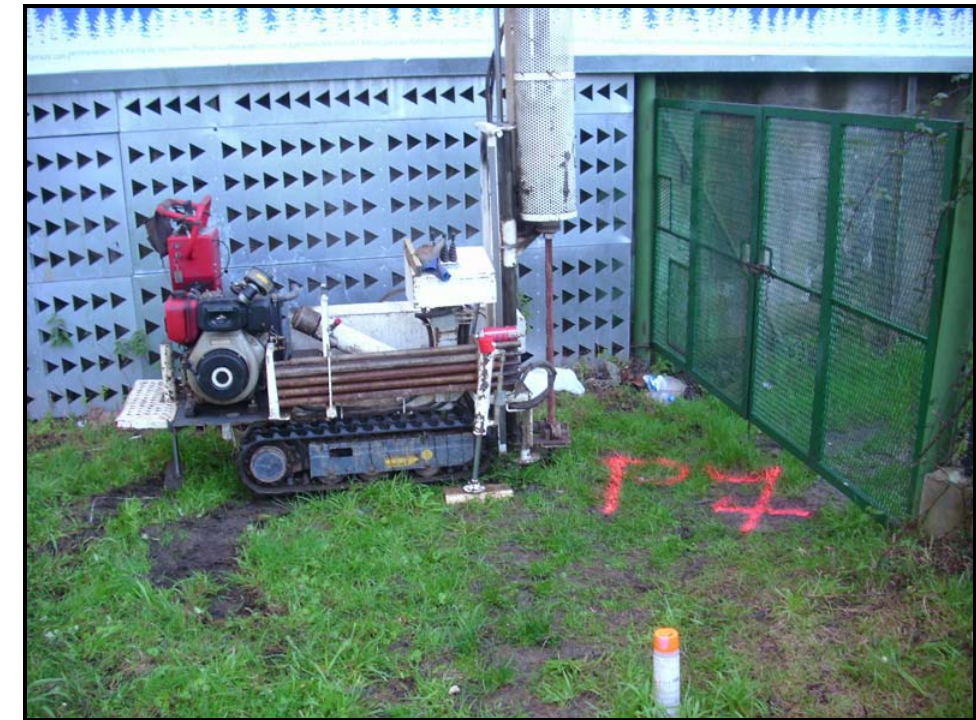
VISTAS PDC-7 (PASARELA PEATONAL DE CONEXIÓN ENTRE LOS NÚCLEOS DE PEDRALONGA Y PALAVEA)
