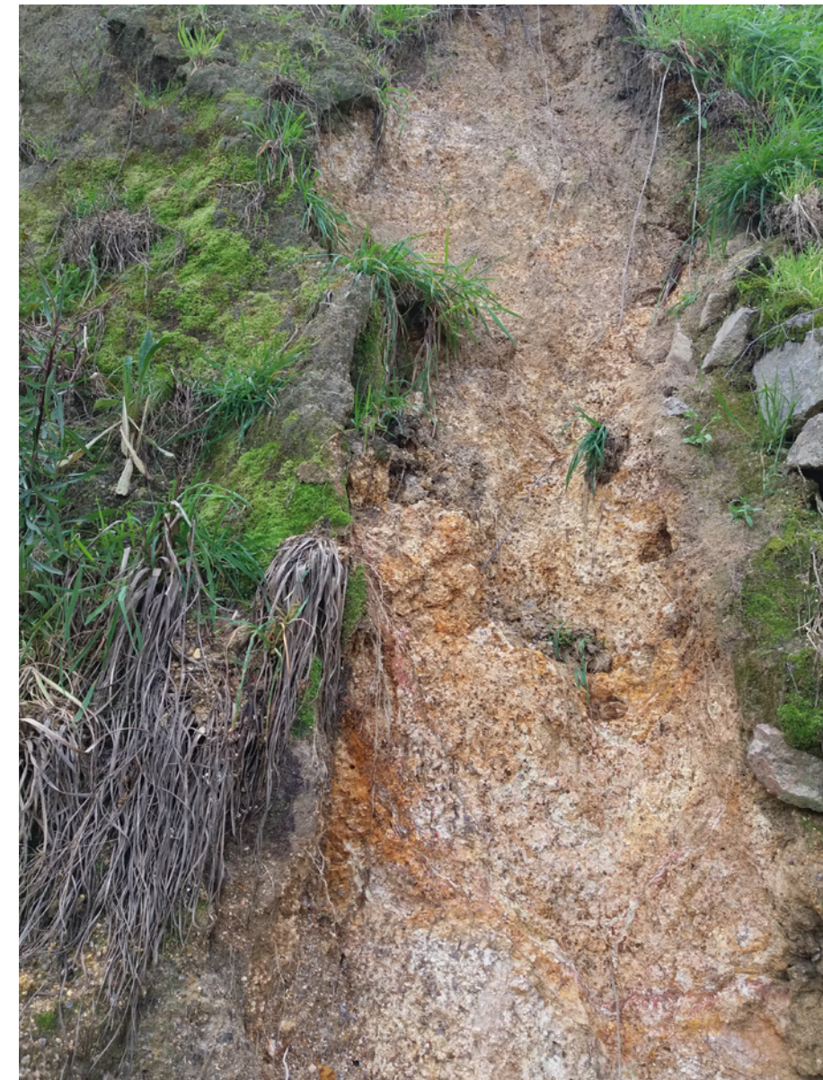
Fotografía 8. Granodioritas alteradas en grado V, Trinchera del ferrocarril.
