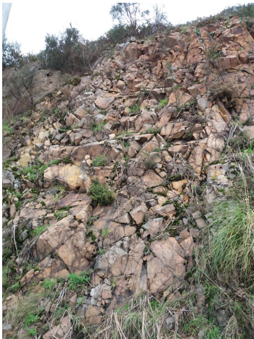
Fotografía 14. Dique de aplita brechificado. Eje 11. PK.1+870
