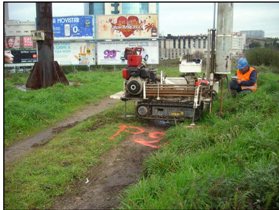
VISTAS PDC-2 (ZONA VÍA DEL TREN, MARGEN MÁS CERCANO A LA CIUDAD DE A CORUÑA)
