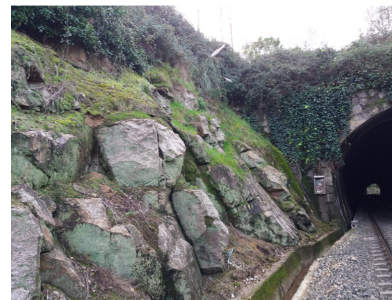
Fotografía 6. Trincheras del paso inferior del ferrocarril donde se ha efectuado la estación geomecánica EG-2
