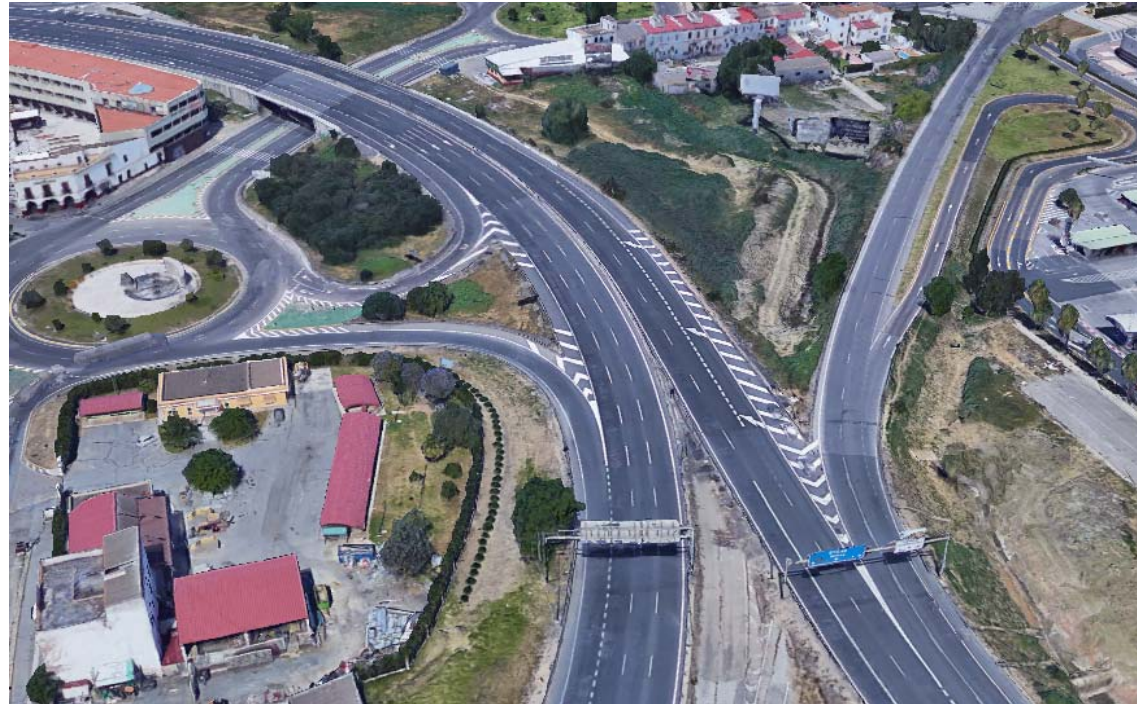
Pérdida de carril en la A-49 sentido Huelva
