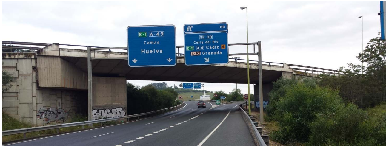
Estructura de paso de la calzada izquierda de la N-630 bajo calzada derecha SE-30
