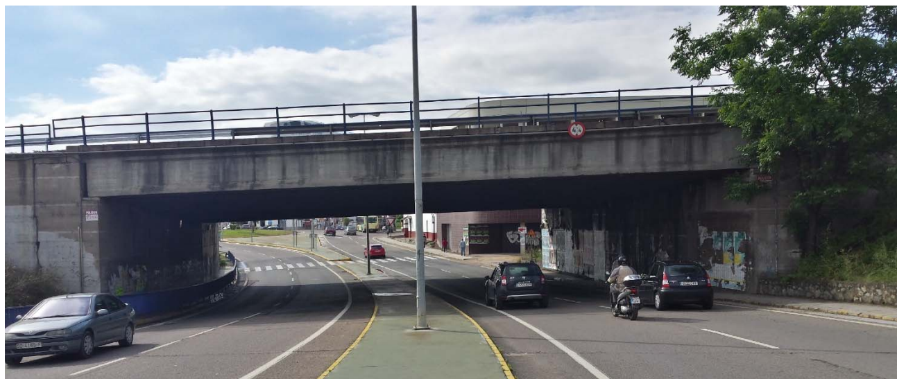
Estructura del Enlace de Camas bajo A-49, vista sentido Pañoleta/Vega del Rey
