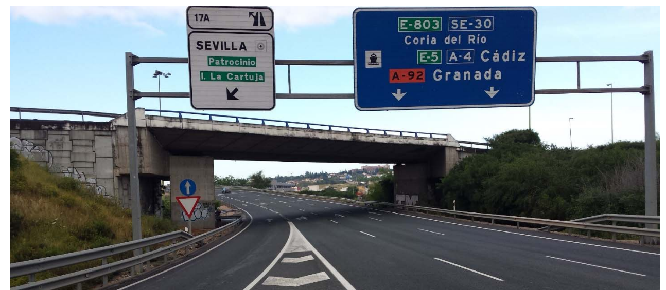
Estructura de paso de la calzada izquierda de la SE-30 bajo calzada izquierda N-630
