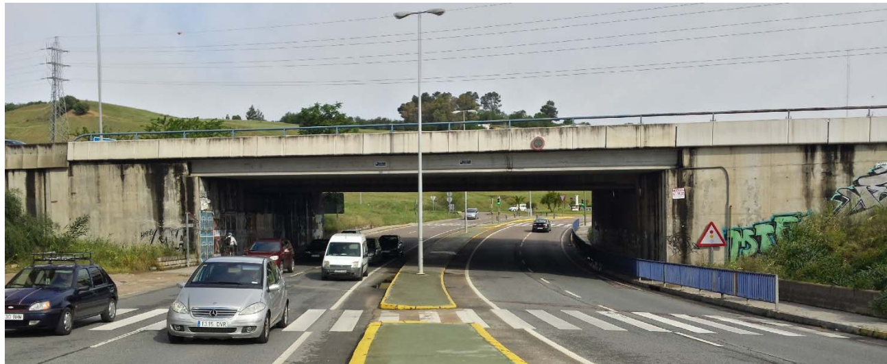
Estructura del Enlace de Camas bajo A-49, vista sentido Camas
