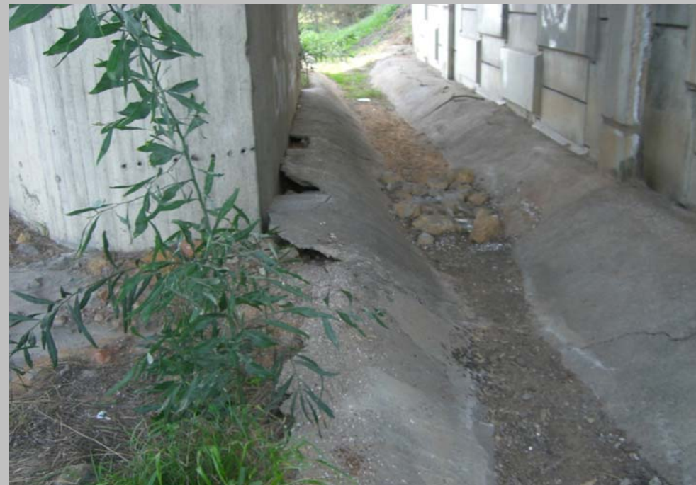
FOTO N° 42. Cuneta revestida de hormigón bajo estructura sobre ramal Sevilla - Huelva. Se afecta y se repone la cuneta.
