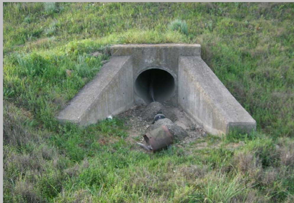
FOTO N° 51. Embocadura en la entrada OTDL 21 con 1 \Phi 800 mm. No se afecta con la actuación.
