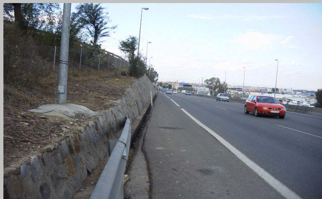
FOTO Nº 5. Cuneta con recubrimiento de hormigón y murete de contención en la A-49.
