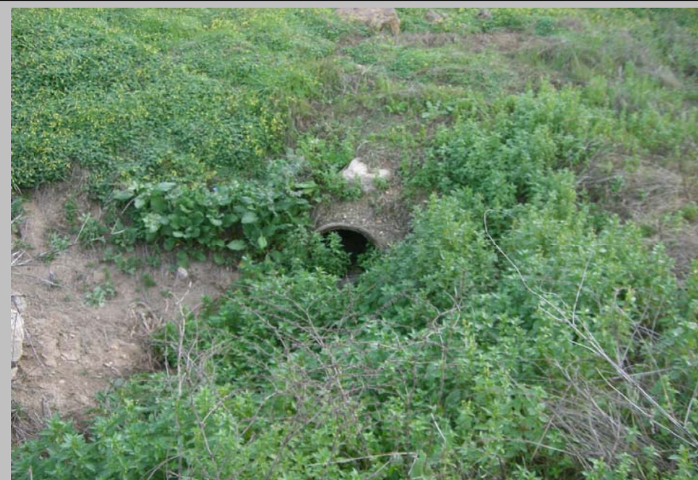
FOTO N° 35. Entrada OTDL 20 de 1 Φ 600 mm para la evacuación del interior del enlace. No se afecta con la actuación.
