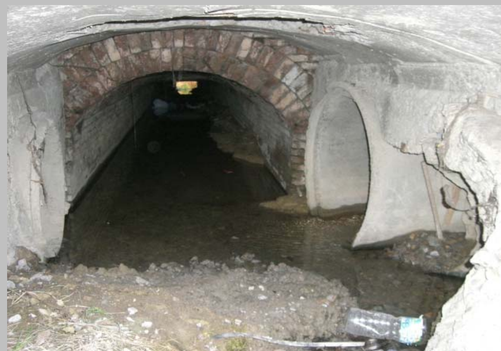
FOTO N° 26. ODT 3 Bóveda de 1500 x 900 mm con entrada de las ODT 1.1 y OTDL 6 de 1 \Phi 600 mm y 2 \Phi 800 mm en la glorieta 1 (Camas). No se afectan.
