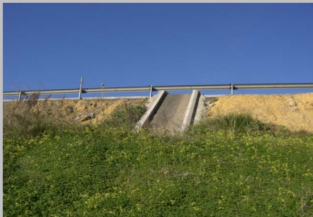
FOTO N° 19. Bajante en la A-49
