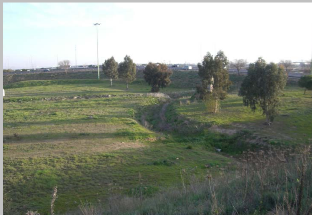
FOTO N° 41. Cuneta revestida de hormigón pie de terraplén en la margen de la SE-30 (sentido Mérida - Cádiz). Se afecta con la solución, se define la reposición.
