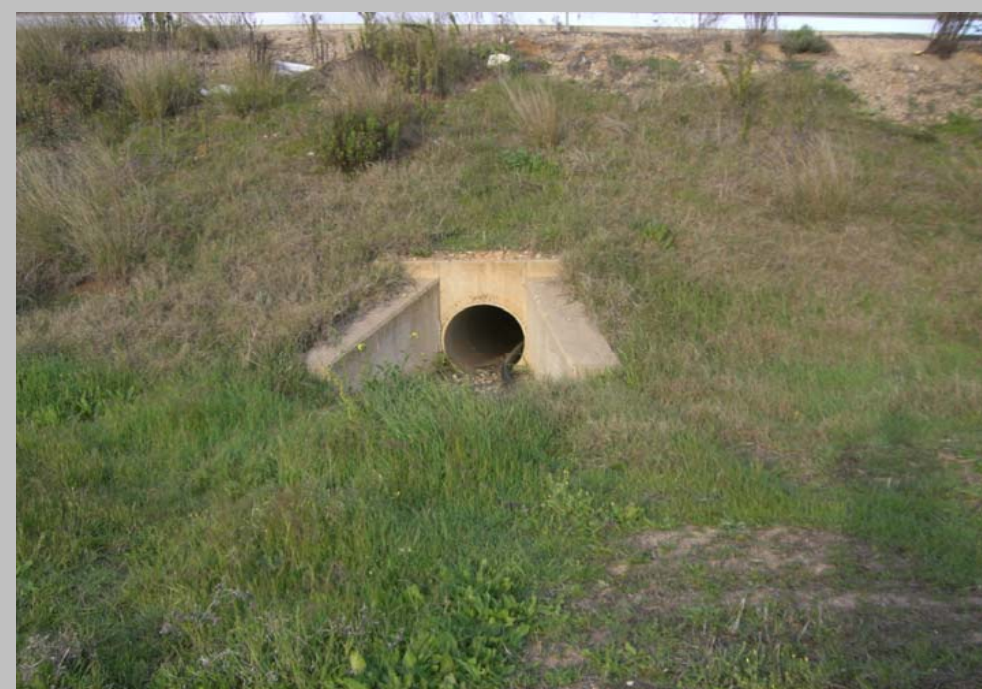
FOTO N° 48, Embocadura en salida OTDL 14 con 1 \Phi 800 mm. Se mantiene la misma modificando el elemento de entrada (arqueta)
