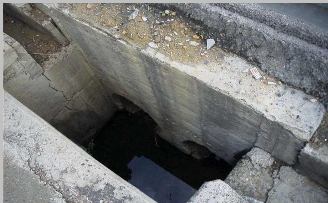
FOTO N° 3. Arqueta de 0,75 x 2,50 m en la entrada de la OTDL 1 de 2 tubos \Phi 800 mm bajo la A-49.
