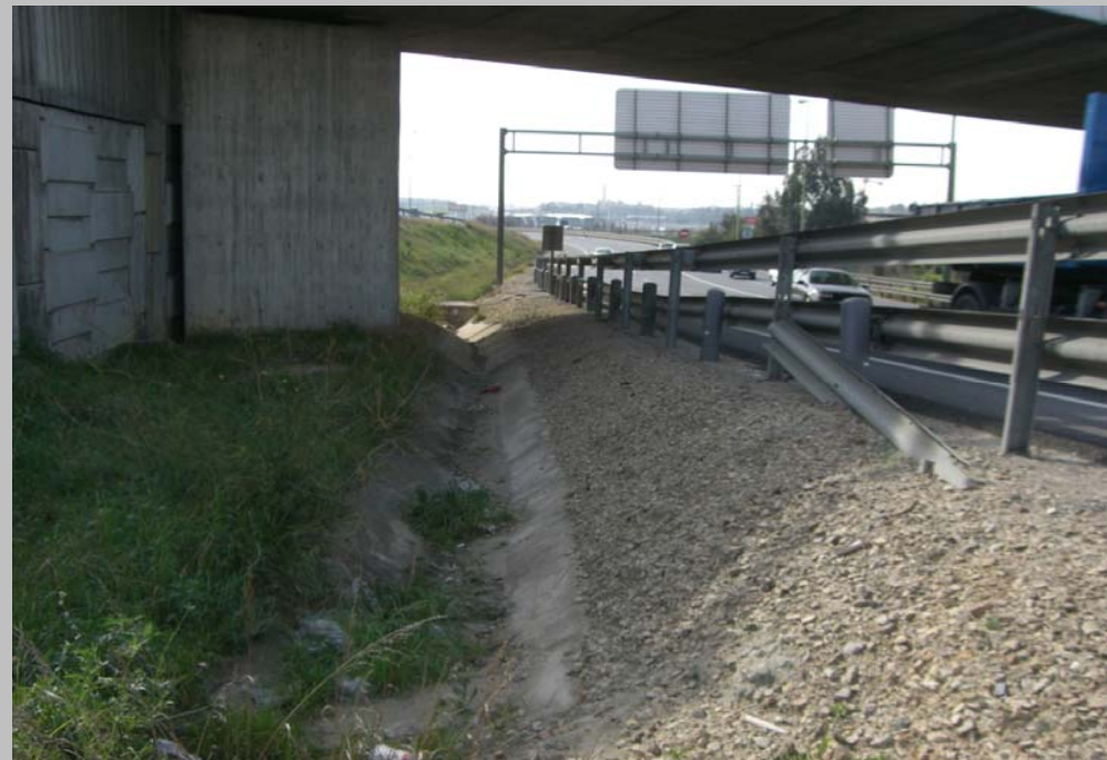
FOTO N° 41. Cuneta revestida de hormigón pie de terraplén en la margen de la SE-30 (sentido Mérida - Cádiz). Se afecta con la solución, se define la reposición.
