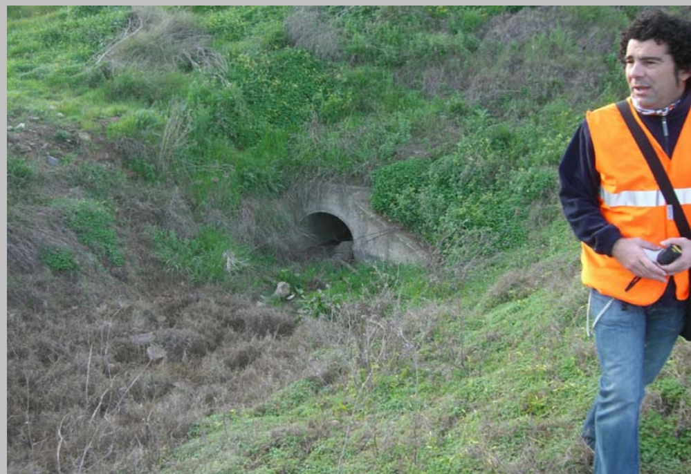
FOTO N° 45. Embocadura en salida OTDL 19 con 1 \Phi 1000 mm. bajo el ramal Huelva - Sevilla del enlace. No se afecta con la actuacion.
