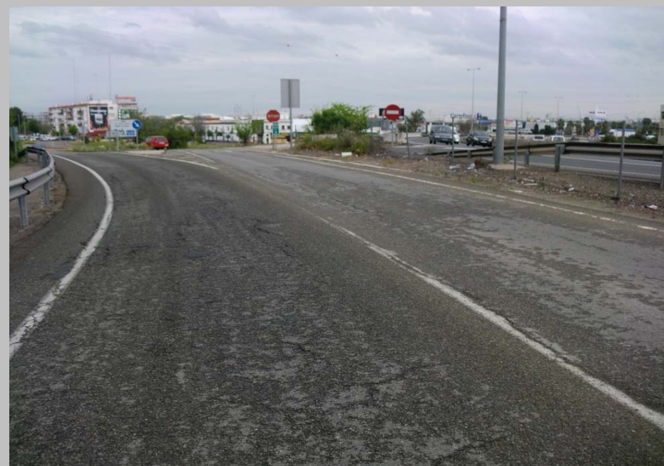
FOTO N° 18. Zona de conexión de ODTL nueva a la ODTL 4 existente. de 2 tubos \Phi 600 mm.
