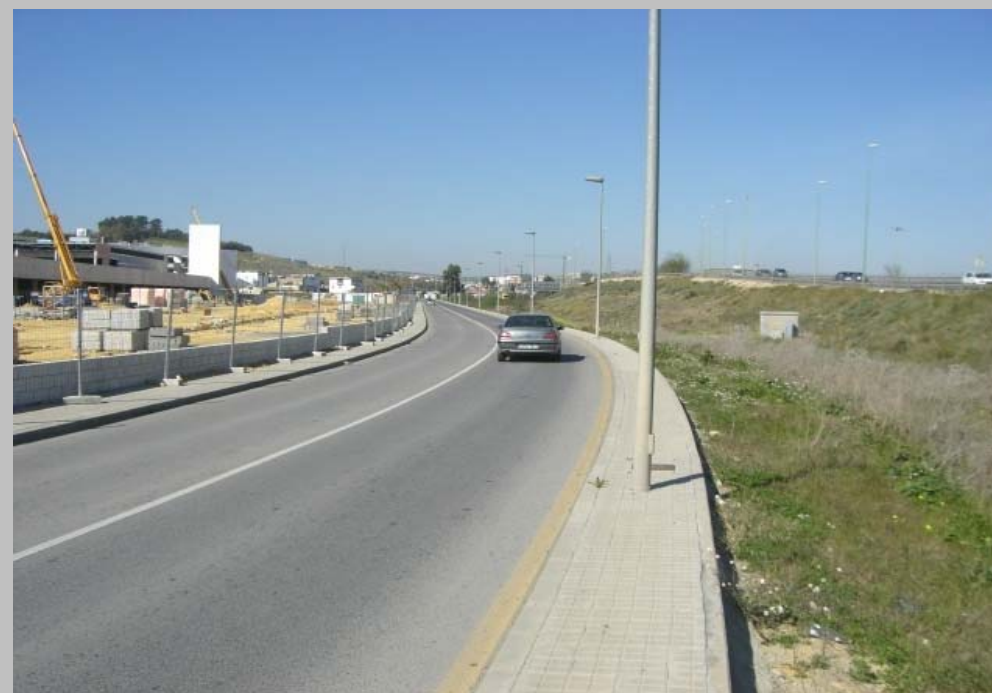
FOTO N° 58. Margen de la SE-30 (Mérida - Cádiz) y junto vial urbano sin cunetas.
