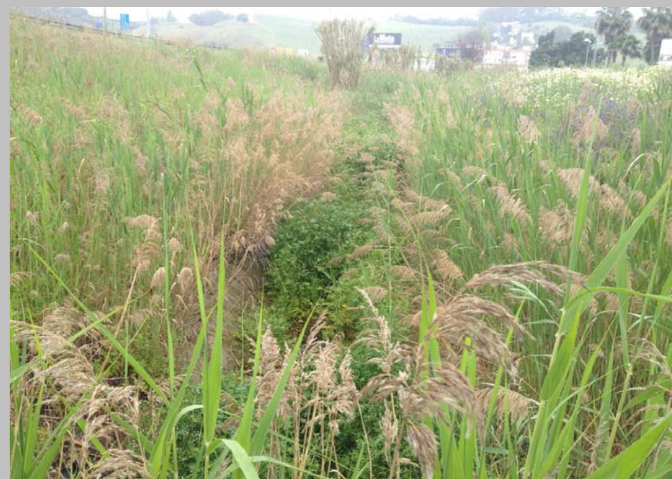
FOTO N° 32. Sección encauzada dando continuidad a la ODT 4 junto a la A-49.
