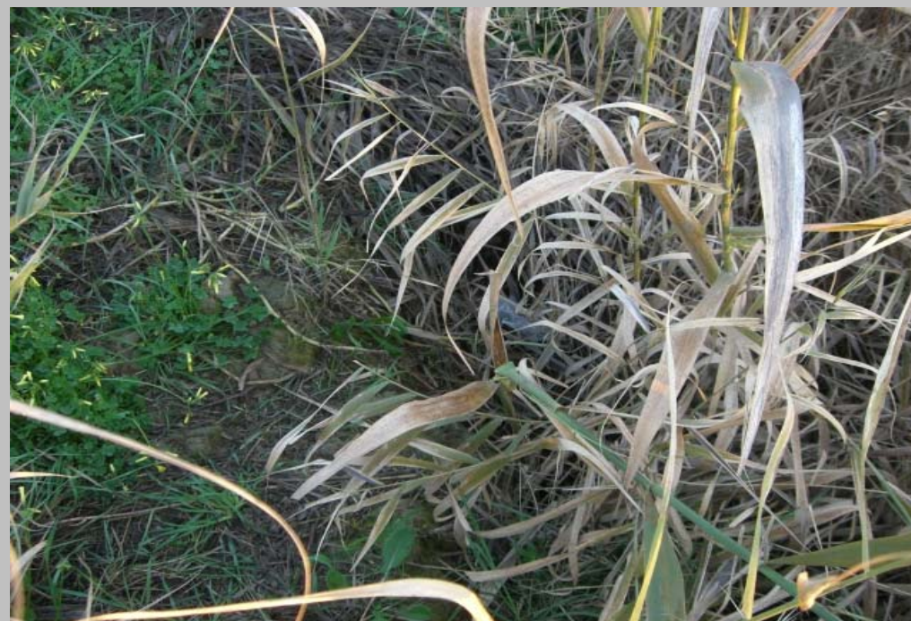
FOTO N° 22. Entrada de la ODT1 cubierta de vegetación de 1 Ø 1000 mm bajo la crta. A-474. No se afecta con la actuación.
