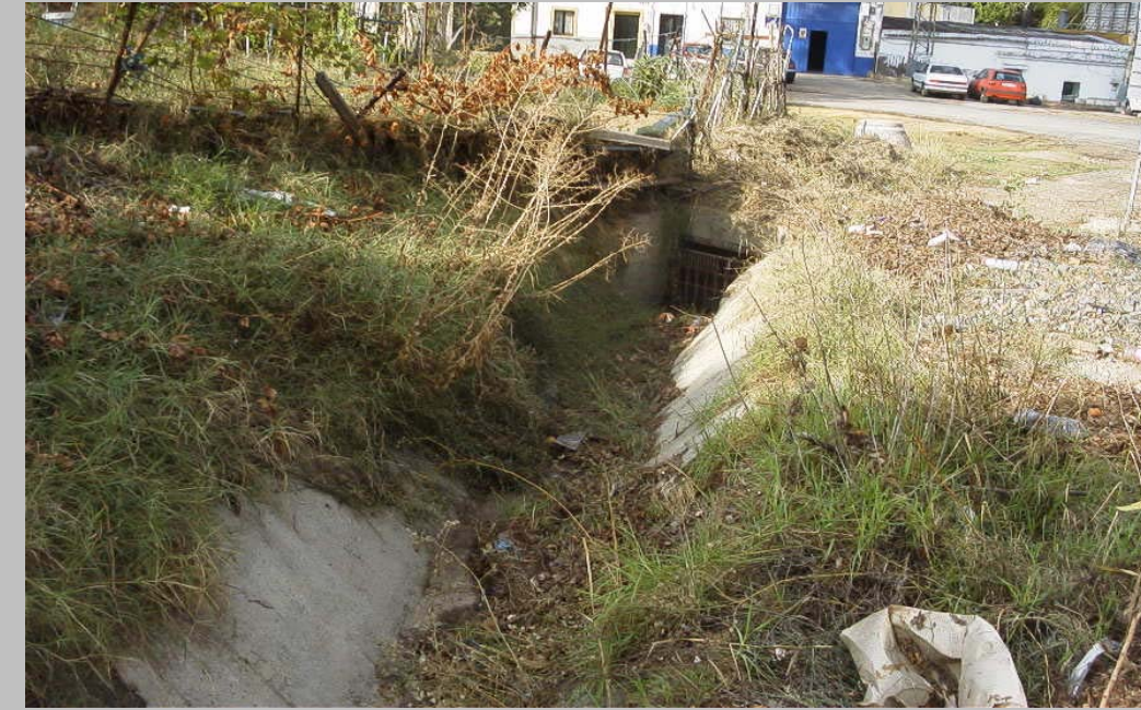
FOTO N° 16. Entrada de la cuneta de la A-474 en la OTDL 4. 2 DN 600mm
