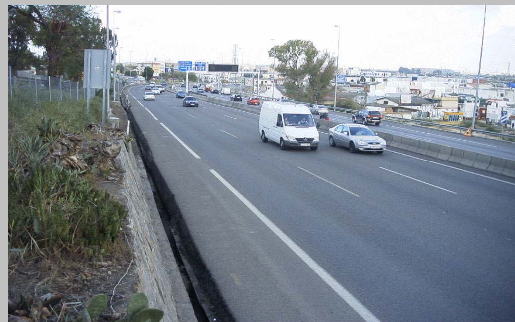
FOTO Nº 6. Cuneta con recubrimiento de hormigón Zona donde finaliza la ampliación de calzada.
