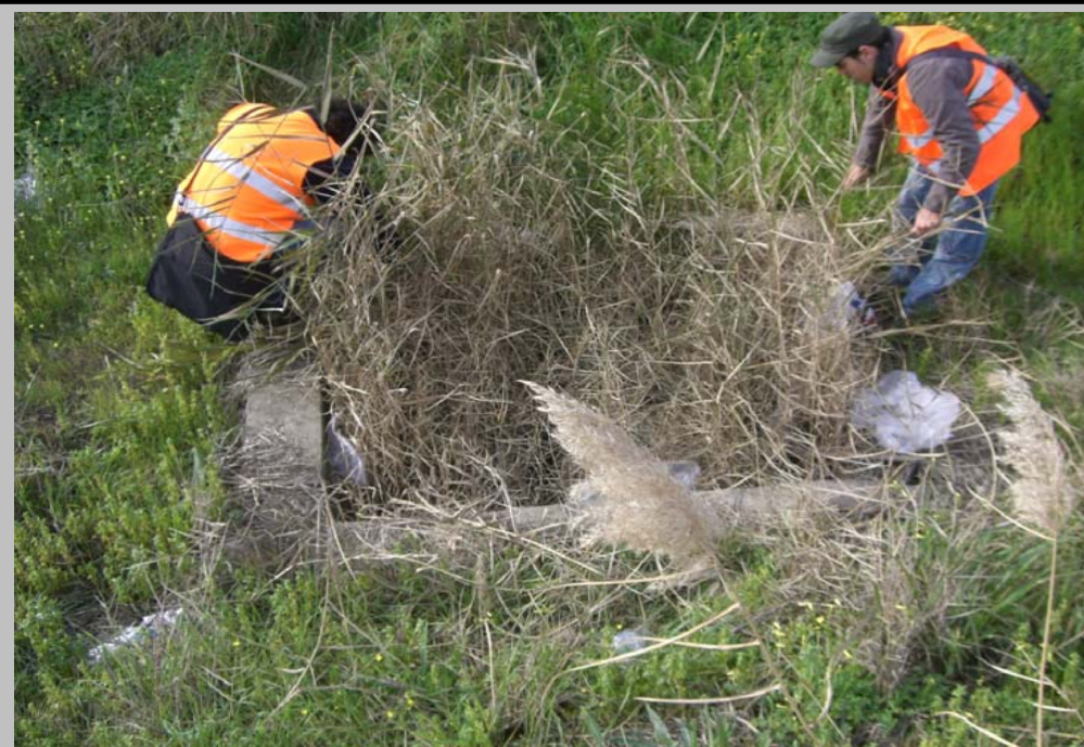
FOTO N° 31. Arqueta en la salida de la ODT 4 con 2 tubos \Phi 800 mm bajo ramal de salida a Camas desde la SE-30
