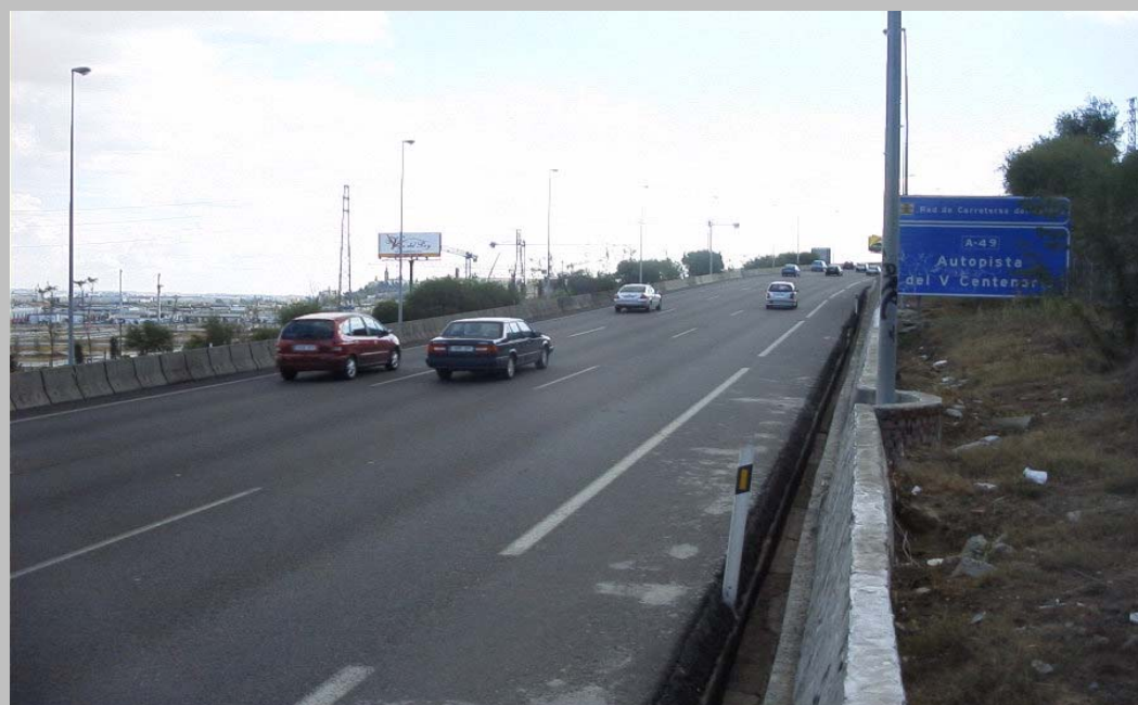
FOTO N° 1. Cuneta con recubrimiento de hormigón y murete de contención en la A-49.
