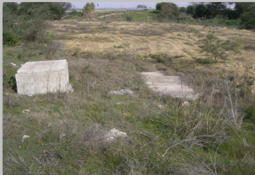
FOTO N° 39. Arqueta de conexión de OTDL 22 y OTDL 23. Ambas OTDL se mantienen en la solución.
