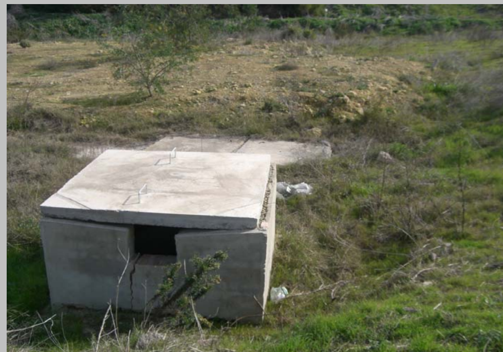
FOTO N° 40. Arqueta de pluviales sobre OTDL 22 para integración. de pluviales del interior del enlace. Se mantiene el uso de la misma.
