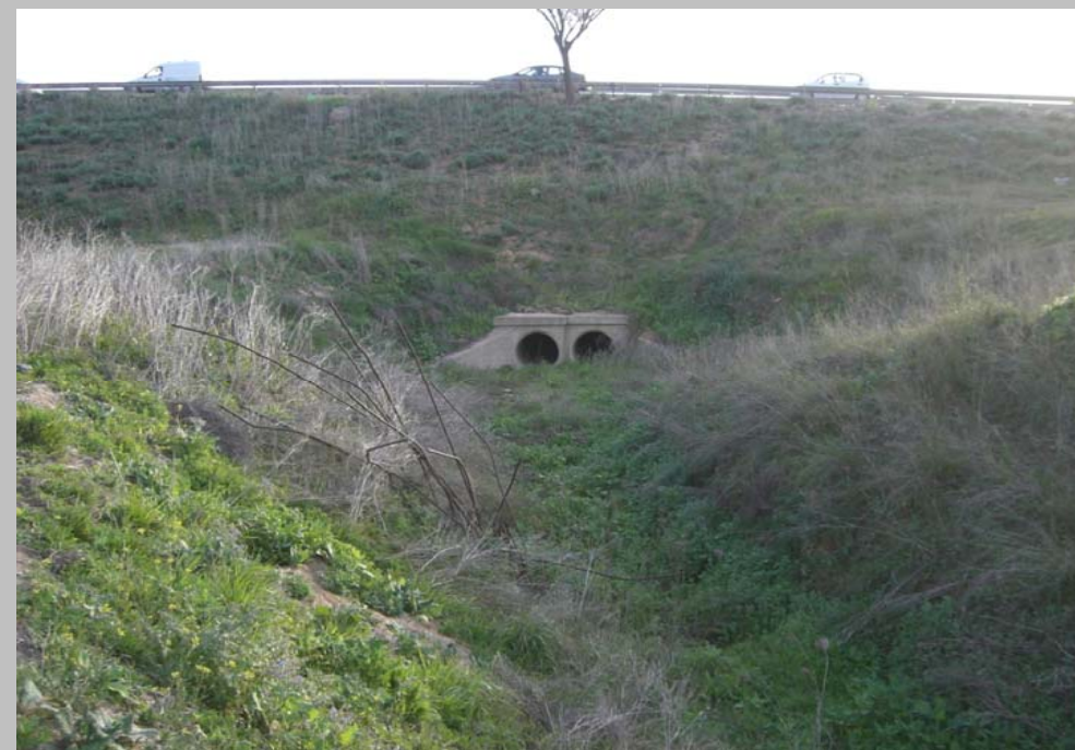
FOTO N° 44. Embocadura en la entrada OTDL 22 con 2 \Phi 1200 mm. bajo la SE-30 (Cadiz - Mérida).
