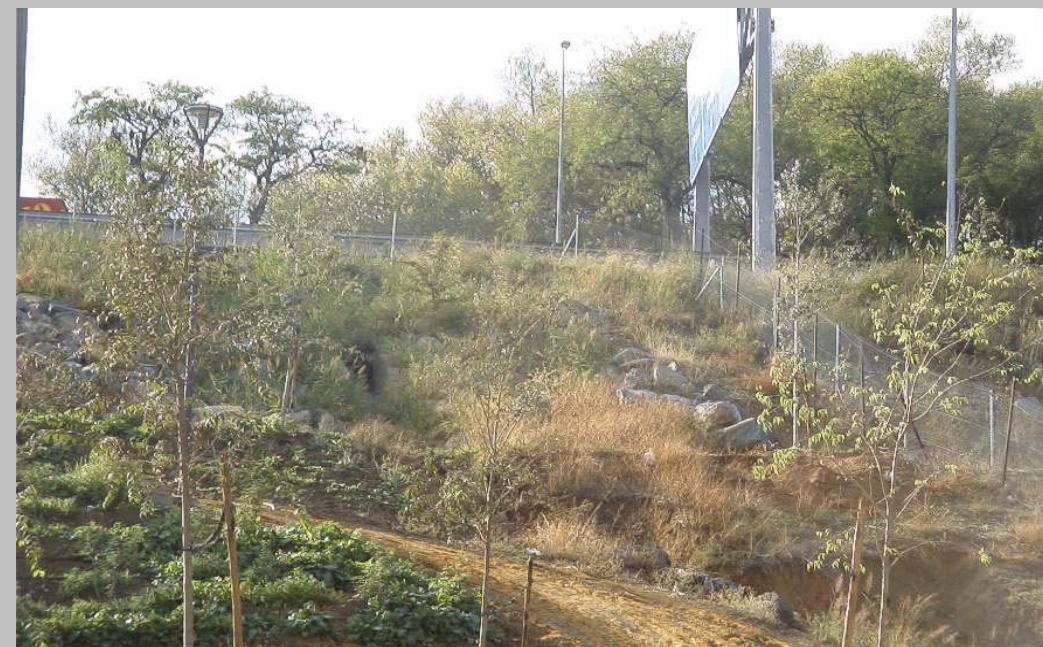
FOTO N° 4. Embocadura en la salida de la OTDL de 2 tubos \Phi 800 mm bajo la A-49.
