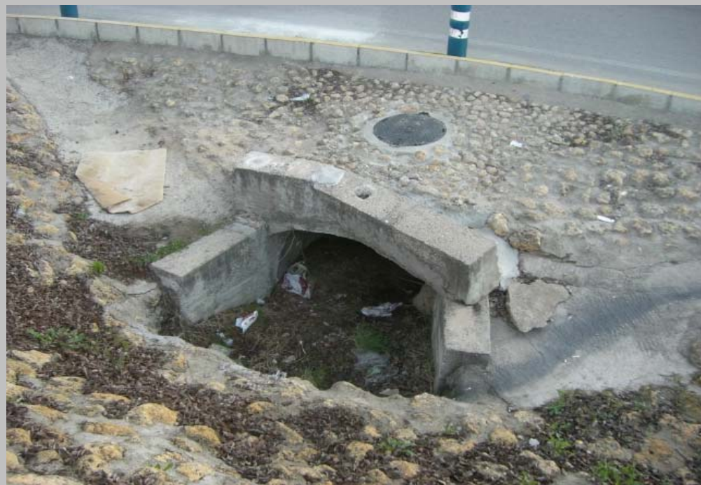
FOTO N° 25. Embocadura en la entrada de la ODT 3 en la glorieta 1 (Camas). No se afecta.
