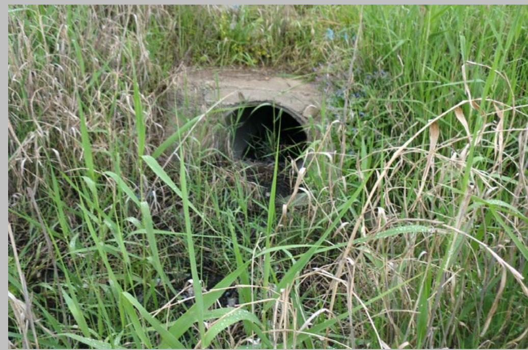
FOTO N° 54. Embocadura en salida OTDL 10 con 1 \Phi 800 mm. Se afecta con el ramal Huelva -Cádiz. Se define la prolongación de la misma.
