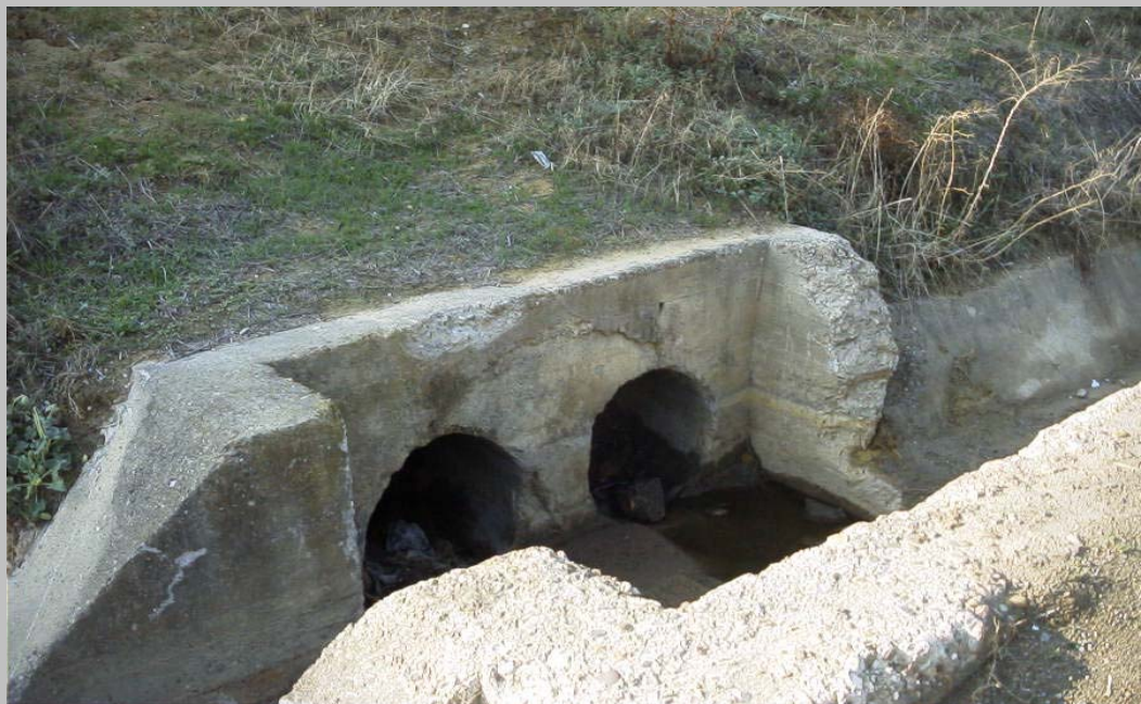
FOTO N° 11. Embocadura en la salida de la OTDL 2. Se mantiene.
