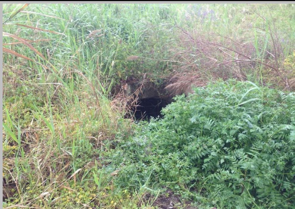
FOTO N° 33. Entrada en ODT 5 que conduce la escorrentía hacia su vertido No se afecta por la actuación.
