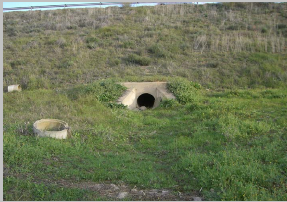
FOTO N°50. Embocadura en salida OTDL 21 con 1 \Phi 800 mm. No se afecta con la actuación.
