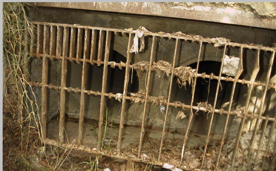
FOTO N° 17. Embocadura con rejillas en la entrada de la ODTL 4 de 2 tubos \Phi 600 mm.
