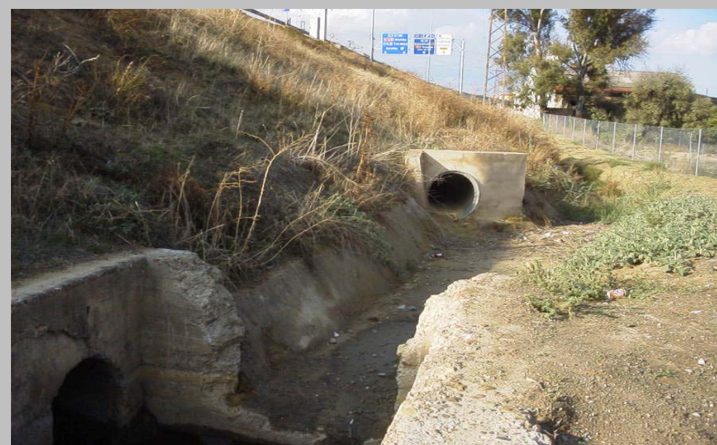
FOTO N° 12. Embocaduras en las salidas de la OTDL 2 y de OTDL existente. La OTDL no se afecta con la actuación.
