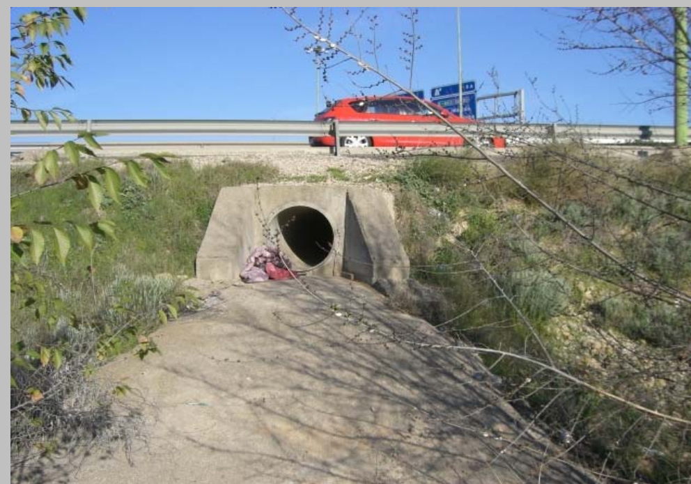
FOTO N° 56. Embocadura en salida OTDL 16 con 1 \Phi 800 mm. bajo el ramal Huelva - Cádiz del enlace. No se afecta con la actuación
