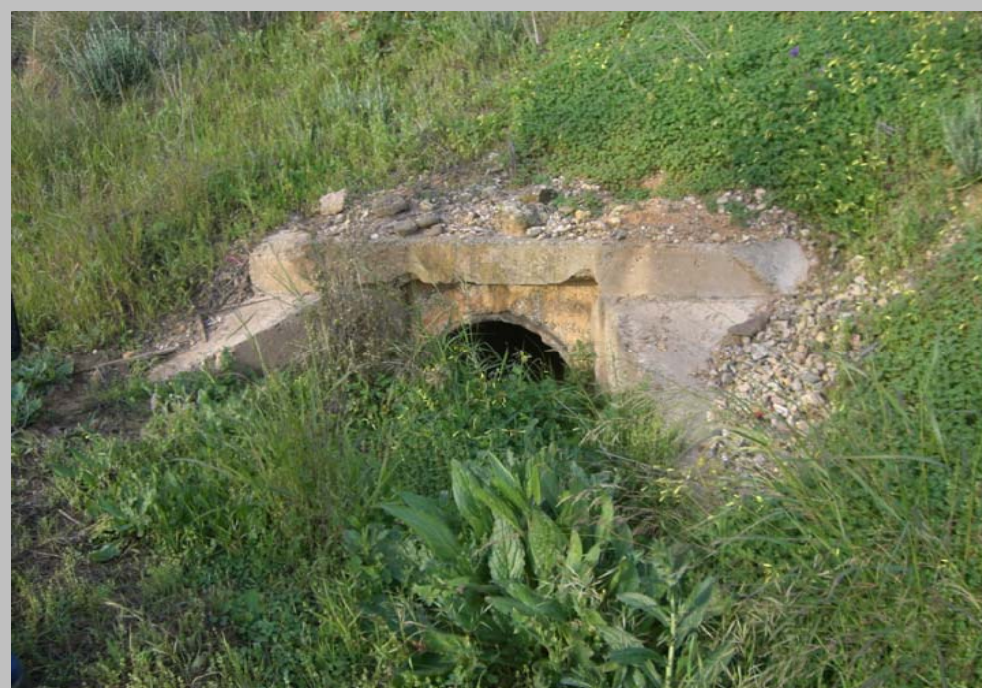
FOTO N° 52. Embocadura en salida OTDL 15 con 1 \Phi 600 mm. bajo la SE-30 (Mérida - Cádiz) y el ramal Sevilla - Cádiz del enlace. No se afecta con la actuación
