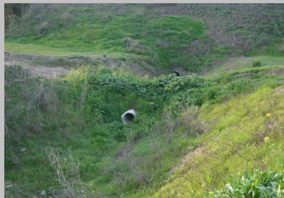
FOTO N° 46. Encauzamiento y embocadura en salida OTDL 19 con 1 \Phi 1000 mm. No se afecta
