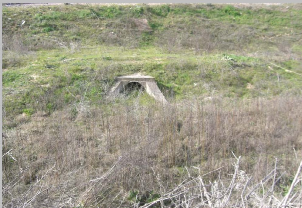
FOTO N° 37. Embocadura en la salida de la OTDL 24 de 1 \Phi 800 mm No se afecta con la solución proyectada
