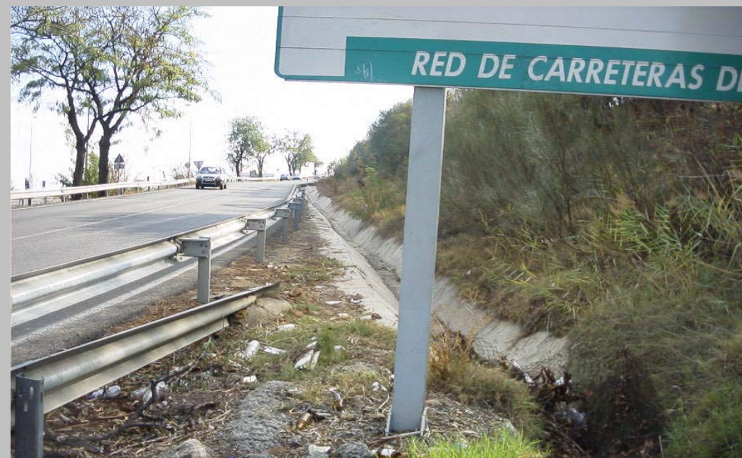
FOTO N° 15. Cuneta con recubrimiento de hormigón en la crta. A-474.
