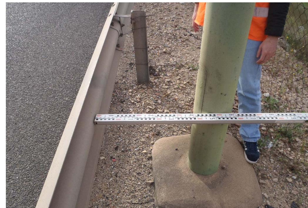
Separación entre barrera existente y báculo de iluminación.
