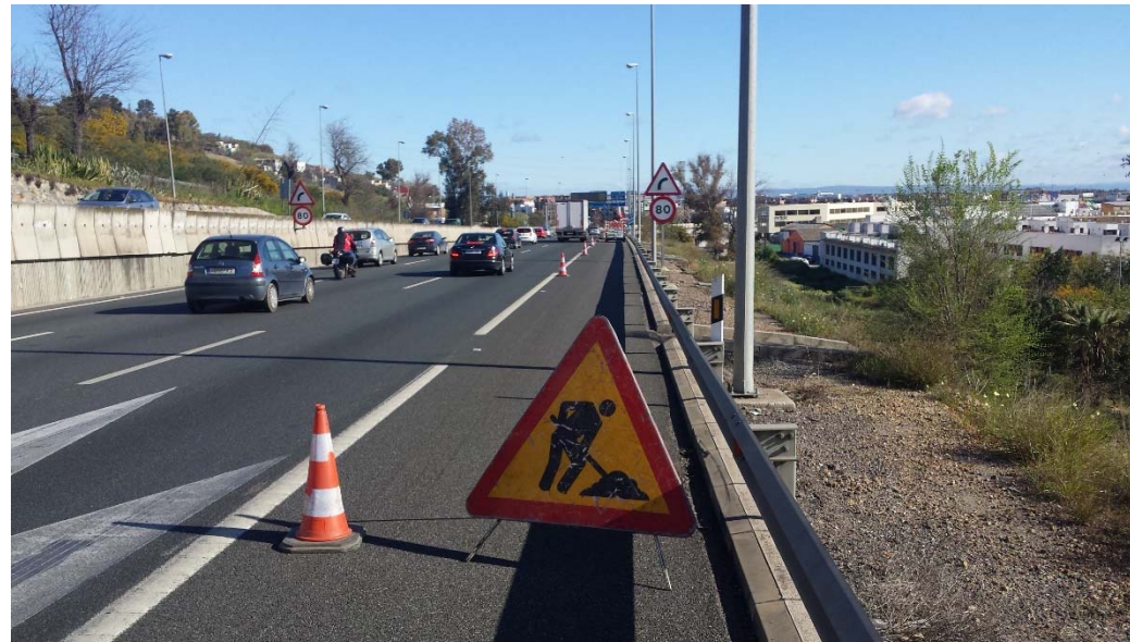
Separación entre barrera existente y báculo de iluminación.
