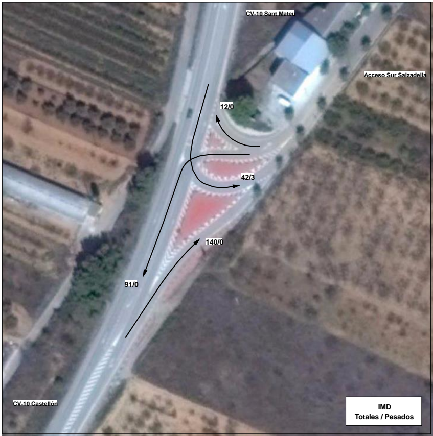
AF 10. Intersección de CV-10 con acceso Sur a Salzadella (IMD)
