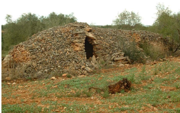
Elemento T4. P.K. 21+500. Caseta refugio
