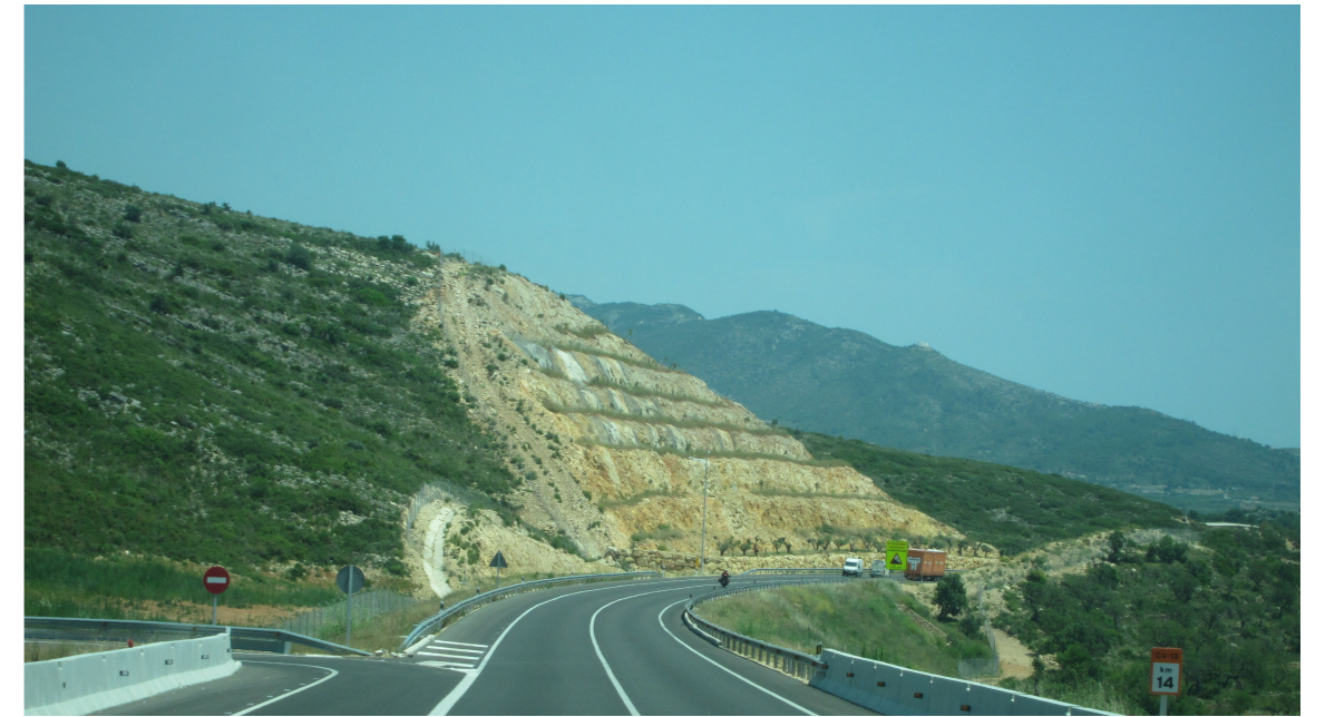
CV-13, Taludes en desmorte con medidas correctoras, enero 2017
