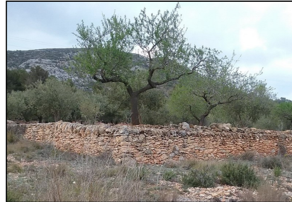
Muros de piedra en seco formando abanalamientos. Sant Mateu.
