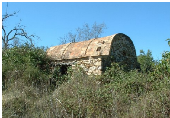
Elemento D5. P.K. 5+270. Caseta de Volta
