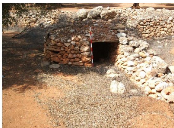
Elemento AM1. P.K. 41+700. Caseta.
