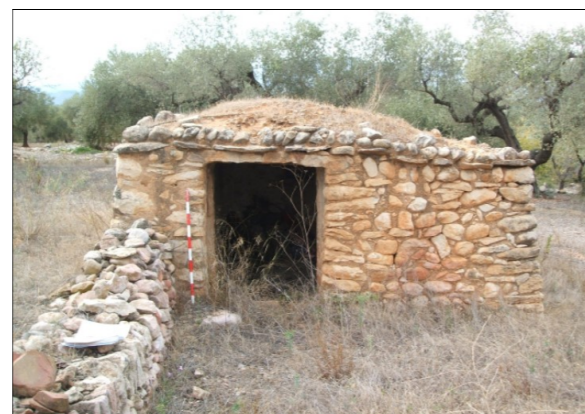
Elemento AM8. P.K. 40+710. Caseta.
