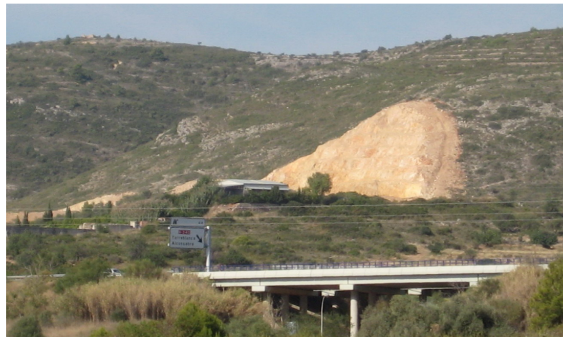
CV-13, Taludes en desmorte sin medidas correctoras, octubre 2010
