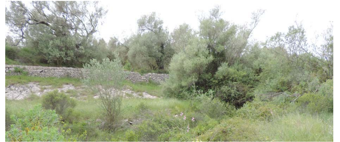
180. Escollera: Coord. UTM 31T 258346 4482725
