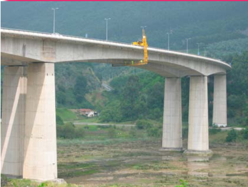
Inspección del viaducto de Orión (2008), construido con el método de avance en voladizo.
