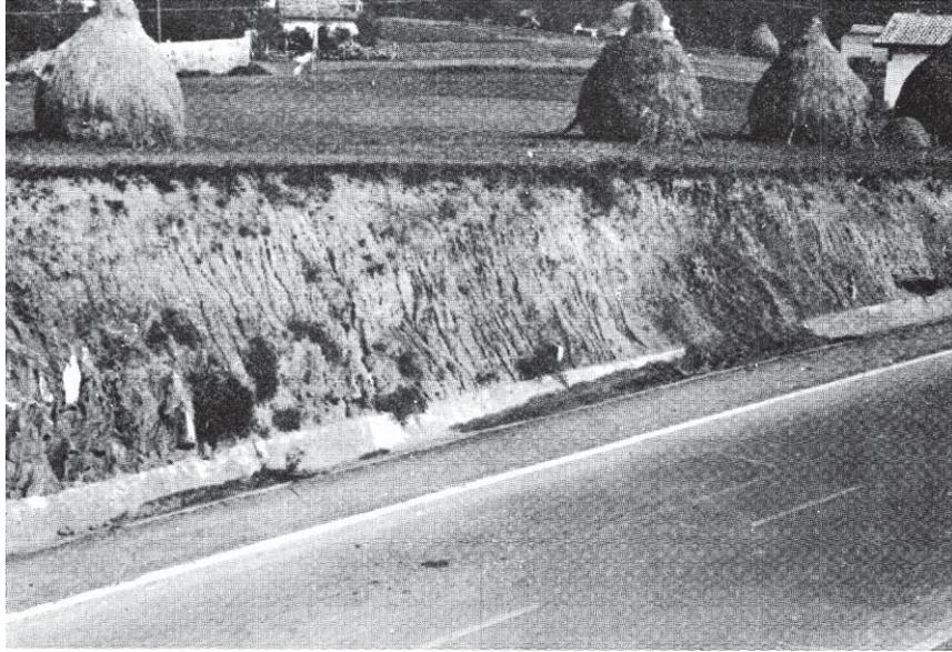
Foto 8.- Coluvial limoso sobre calizas del Complejo de Blas en el talud de la carretera de acceso al Aeropuerto de Asturias.
