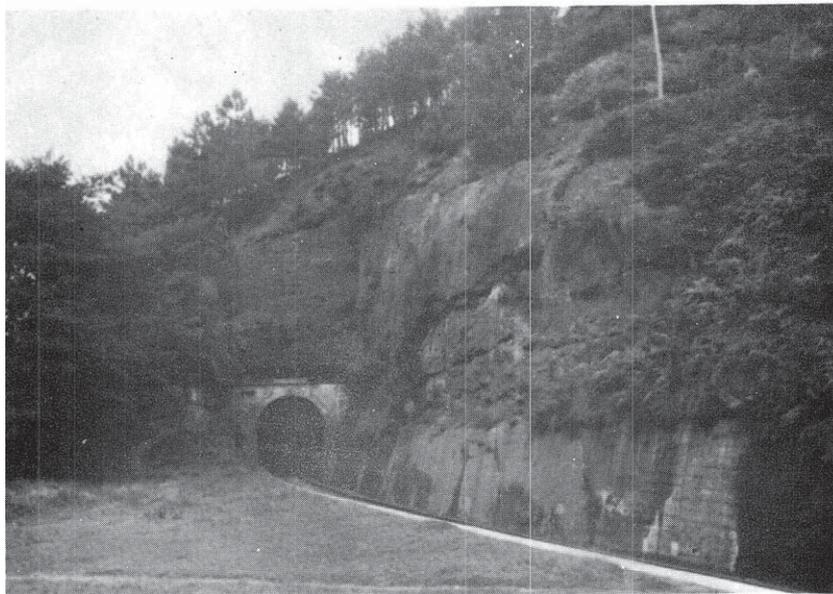
**Foto 23.-** Aspecto del Conglomerado Fabuda en el Apeadero de Salinas del ferrocarril, El Ferrol del Caudillo-Gijón. En la parte superior Conglomerado Fabuda compacto, con paredes casi verticales. Debajo la zona basal más blanda, con intercalaciones de arcillas rojas. El muro está construido en el Triás.
