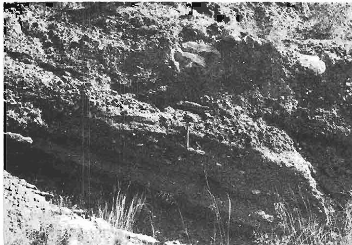
Foto 42.- Textura y estructura de la formación mio-pliocena correspondiente al grupo geotécnico 36a. Fotografía tomada cerca de la rambla de Cabrera en la Hoja 974-2.(107H-21).
