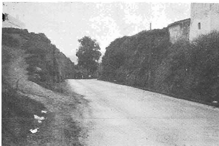
Foto 17.- Taludes artificiales de gran irregularidad, acarreados, excavados en la litofacies roja, arcillo-areniscosa del Complejo Maláguide (grupos 0Mf y 0Mg).
