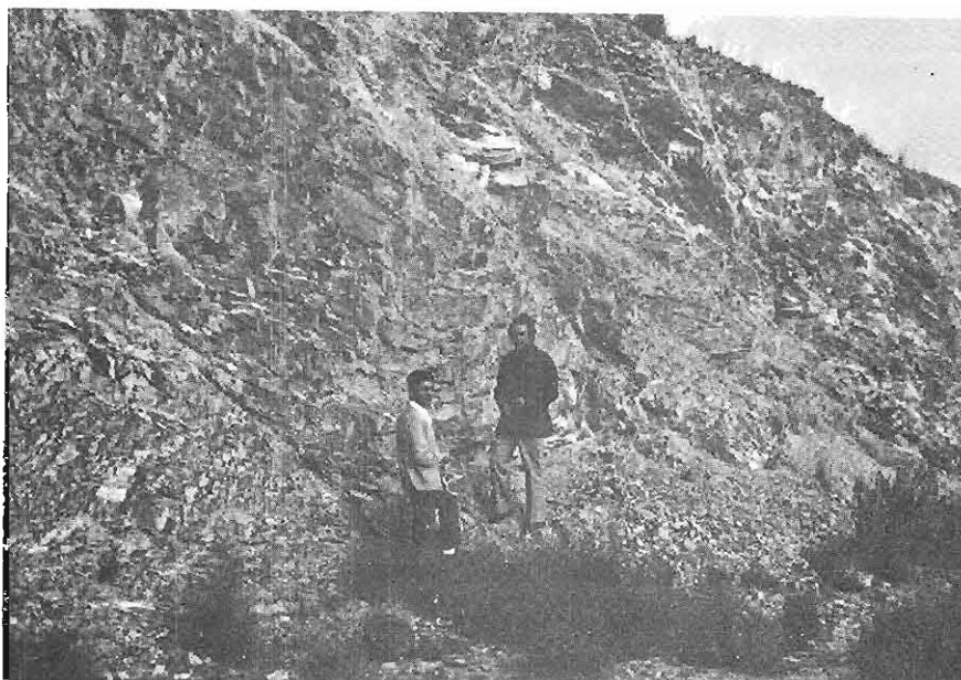
Foto 30.- Detalle de una estructura imbricada puesta de manifiesto en un talud vertical excavado en las filitas del "C. Alpujárride". Obsérvese el núcleo de un anticlinal tumbado e "hincado" en la masa filitosa, afectada por múltiples fallas inversas, con dispositivos cabalgantes de sentido contrario al de avance del pliegue. Obsérvese, asimismo, el estado de erosión del talud pese a su reciente construcción. Hoja 974.-I.
