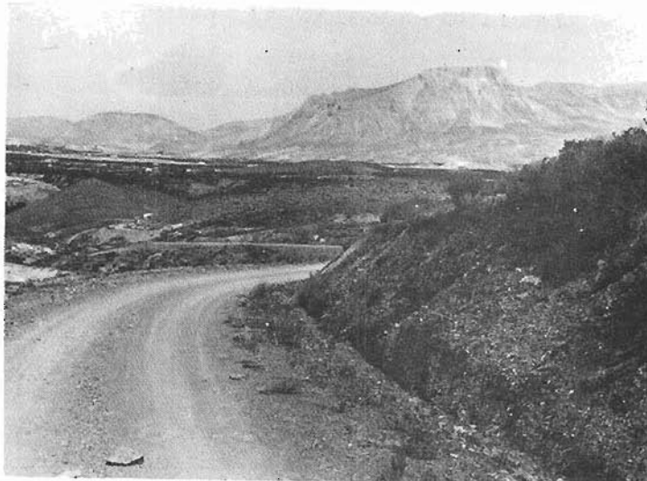
Foto 18.- Taludes en los grupos 0Md (en primer término) y 0Me (en el plano intermedio). Al fondo morfología y taludes rectilíneos de la falda de La Muela (24a) sobre la que se apoyan potentes formaciones de pie de monte, cementadas y asurcadas por una red paralela y profunda de torrentes. Hoja 974-4 (104H-21).
