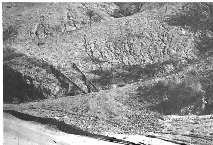
Foto 34.- Huellas de pequeños deslizamientos ocurridos en los micaesquistos del grupo 0Ab "alpujárride". Carretera de Vélez-Rubio a Sta. María de Nieva. Hoja 974-2. (107H-19).
