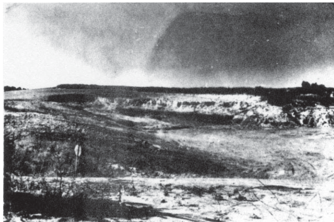
Deslizamiento del puerto Onitar P. K, 390 de la C. N. 323.
