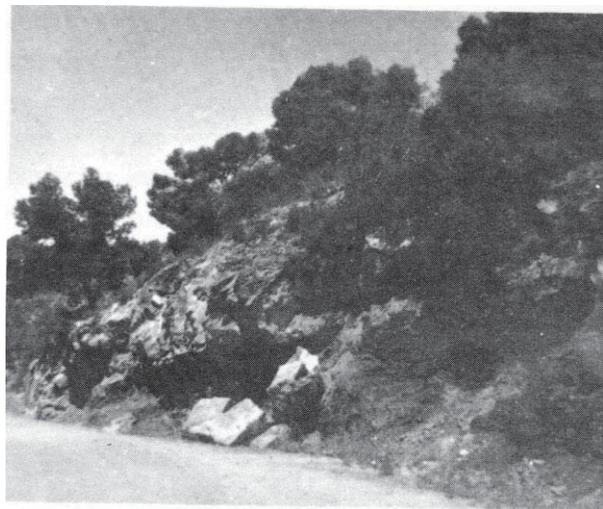
Geotecnia.- Aparte de las caídas de hincos por descalces locales, el material no produce otros problemas. Pueden utilizarse, sin problemas, como cimiento de obras de fábrica una vez eliminado el débil aluvial que lo cubre. Drenaje aceptable; no ripable.
