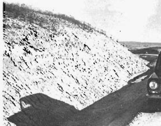
Foto 34.— Taludes inestables en las capas margo-arenosas del Paleógeno de La Hinojosa—Cervera del Llano. Grupo 30b. (100H—62).
