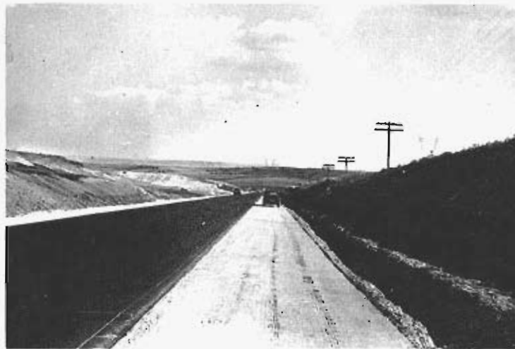
Foto 35.— Taludes artificiales en el Terciario yesífero-calcareo rojo de Castillo de Garcimuñoz. Grupo 30c. Hoja 690-4 (100H-52).
