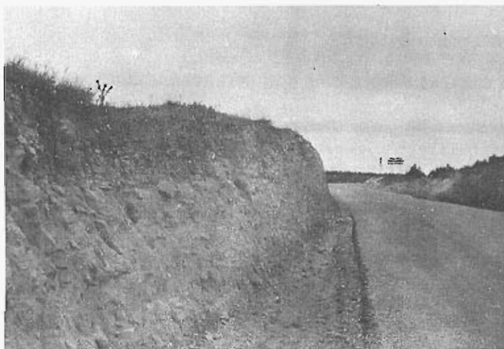
Foto 21.— Trinchera de la Crta. Madrid—Alicante (km 308,50). Niveles de arcillas y margas con gravas, aprovechable como préstamo.
