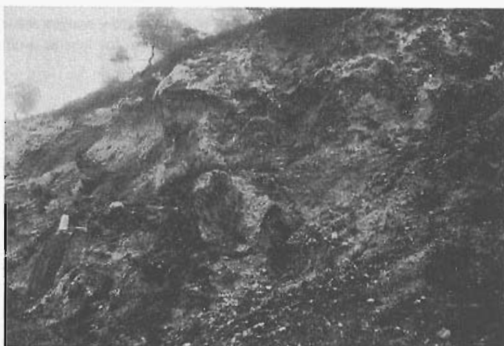
Foto 7.— Puerto de Almansa. Caída de bloques por descalzamiento de niveles calizos (27 b).
