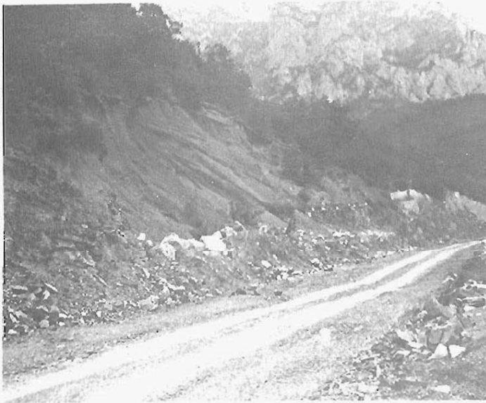
Foto 3.23.— Suelo inestable en las pizarras carboníferas. (151)
