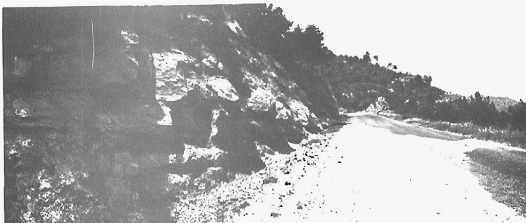
Foto 3.29.— Talud vertical sobre el grupo 313.
