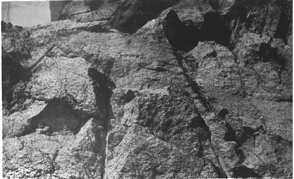
Foto 3.— Granito sano del grupo O11a. Pueden verse las huellas de los barrenos empleados en la voladura para realizar la explanación de la carretera N-525.
