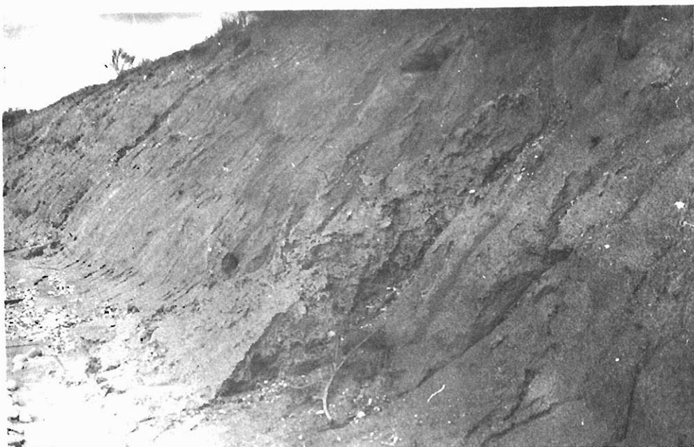
Foto 25.— Detalle del Olla de Sapo alterado, en un talud de la carretera N-525 donde, debido a la excesiva pendiente con que éste se construyó, se han producido deslizamientos. (Grupo  $c_1 + v_1/113b$ ).
