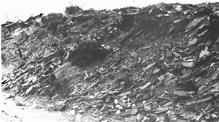
Foto 24.- Talud en pizarras del Llandeiliense fracturadas, con desprendimientos de lajas (grupo 122).
