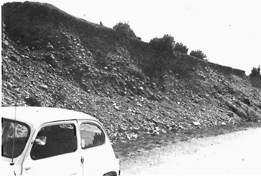
Foto 7.— Aspecto de un talud excavado en las terrazas del río Veral.
