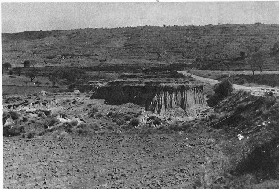
Foto 26.— Abarrancamientos típicos en los suelos limosos en la carretera de Huesca a Apiés.
