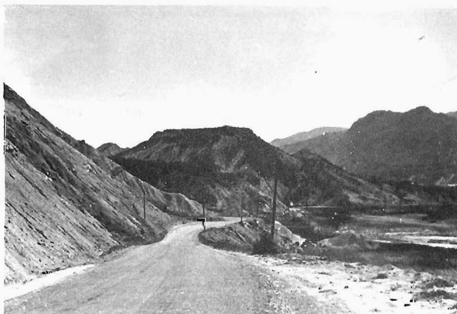
Foto 20.— Talud natural estable (1/2) sobre margas azules eocenas en la carretera de Triste a Anzanigo.
