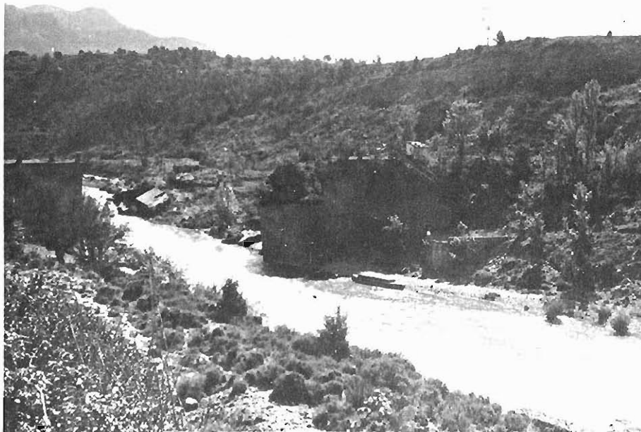
Foto 27.— Socavación del río Gállego aguas abajo del pueblo de Murillo de Gállego.
