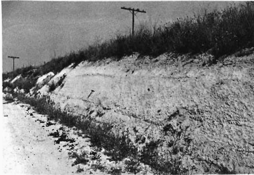
Foto 21.— Vista general del desmonte en la carretera de desviación a Torralba de Oropesa desde la carretera N-V, realizado en las margocalizas con nódulos calcáreos (321 c).
