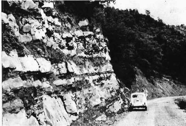
Fig. 55. Talud del grupo 312h2 al norte de Troncedo.
