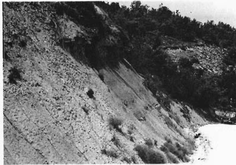
Fig. 50. Margas arcillosas del grupo 312d1 en la carretera local de Castigalen
