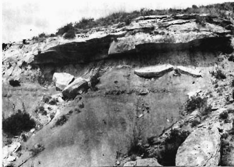
Fig. 53. Descalces de bancos areniscosos sobre margas arcillosas (312f3)
