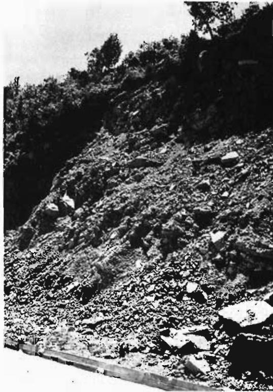
Fig. 71. Coluvión C1 al NO del cuadrante 312-3, en la variante de la C a comarcal 138, que se está construyendo desde Morillo de Tou a Ainsa por causa de la elevación del nivel del pantano de Mediano
