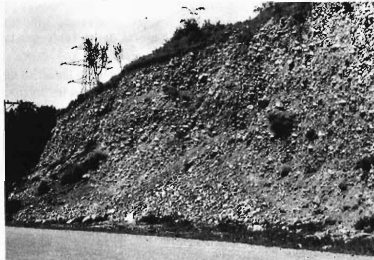
Fig. 68. Terresa del río Ribagorzana, pk. 107,5 C a N 230
