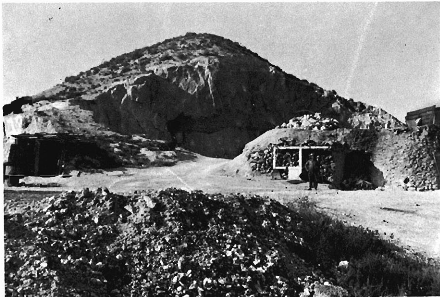
Fot. 36. Yesera en el Cerrillo Blanco, a la altura del P.K. 153 de la C.N. 340, de Almería a Murcia.
