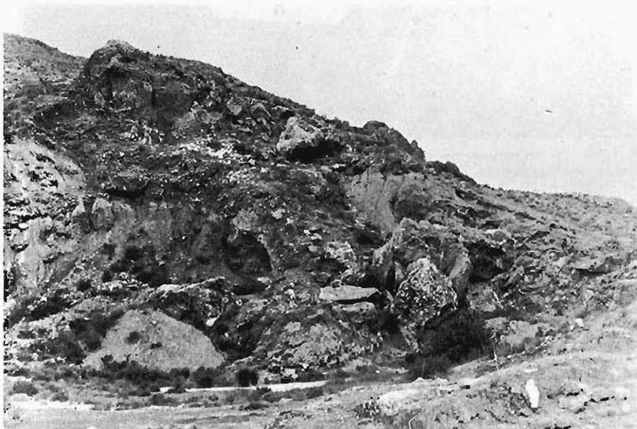
Fot. 34. Deslizamientos de bloques de dolomías y filitas sobre la masa de yesos subyacentes. (P.K. 219 de la carretera N-340.)
