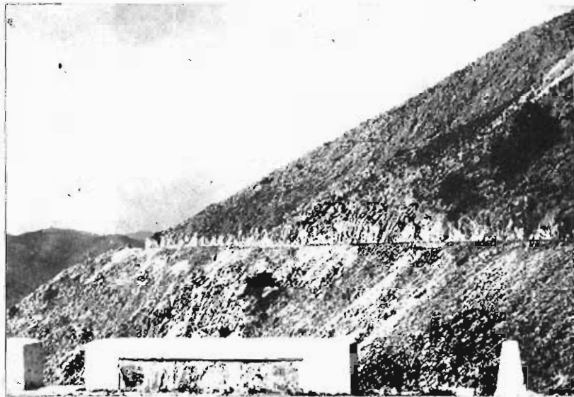
Foto 75.— Taludes en las calizas del grupo 220 b
