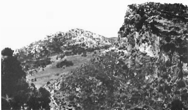
Foto 73.— Aspecto de los taludes en el grupo 220 c.
