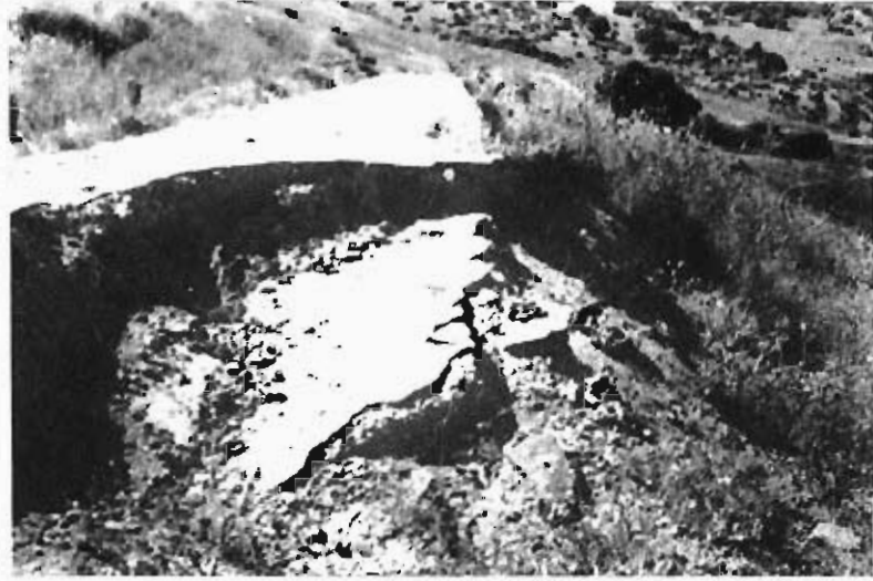
Foto 11.— Concha de deslizamiento en el grupo 321 a.
