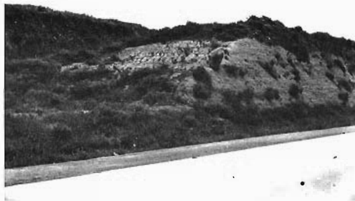
Foto 16. Taludes en el grupo 313 b.
