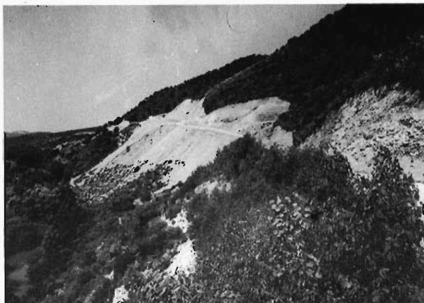
Foto 31. Taludes artificiales en el Grupo 230. Ctra. de Benaolan a Cortes de la frontera.
