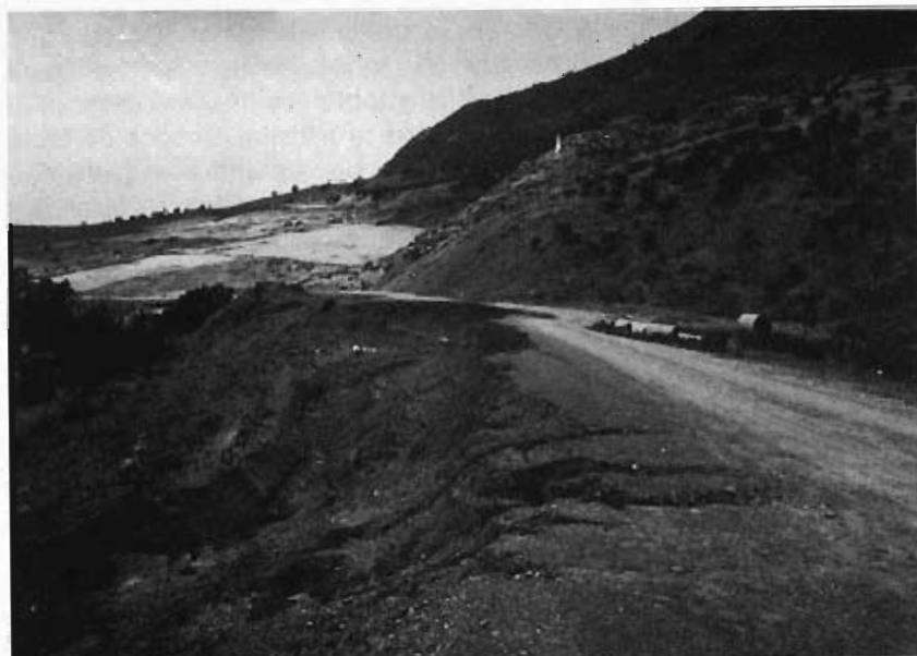
Foto 16. Deslizamiento en el grupo 312a.
