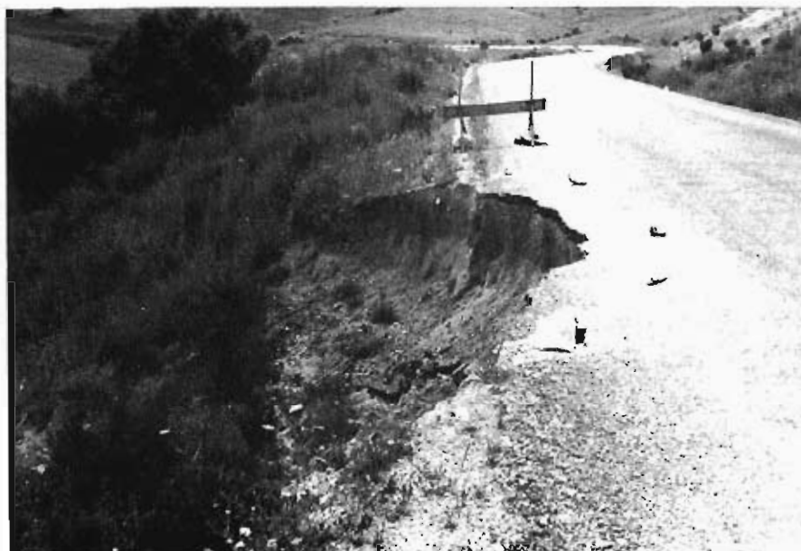
Foto 10. Inestabilidad del grupo 310. Ctra. de Jimena de la Frontera a Gaucín.
