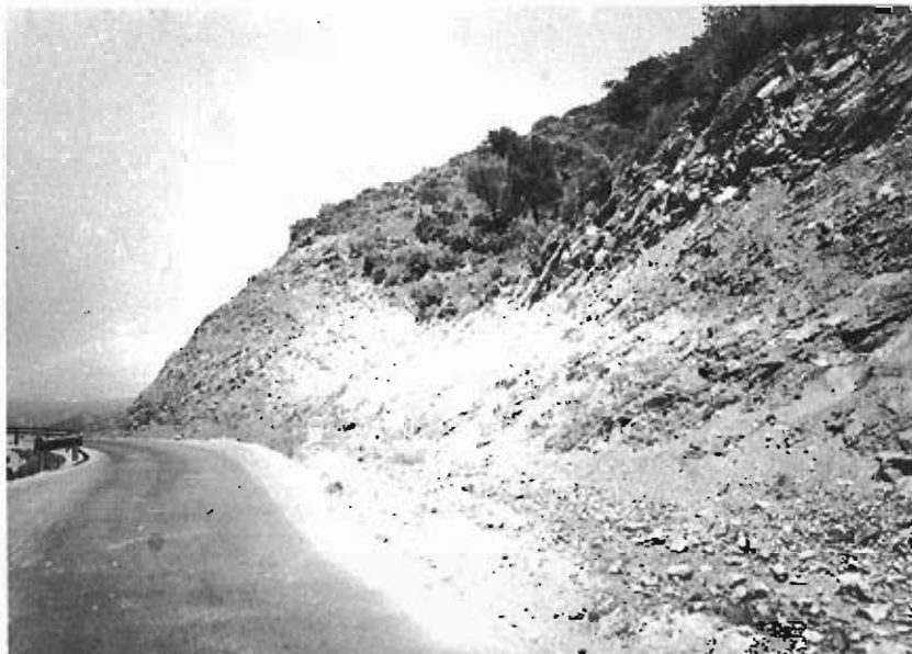
Foto 57. Taludes en un tramo de alternancias de pizarras, grauwacas y calizas del Manto de Málaga (100c). Ctra. de Gaucín a cortes de la Frontera.
