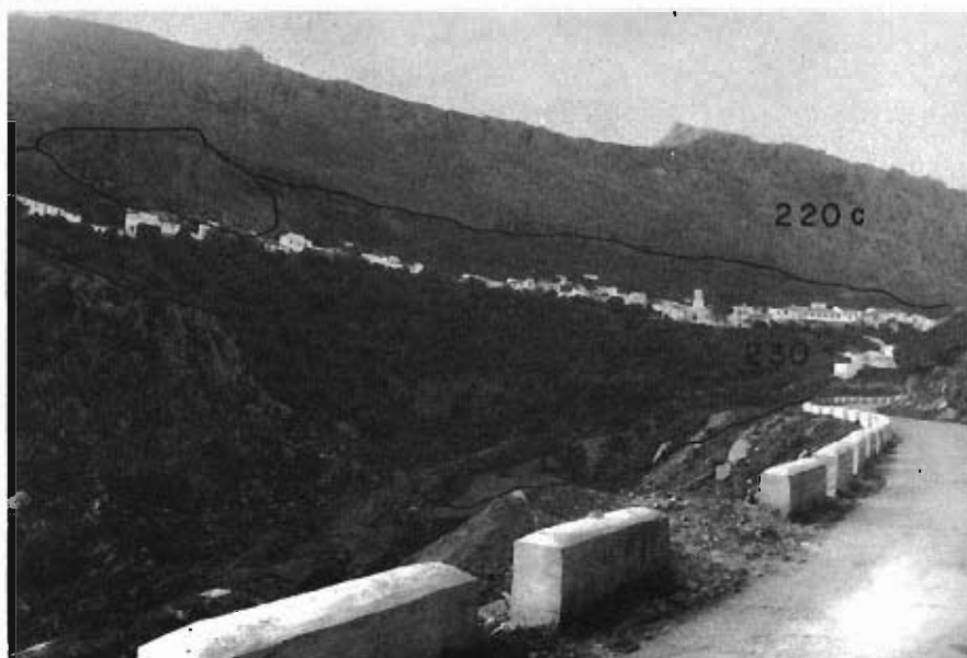
Foto 37. Calizas del Jurásico (220c) en Benaolan, en contacto con las margas del grupo 230 (Cretácico). A la izquierda puede observarse un gran desprendimiento.
