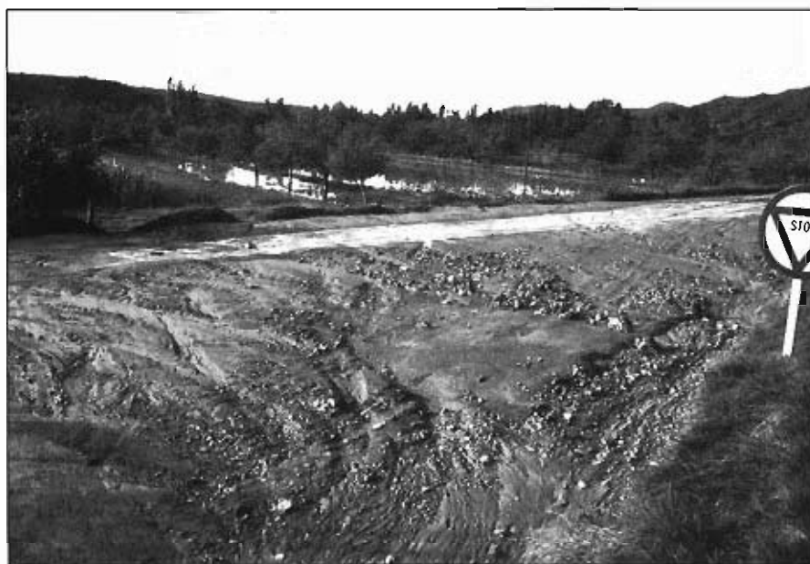
Foto 46.— Aterramientos de la carretera por arrastre de material debido a arroyada laminar.
