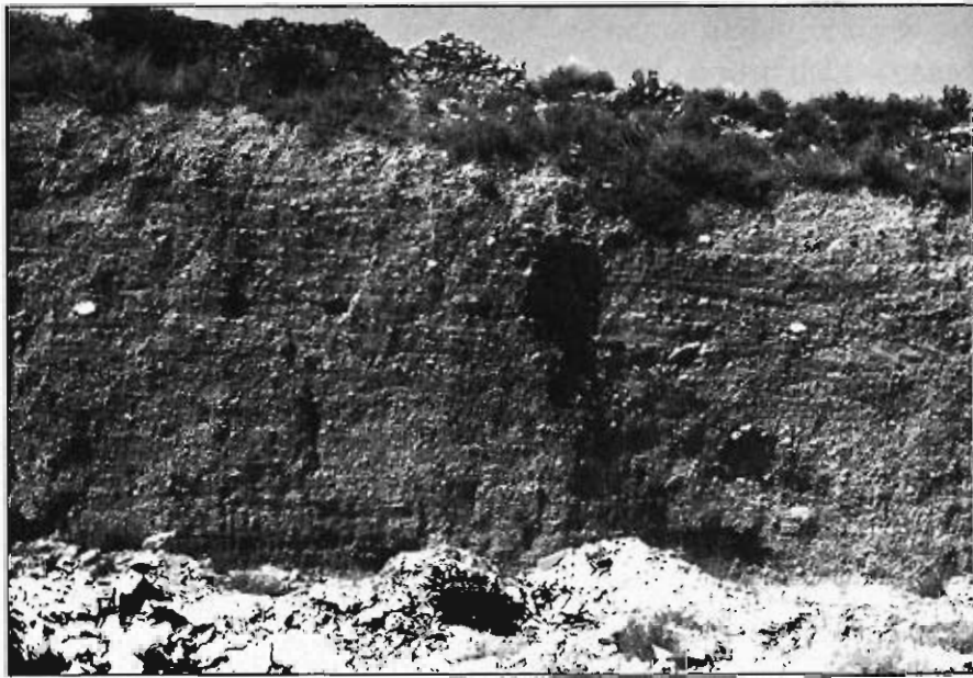
Foto 39.— Excavación subvertical del grupo T2 con ligera degradación de la misma.
