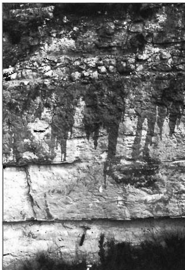
Foto 31.— Excavación artificial vertical con ligera degradación, en el grupo 3211.
