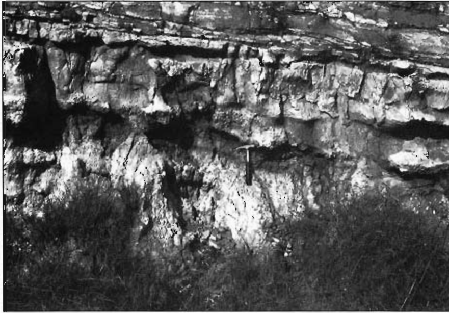
Foto 29.— Detalle del grupo 321j. Obsérvese la degradación de los niveles margosos.
