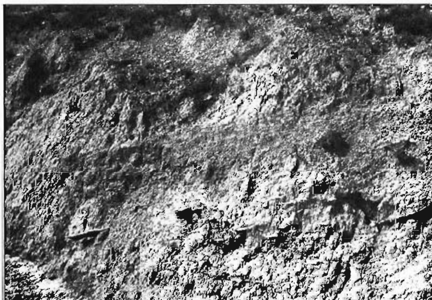
Foto 48.— Grupo 223a. Excavación artificial con degradación progresiva.
