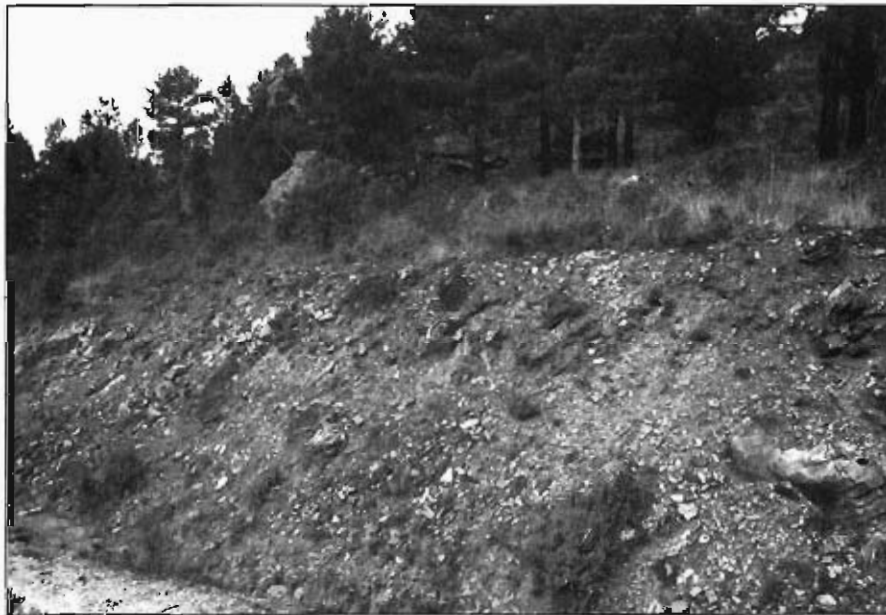
Foto 20.— Talud artificial en la unidad 122, con inclinación de 60º y degradación progresiva.
