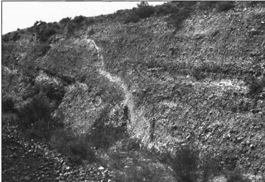
Foto 37.— Grupo 350c donde se aprecia una pequeña falla de unos 0,5 m de salto.
