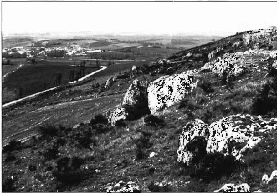
Foto 2.— Escarpe y deslizamientos en las calizas del páramo inferior. Ladera de la margen derecha del arroyo de Cubillas, por la que discurre la carretera que une Villagonzalo-Pedernales con Arcos, pueblo que se ve en segundo plano y a la izquierda de la fotografía.
