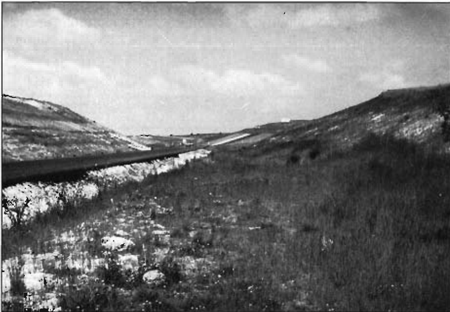
Foto 24.— Taludes de excavación en el grupo 321f2 al Norte de Villagonzalo-Pedernales, en la nueva carretera N-620 de acceso a Burgos por el Sur. Nótese lo tendido de los mismos y el gran espacio existente entre la cuneta y el talud, motivado sin duda por la limpieza de materiales implicados en deslizamientos. La gran cantidad de agua existente en el terreno y la naturaleza arcillosa y margosa de gran parte del mismo da lugar a un terreno de malas condiciones constructivas.
