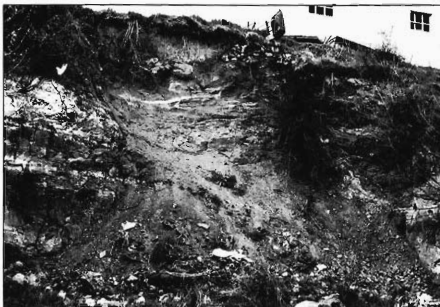
Foto 40.— Arcillas, limos, arenas y areniscas, de tonos rojos, del grupo 321h. Talud de excavación junto al pueblo de Cobia, afectado por un desplome.
