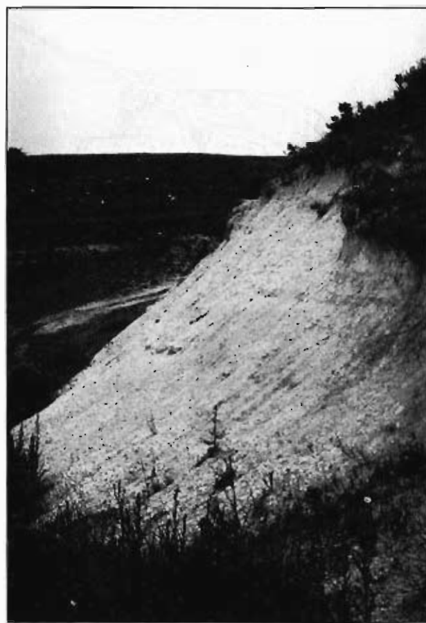
Foto 28.— Talud de excavación en las margas y margocalizas del grupo 321g. El lugar se sitúa en las proximidades de Avellanosa del Páramo, y en la margen derecha del río Ruyales, afluente del Hormazuelas por la izquierda.
