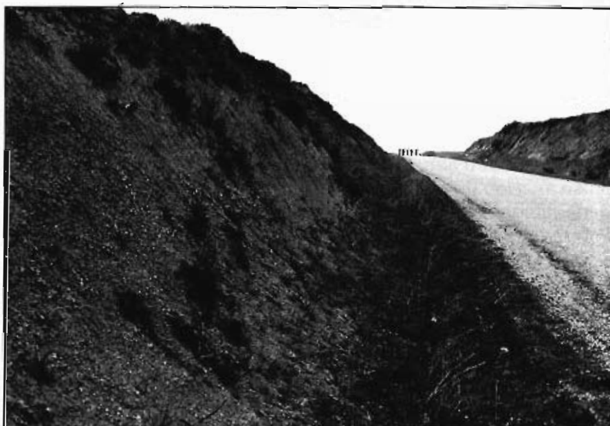
Foto 41.— Talud excavado en arcillas carbonatadas del grupo 321h, en las proximidades de Castrillo de Villarega.
