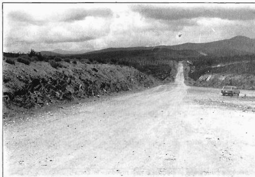
Fig. 3.27.— Pequeños desmontes excavados en las pizarras del grupo (010b), en las inmediaciones de Zarza de Granadilla.
