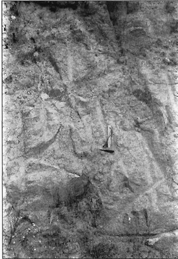
Fig. 3.39.— Detalle de un talud excavado en los materiales del grupo (VI), en las proximidades de Oliva de Plasencia.
