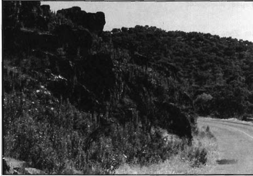
Foto 1.- Grupo 120. Afloramiento de pizarras con hiladas de cuarzo, en el P.K. 108+200 de la carretera N-435.
