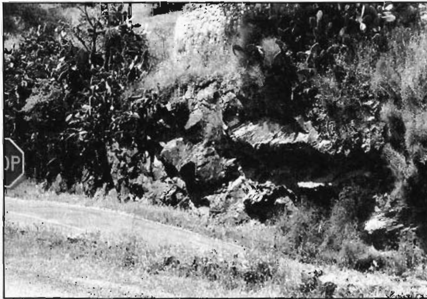
Foto 9.- Grupo (010f). Excavación artificial realizada en rocas de silicatos cálcicos, en el P.K. 72 de la carretera N-433.
