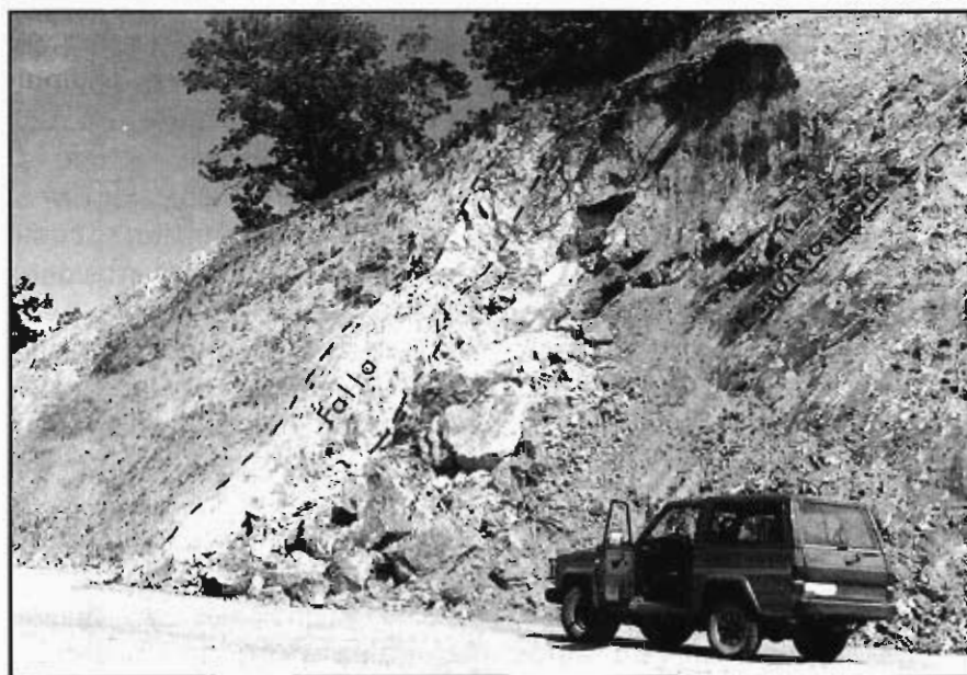
Foto 15.- Deslizamiento plano de tipo cuña a favor de la esquistosidad y de una gran zona fallada. Nueva variante de Jabugo.
