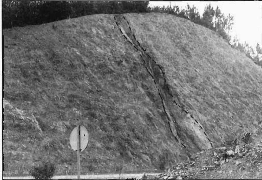
Foto 24.- Aspecto de los materiales del grupo (150b), en un desmonte de la carretera N-435, aproximadamente en el P.K. 84.
