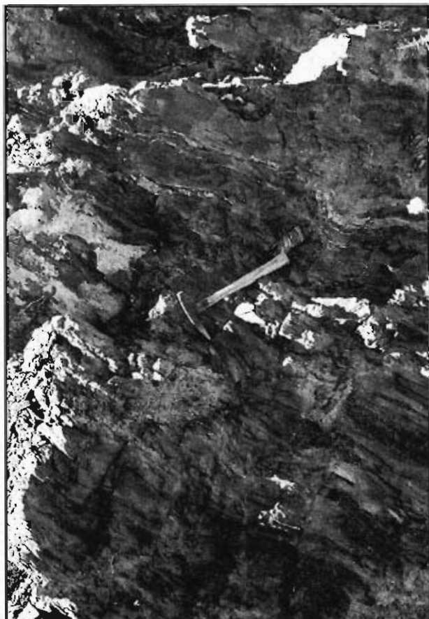
Foto 30.- Aspecto superficial de las pizarras del grupo (151e), en el P.K. 68,1 de la carretera N-435
