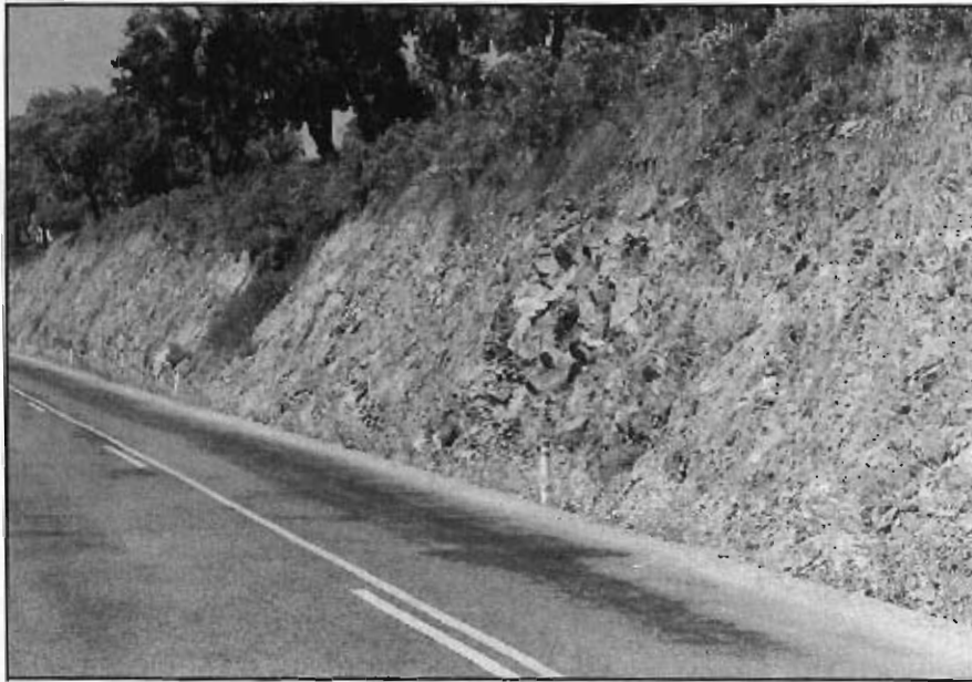
Foto 20.- Talud de desmonte realizado en las ortoanfíbolitas del grupo (130c), en el P.K. 5,5 de la carretera de Almonaster la Real a Cortegana.
