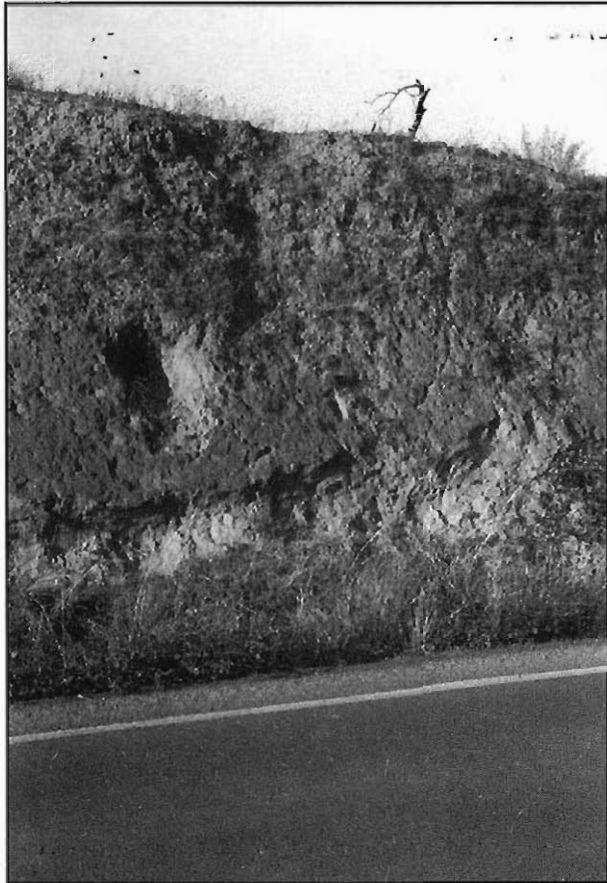
Figura 3.27.- Talud de 60° de pendiente, excavado en los limos del grupo (321a), en las inmediaciones de Trigueros.
