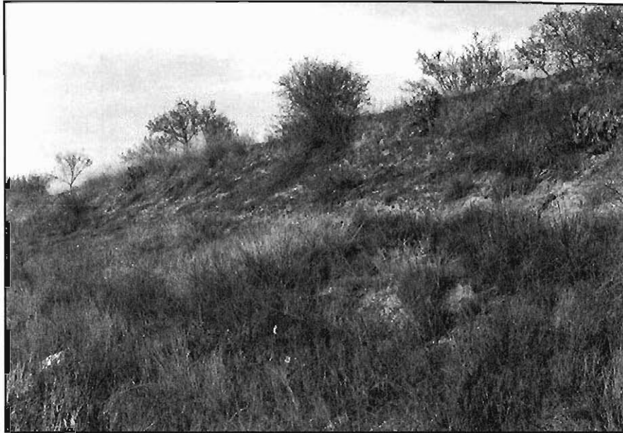
Figura 3.28.- Talud excavado en la variante de Moguer, en los limos del grupo (321a). Obsérvese la pendiente tan tendida de la zona baja del desmonte, con respecto a la coronación que tiene una inclinación mayor.
