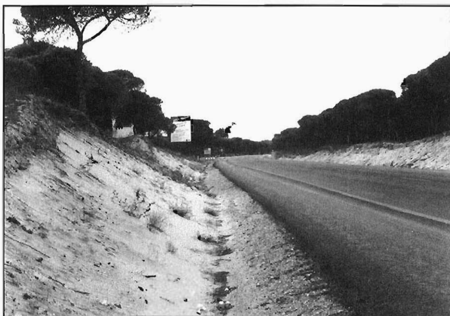
Figura 3.15.- Trinchera de excavación en dunas. Carretera de La Antilla a Isla Cristina.
