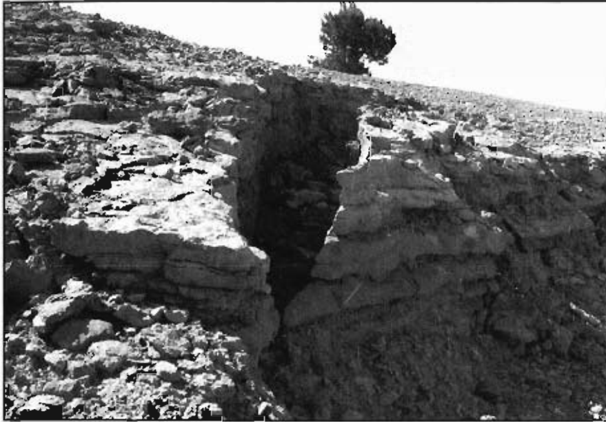
Figura 3.22.- Deslizamiento de un bloque de arenisca del grupo (313b) producido a favor de la estratificación, en un talud de la carretera N-420 (p.k.32) (Hoja 634-2).
