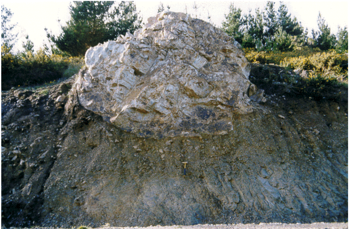
Foto 3.16. Bloque caído cerca de la cima de la Sierra de Meira.
