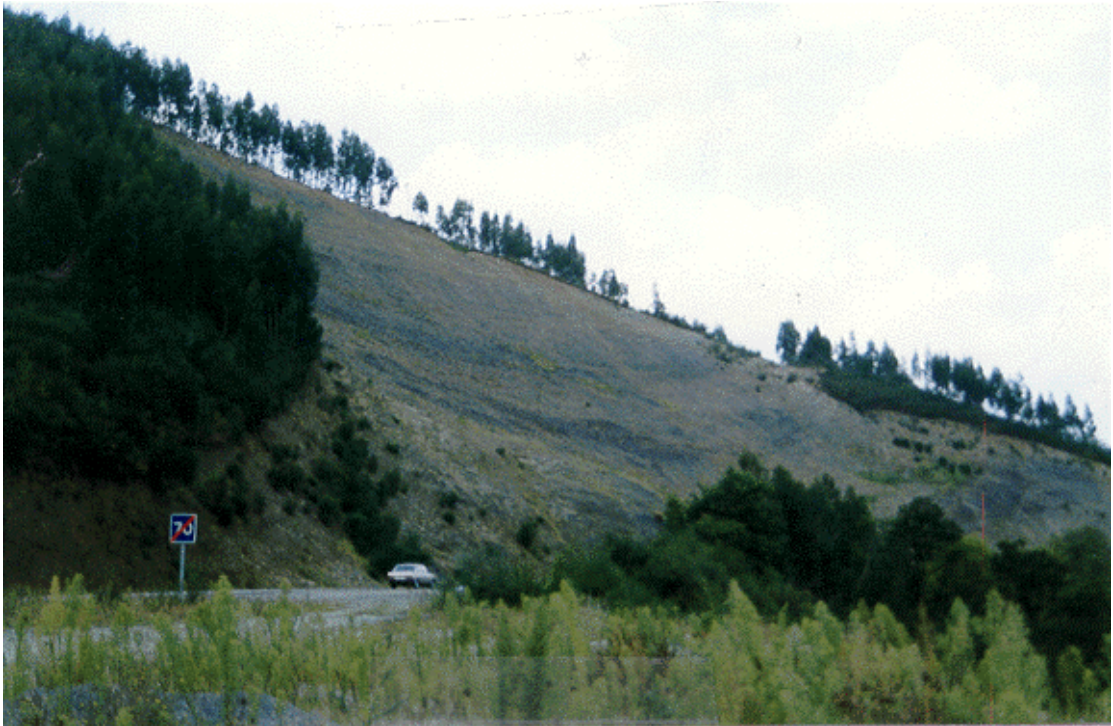
Foto 3.14. Vista general de una zona deslizada en la N-640 al sur de Puentenuevo
