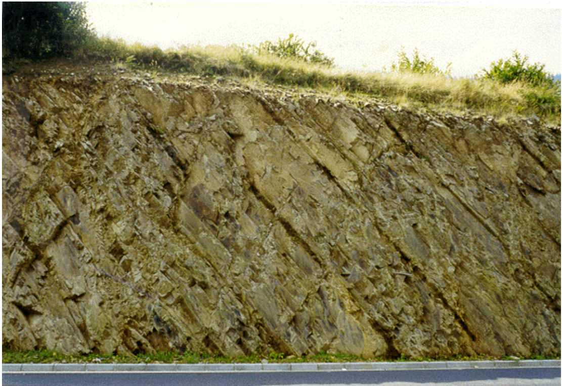
Foto 3.5. Areniscas cuarcíticas con intercalaciones pizarrosas. En las afueras de Bres, (112d).
