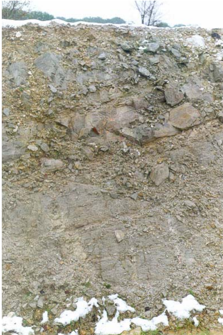
Figura 3.11. Detalle del aspecto de los esquistos silíceos del grupo (121a), en un talud de la carretera N-122. P.K.466,950.
