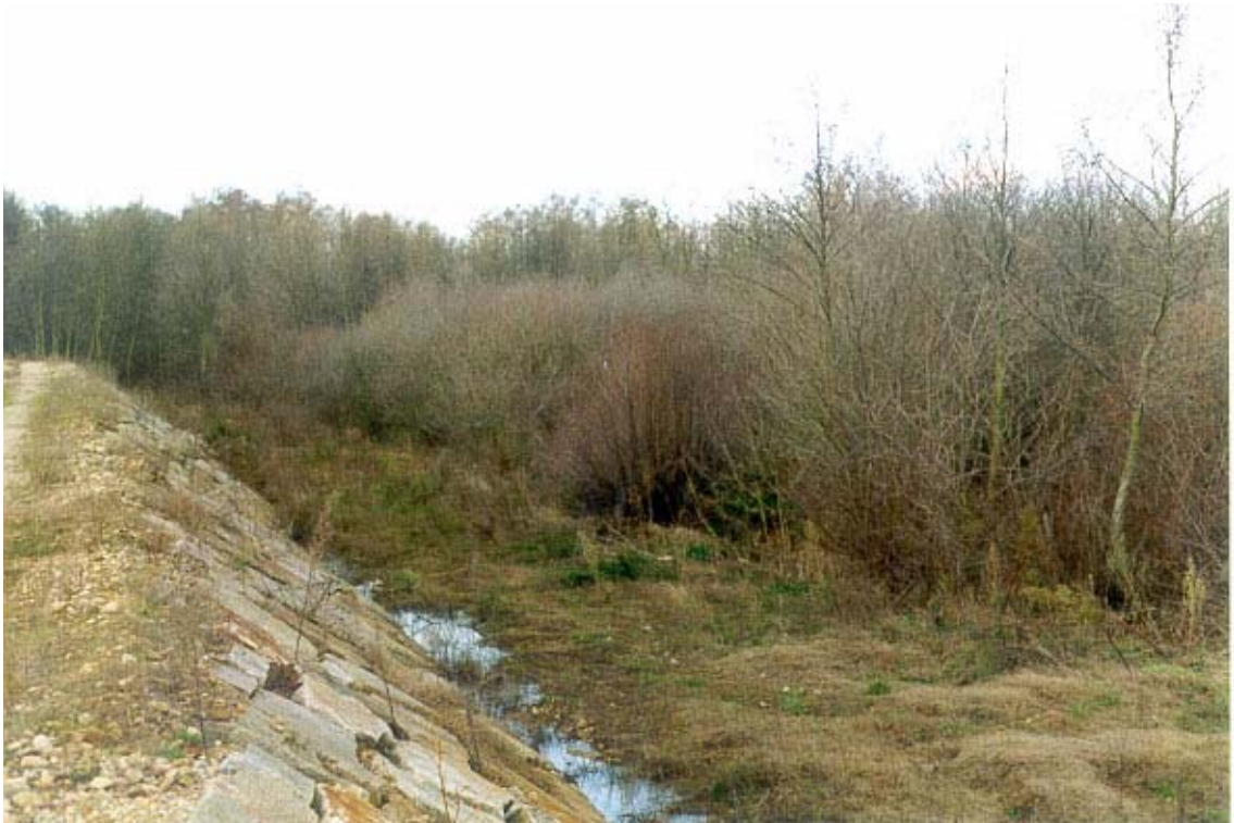
Figura 3.45. Aluvial del río Tera, en Olmillos de Valverde. En primer término, dique para evitar inundaciones en épocas de crecida.
