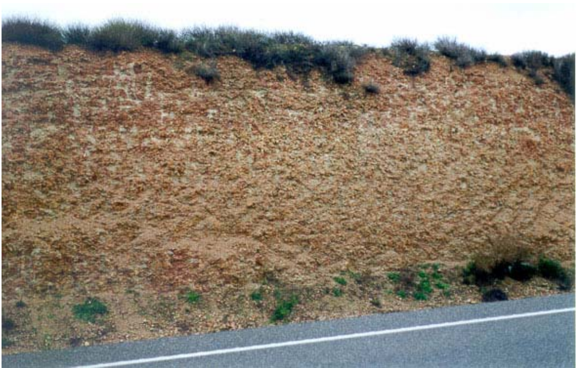
Figura 3.34. Talud excavado en las arcillitas masivas del grupo (312d), situado a la C.N.-630. P.K.269,100.
