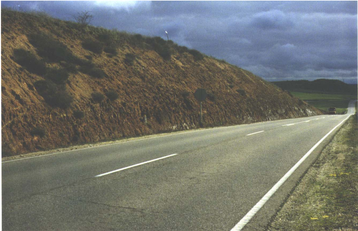
Figura 3.23. Talud de baja altura realizado en las arenas de la formación (313a). Pueden observarse dos inclinaciones: 45^{\circ} en la parte superior meteorizada, y 60^{\circ} en la zona inferior sana. P.K. 21,100 de la carretera local entre Almenara de Tormes y Juzbado (Hoja 452-3).
