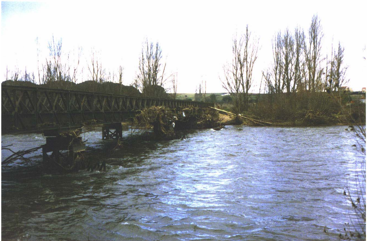
Figura 4.1. Aspecto panorámico del río Tormes después de una crecida. Puede observarse la acumulación de restos vegetales en un puente, que indican el nivel que han tomado anteriormente las aguas. Proximidades de la localidad de Almenara de Tormes (Hoja 452-3).
