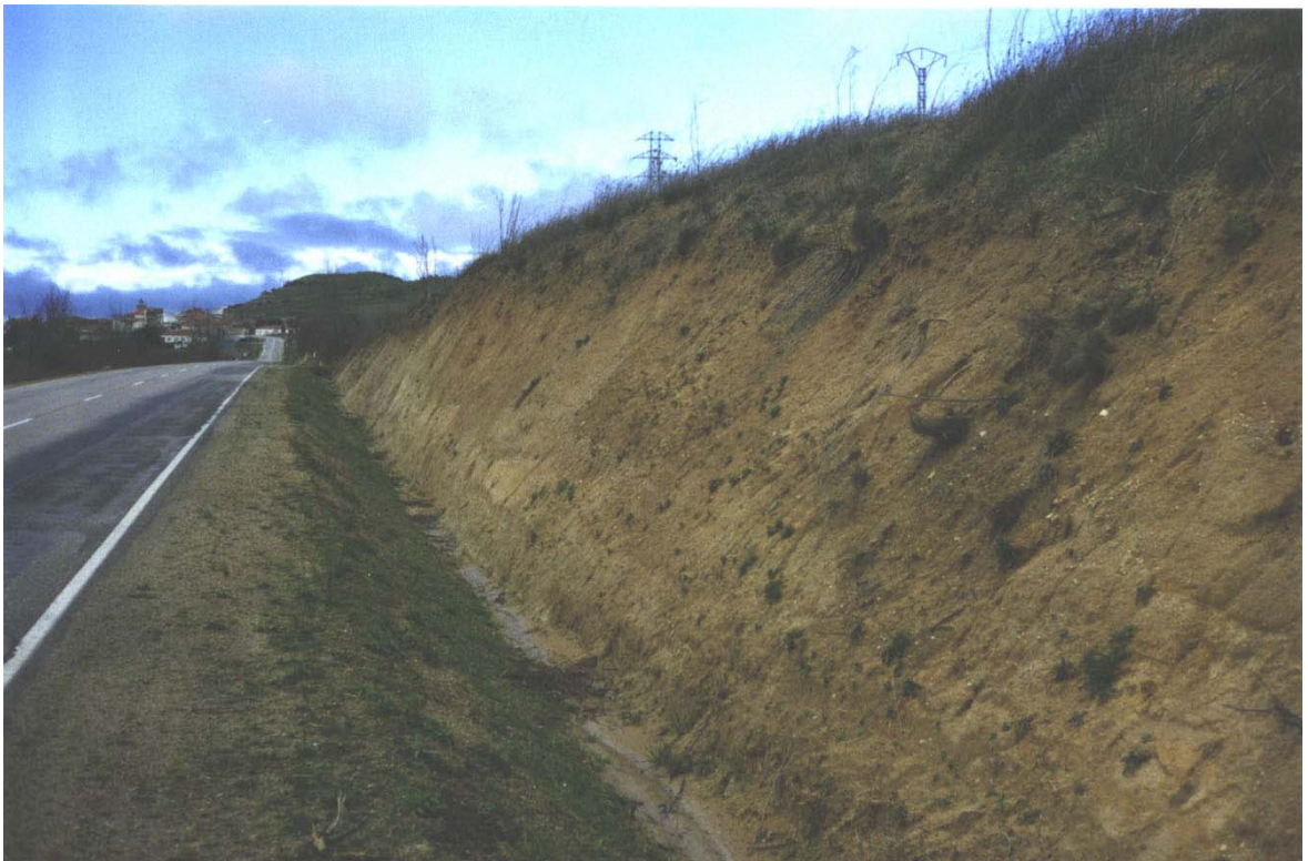
Figura 3.29. Talud de baja altura realizado en el grupo (312b), en las proximidades de la localidad de Almenara de Tormes (Hoja 452-3).
