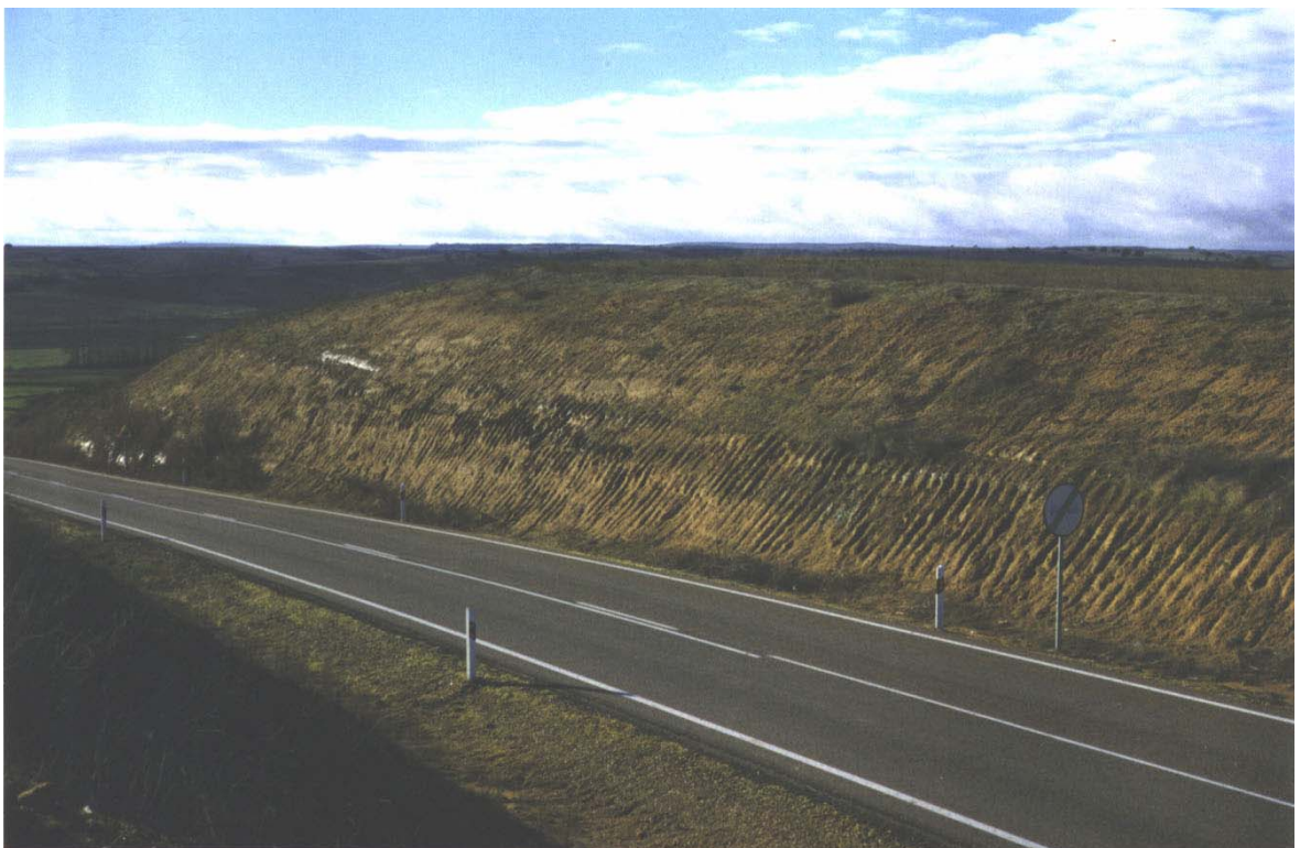
Figura 3.27. Talud realizado en la formación (312c), en las proximidades del p.k. 31 de la carretera C-605, entre las localidades de Argujillo y Fuentesauco (Hoja 425-1).
