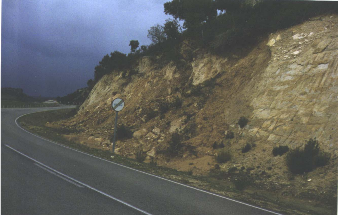
Figura 3.51. Talud de altura media realizado en el granito del grupo (001), en las proximidades de El Arco (Hoja 452-4).
