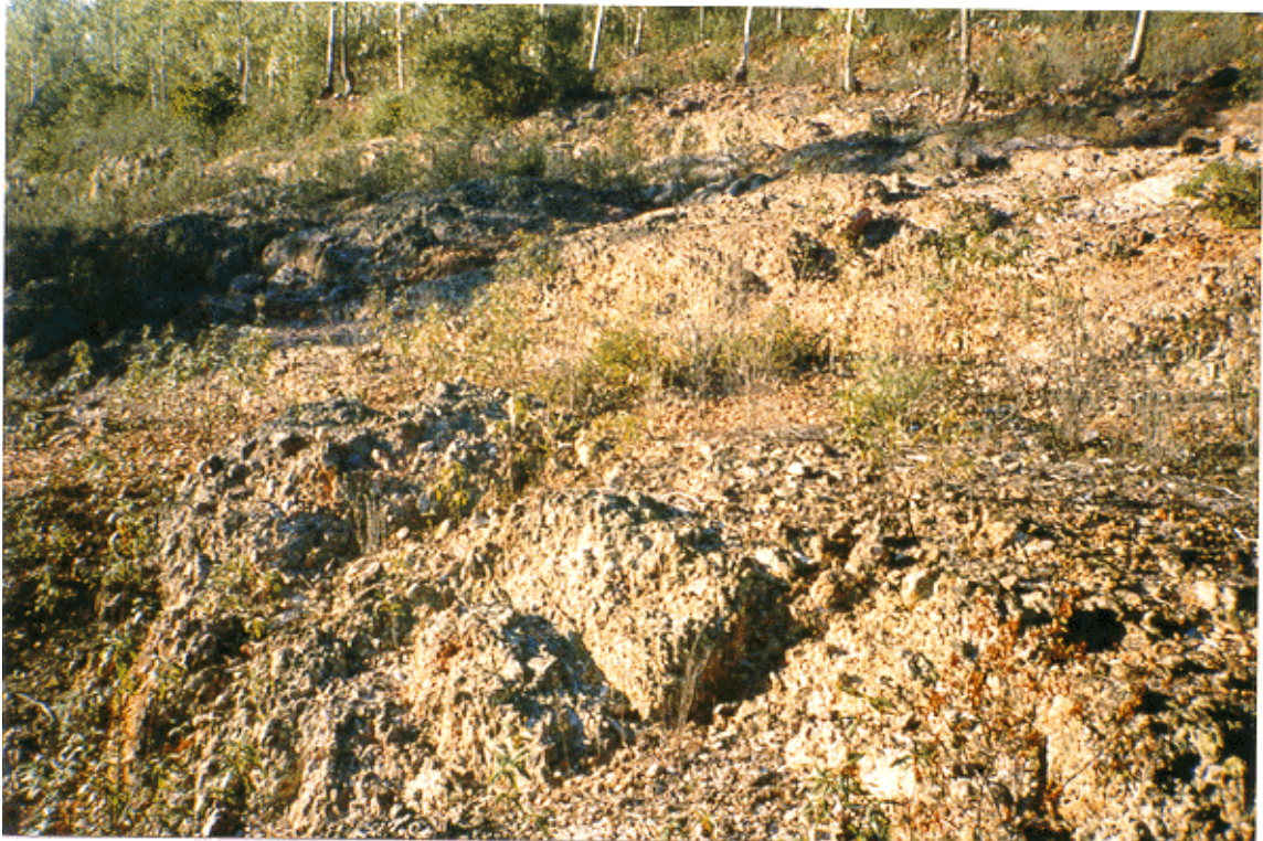
Foto 3.3. Aspecto geotécnico del grupo litológico (152)
