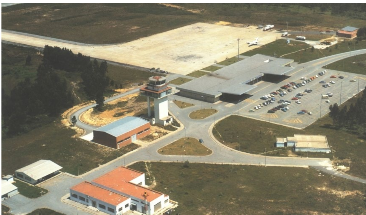
Ilustración 1.1.- Vista panorámica del Aeropuerto de Asturias en el año 1972
