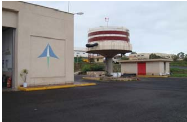
Ilustración 2.12.- Depósito elevado y almacén
