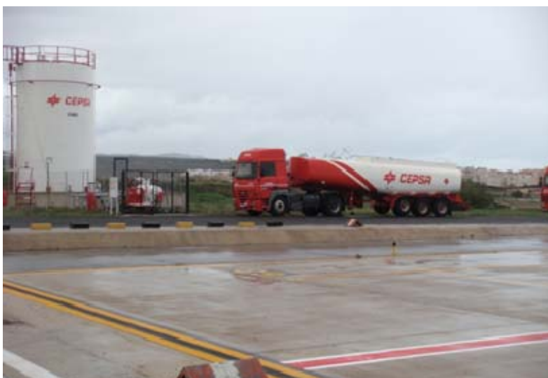
Ilustración 2.19.- Depósito de combustible de JET A-1 y camión cisterna
