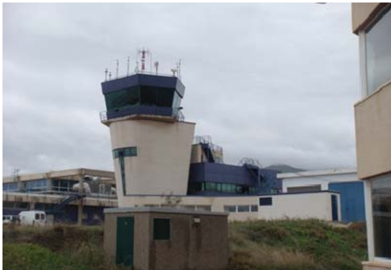
Ilustración 2.10.- Torre de Control
