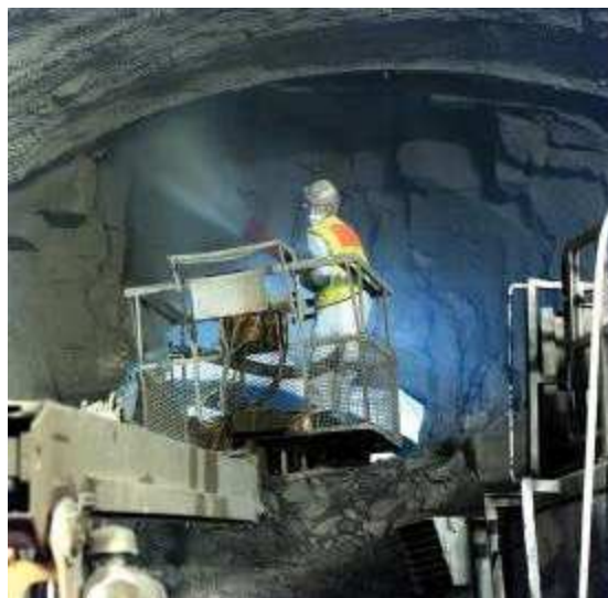
Fotografía 2.- Gunitado sobre plataforma elevadora.
