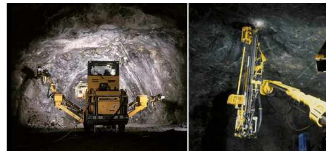
Fotografía 1.- Jumbo de dos brazos perforadores hidráulicos.
