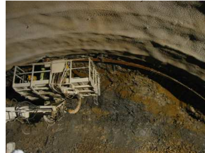
Fotografía 3.- Plataforma de elevación móvil para colocación de cerchas.
