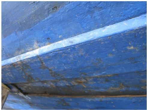
Figura 5. Imagen de la traca desprendida (imagen facilitada por Asteleiros Triñanes)
