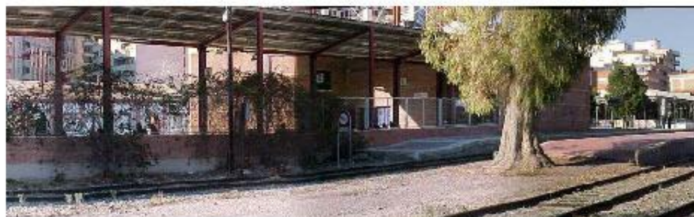
Vista de la Estación de Lorca-Sutullena. A la izquierda se puede observar la estación de autobuses
