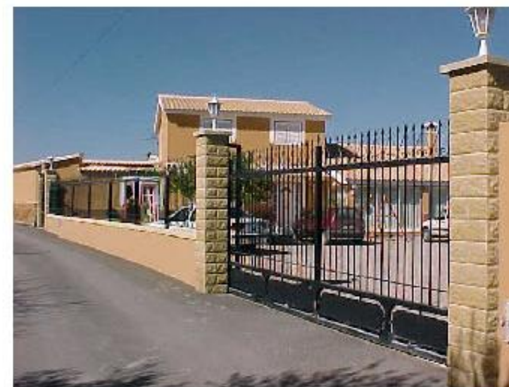
Ejemplo de edificación levantada al Sur de la traza actual
