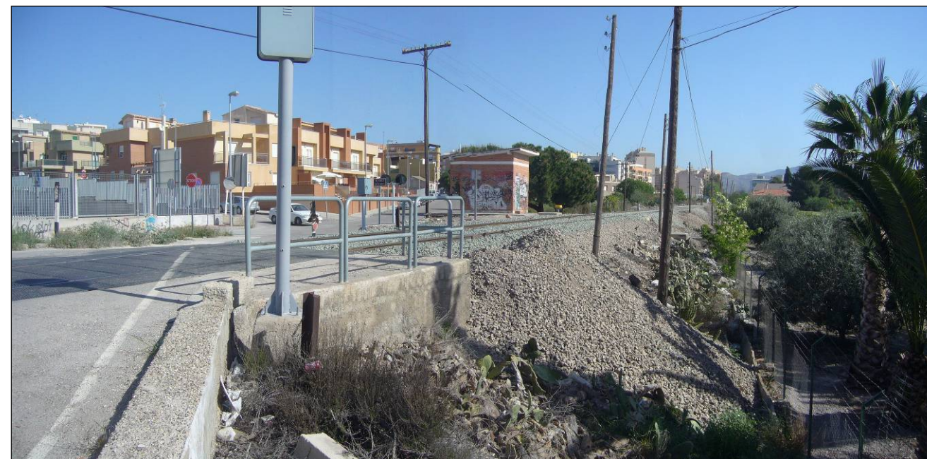
Foto 182. Panorámica del paso a nivel de la calle Martín Morata, en sentido Sutullena. Al fondo se ve la nueva urbanización.
