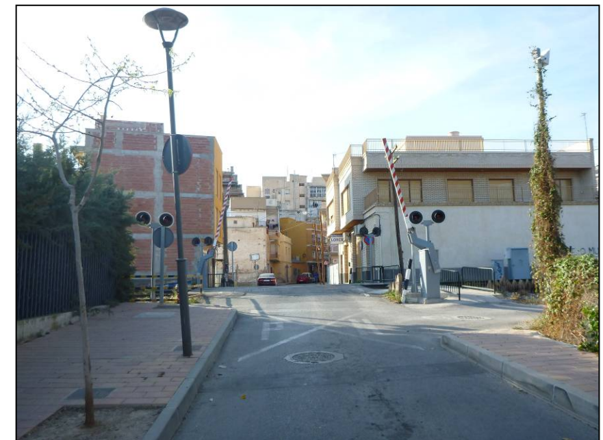
Foto 117. Vista del paso a nivel de la calle Fajardo el Bravo, P.K. 49+740 (0/235 de la línea Sutullena - San Diego), desde la margen izquierda. (202+590)
