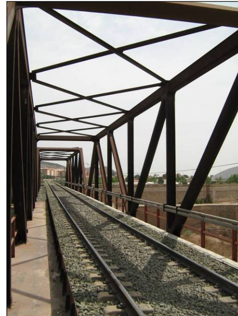
Foto 86. Vista del puente metálico sobre el río Guadalentín, desde el estribo de salida.
