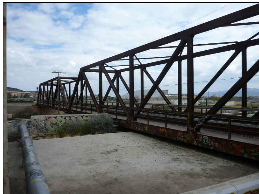
Foto 88. Detalle del segundo vano del viaducto, bajo el que se ha construido el paso inferior de Santa Clara.
