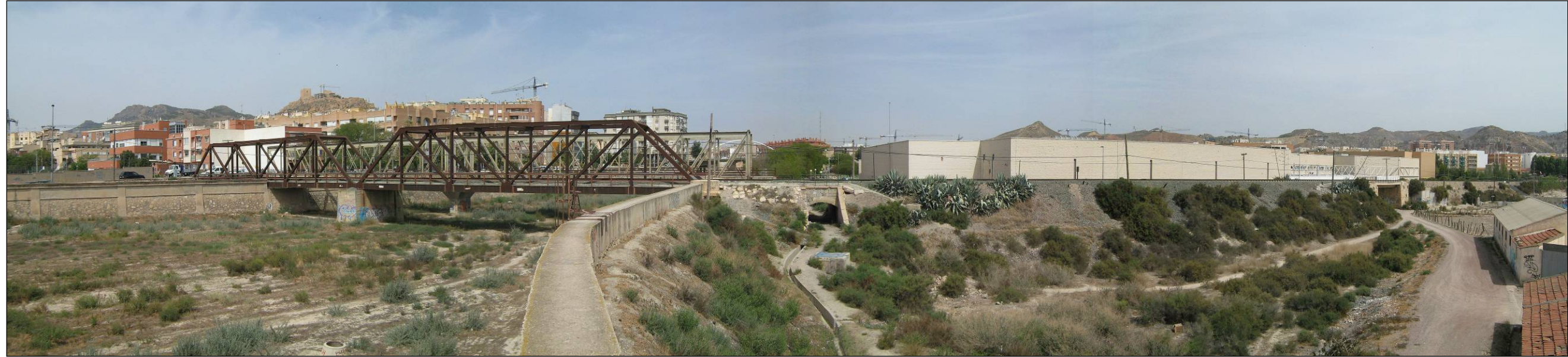
Foto 75. Panorámica del viaducto sobre el río Guadalentín, de la línea Lorca Sutullena - Lorca San Diego, en sentido norte. Se observa el paso inferior del P.K. 49+300 (0/665) (202+155) y una obra de drenaje antes del viaducto.
