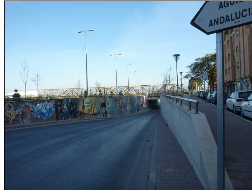
Foto 101. Panorámica del paso inferior de Santa Clara, desde el norte, con la zona peatonal de su derecha.
