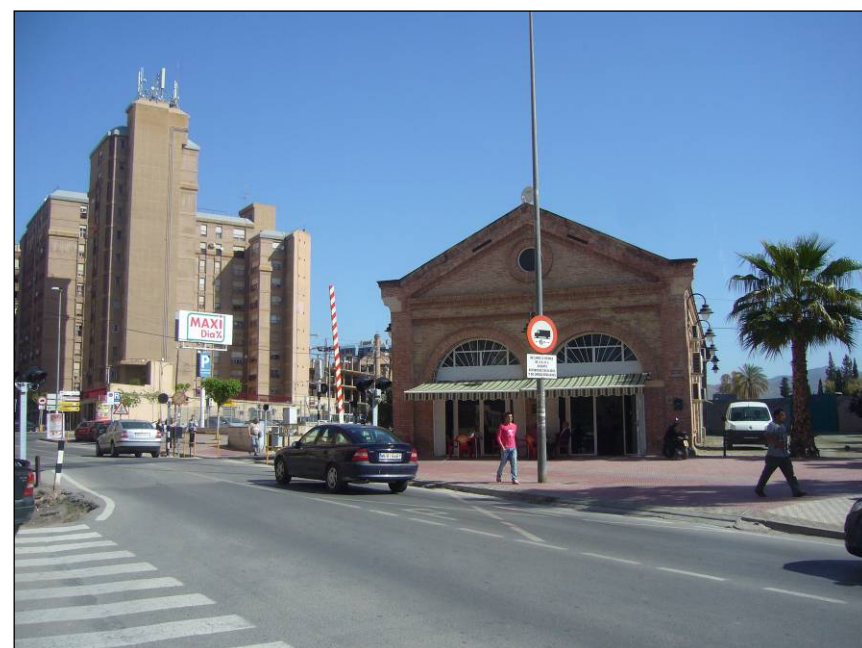
Foto 168. Vista del antiguo edificio ferroviario, junto al paso a nivel anterior.
