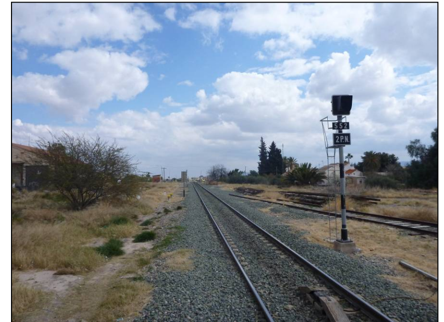
Foto 50. Panorámica desde el inicio de andén de la estación de Lorca San Diego. Se observa levantado el desvío de la vía mango izquierda.
