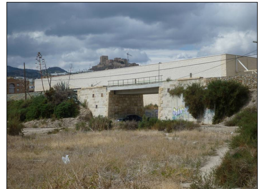
Foto 74. Detalle del paso inferior P.K. 49+300 (202+155).
