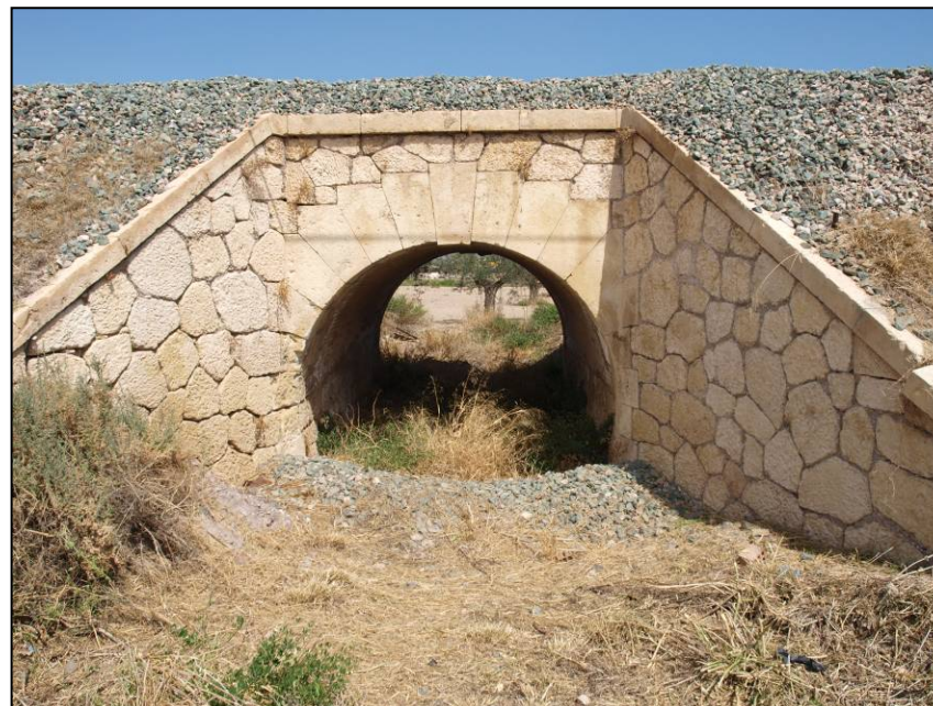
OBRA DE DRENAJE Bóveda 3x2,5 m
