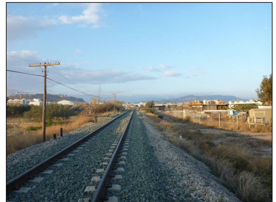
Foto 204. Panorámica de la línea ferroviaria sentido Lorca desde el P.K. 51+800 (204+650).
