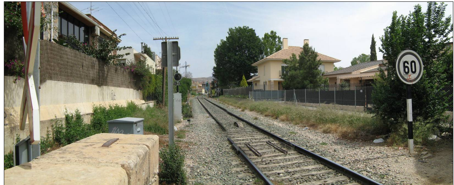
Foto 129. Panorámica de la línea ferroviaria, entre los dos pasos a nivel peatonales. Se observa la proximidad de las edificaciones.
