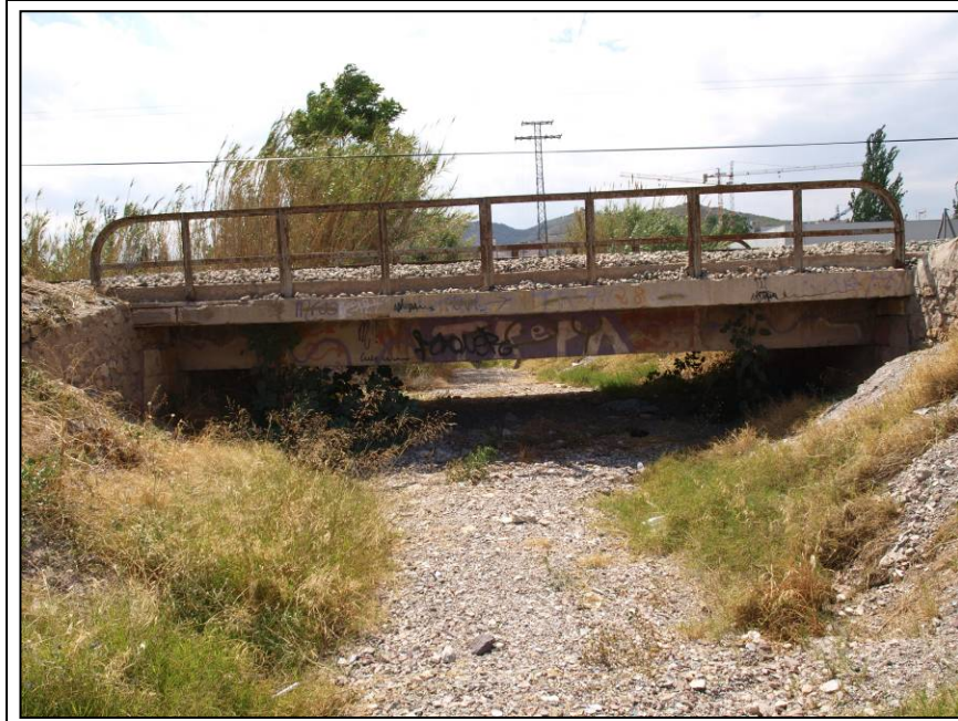
OBRA DE DRENAJE 5 vigas 8x0,9 m
