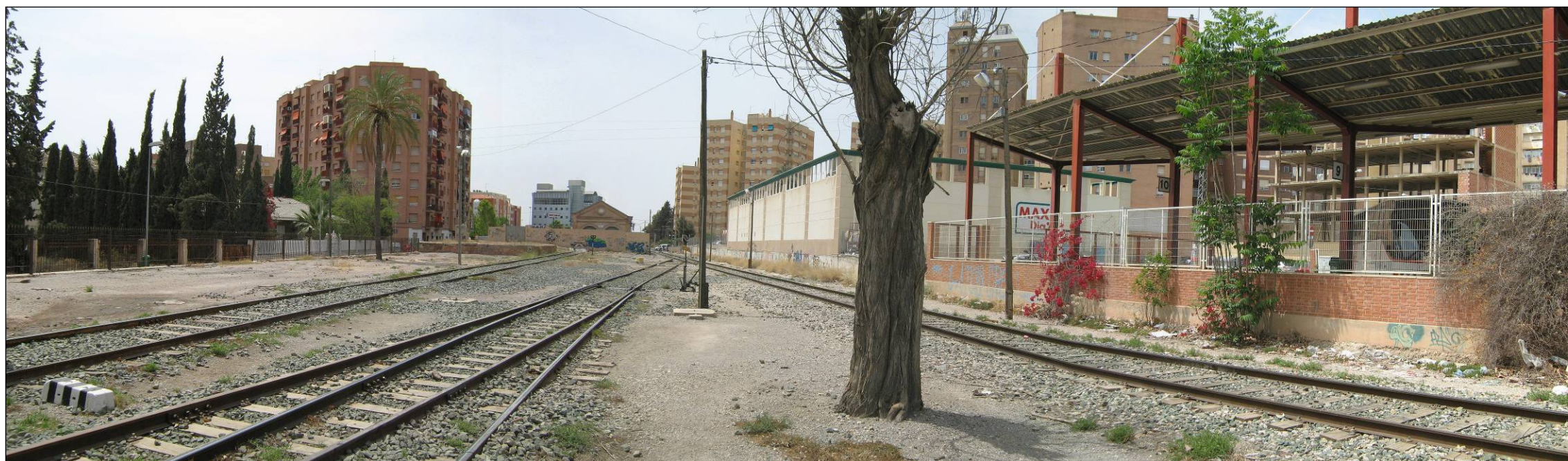
Foto 159. Panorámica de la salida de la estación de Lorca Sutullena. Se observa el desvío de la vía de apartado y la vía mango externa.
