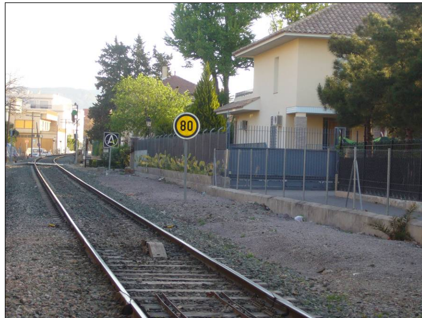
Foto 128. Vista del acceso a la edificación localizada junto a la margen izquierda de la línea ferroviaria, entre los dos pasos a nivel peatonales.
