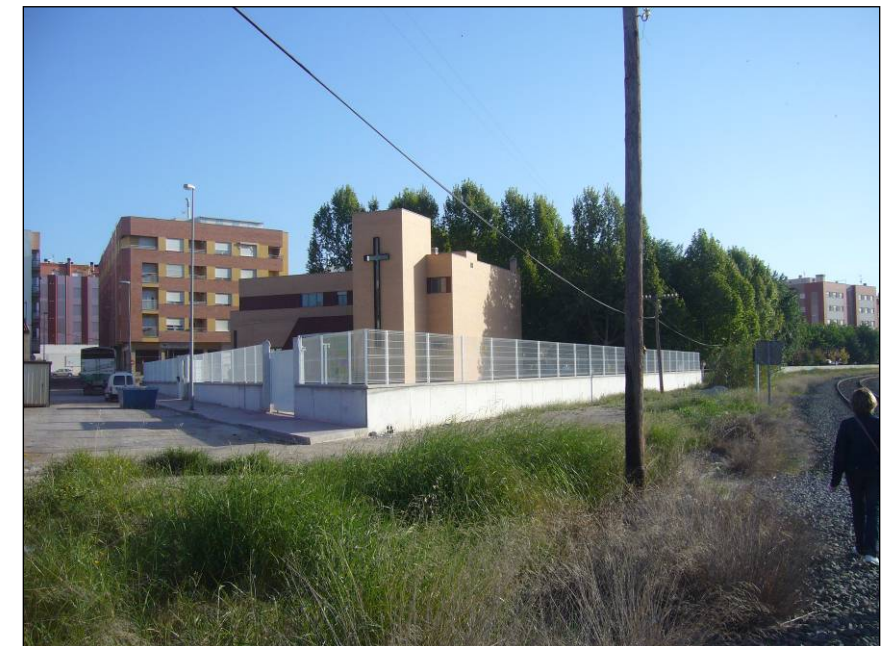
Foto 63. Nueva edificación construida junto a la línea ferroviaria, tras la estación de San Diego.
