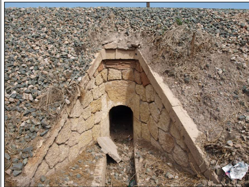
TAJEA Bóveda 0,5x0,9 m 51+190 204+045
