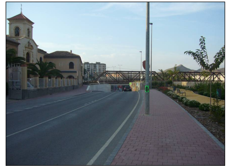
Foto 96. Panorámica del nuevo paso inferior de la Avenida de Santa Clara, que suprime un paso a nivel a la salida del viaducto ferroviario sobre el río Guadalentín, P.K. 49+480 (0/485) (202+325)
