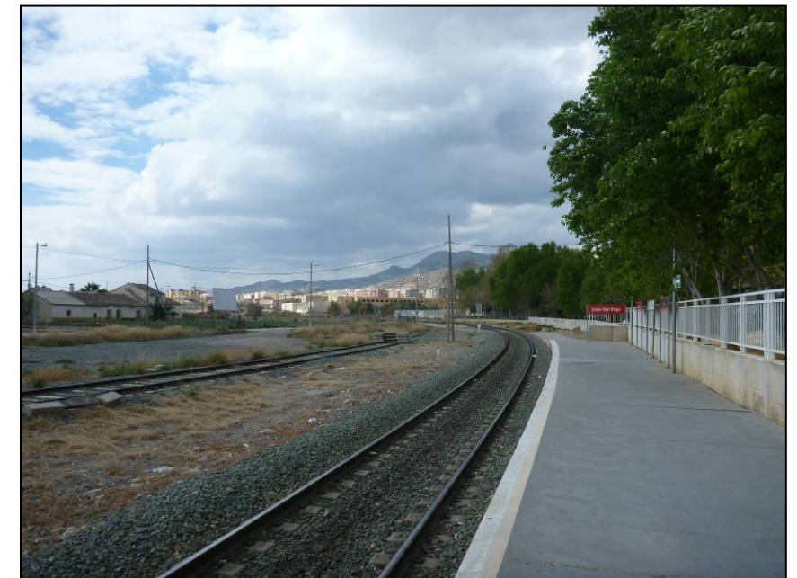
Foto 53. Vista del final de la estación de Lorca San Diego, en sentido Lorca.
