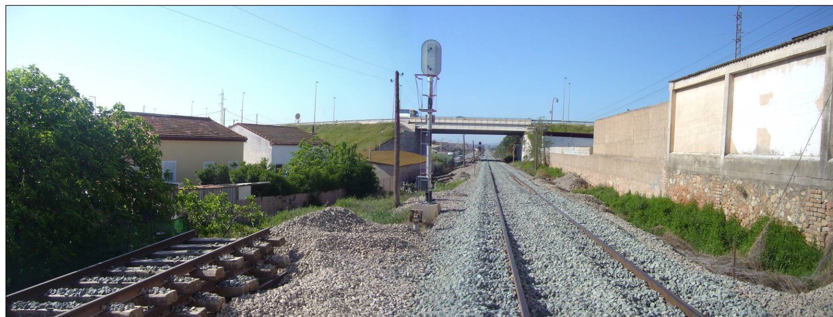
Foto 207. Panorámica de la línea ferroviaria, sentido Baza, en la que se ve el paso superior de la carretera de Águilas y las edificaciones existentes en ambas márgenes, muy próximas a la línea.
