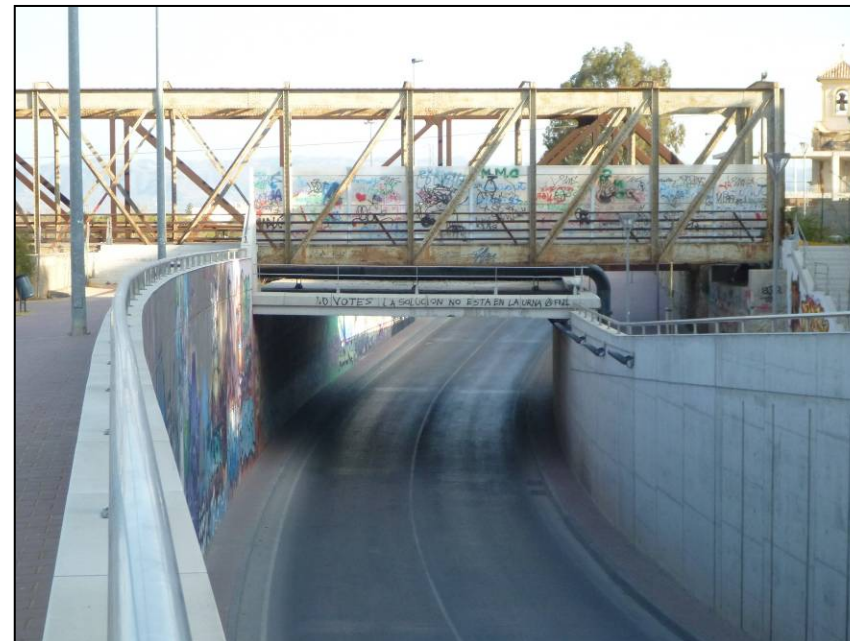
Foto 104. Detalle del marco y la pasarela metálica, margen derecha.
