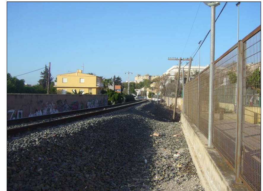
Foto 111. Panorámica de la línea, junto a Santa Clara. Al fondo se ve una de las edificaciones más próximas a la línea ferroviaria.
