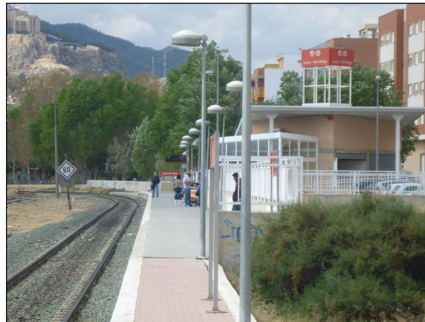
Foto 52. Detalle de la fotografía anterior, donde se observa el edificio de viajeros.
