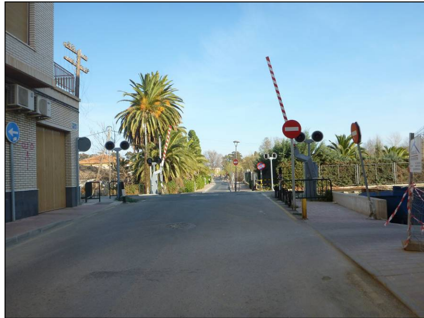
Foto 118. Vista del paso a nivel anterior, desde la margen derecha.
