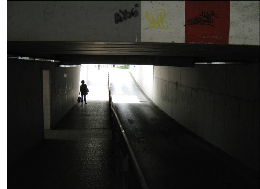
Foto 144. Vista del paso inferior hacia la plaza de toros, que sirve de conexión entre andenes.
