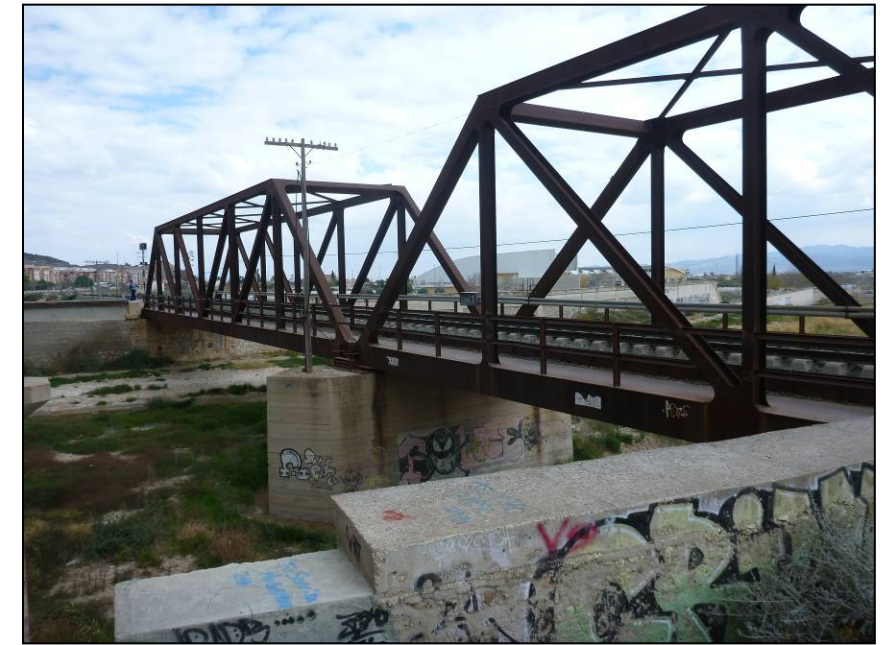
Foto 87. Detalle de la estructura sobre el cauce, primer vano y parte del segundo.
