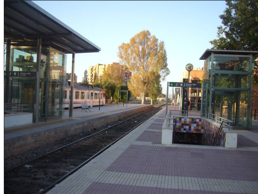
Foto 149. Nuevos ascensores junto a las escaleras del paso inferior entre andenes. Nueva marquesina en andén central de Lorca Sutullena.
