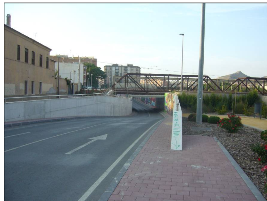
Foto 97. Vista del paso inferior de la Avenida de Santa Clara que aprovecha parte del viaducto ferroviario.
