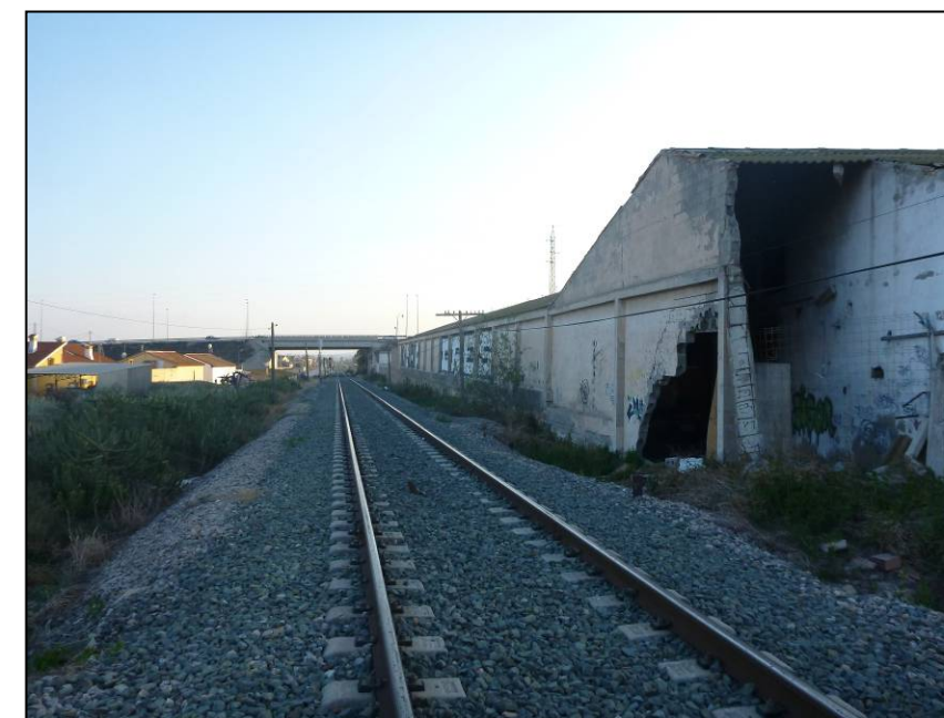
Foto 206. Otra vista de la nave anterior, donde se aprecia su proximidad a la línea ferroviaria.
