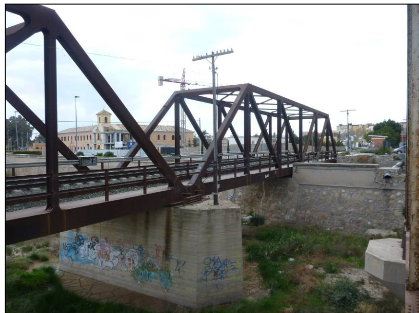
Foto 91. Detalle de la pila central y el segundo vano metálico.
