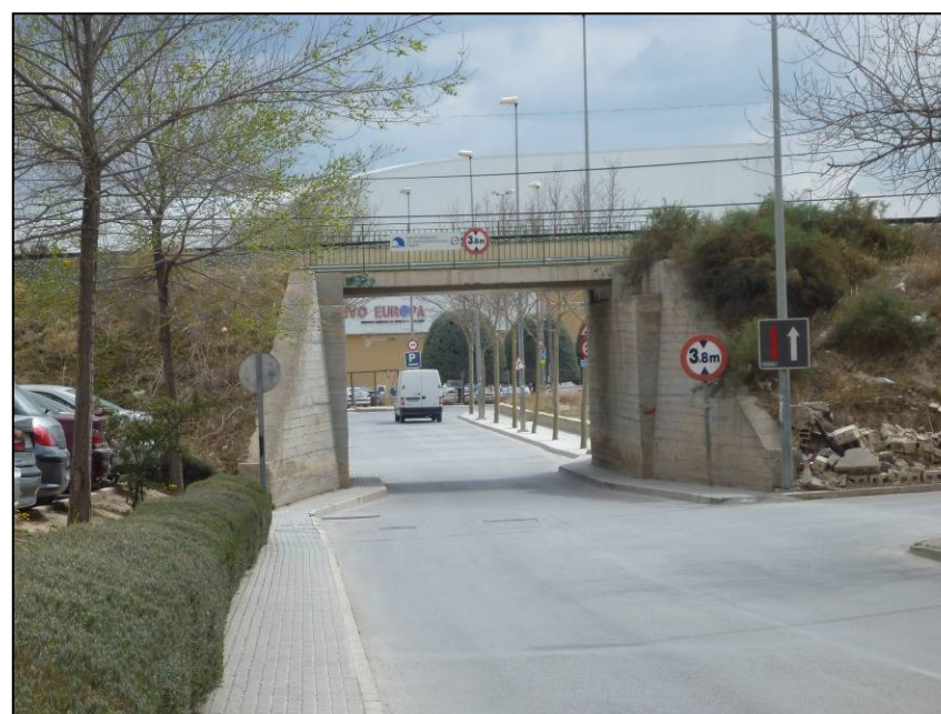
Foto 68. Vista del paso inferior existente en el P.K. 49+220 (0/775).
