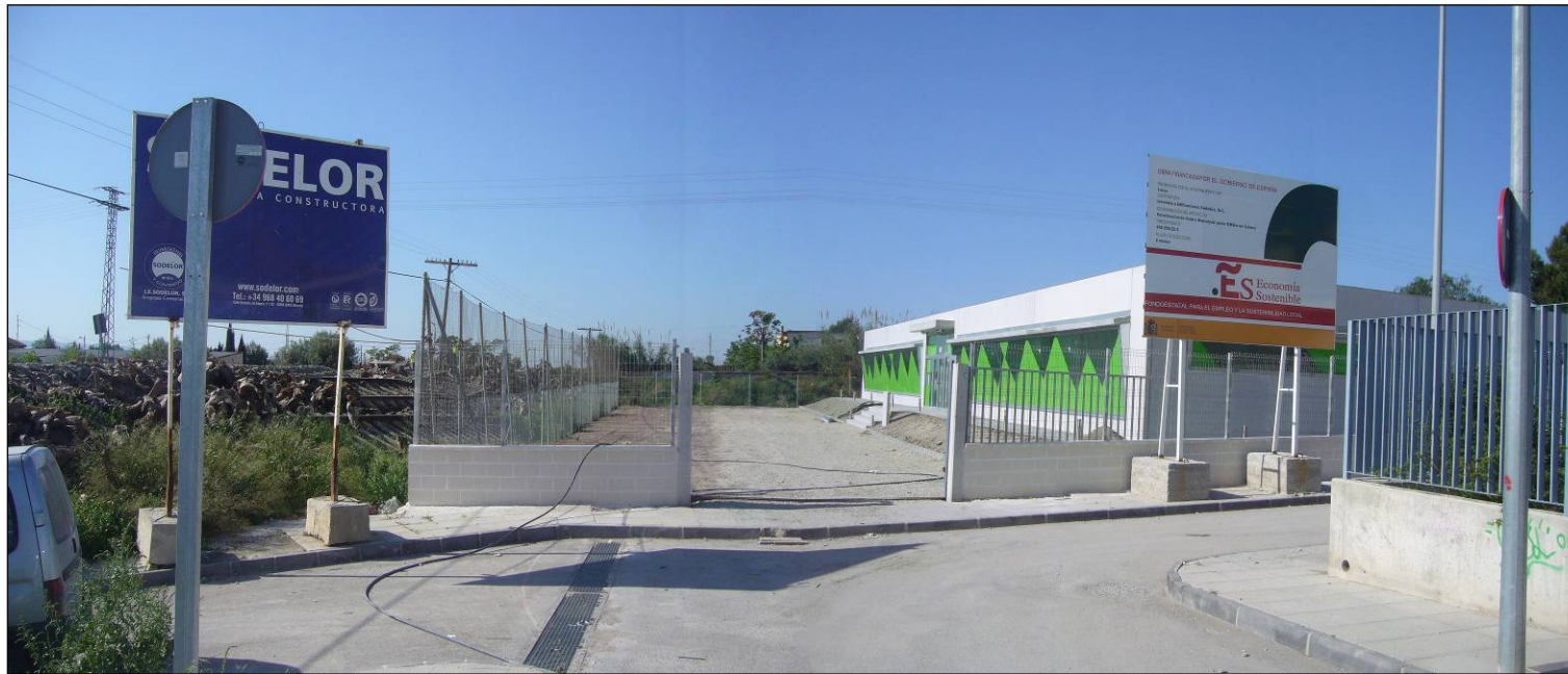
Foto 188. Vista de una nueva edificación en la margen derecha de la línea, pasado Martín Morata.
