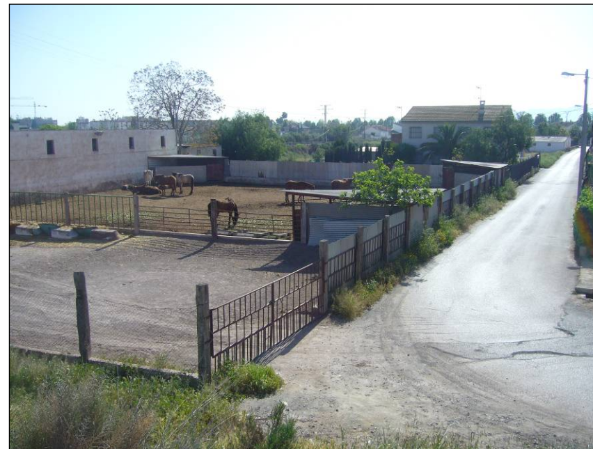
Foto 191. Vista del camino que cruza bajo la línea ferroviaria en el P.K. 51+500 (204+350).
