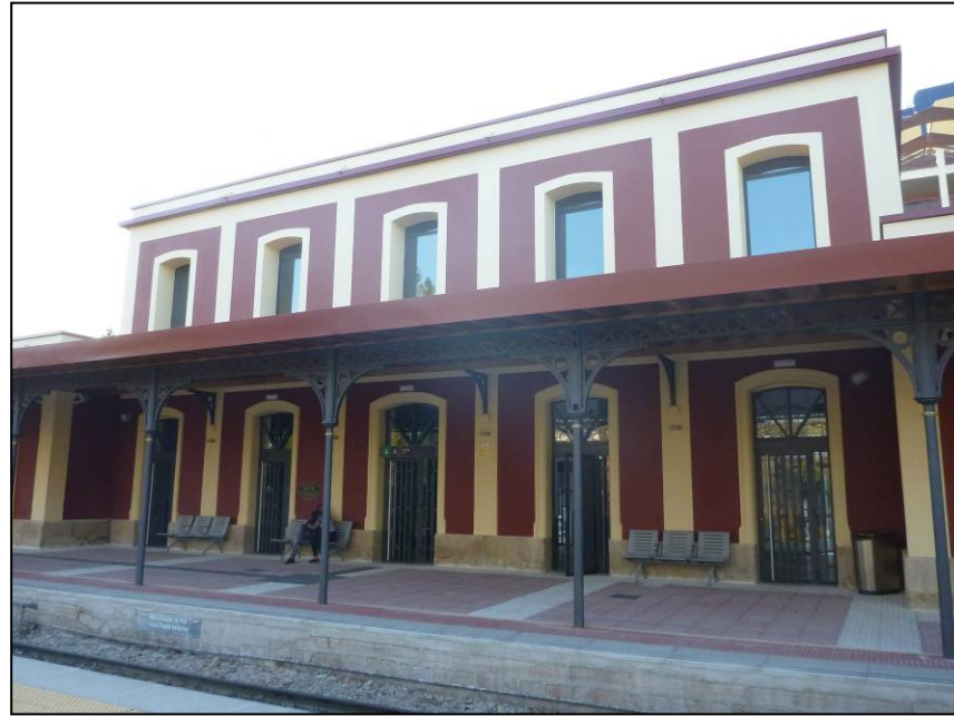
Foto 148. Edificio de viajeros de Sutullena. Acceso a andén.
