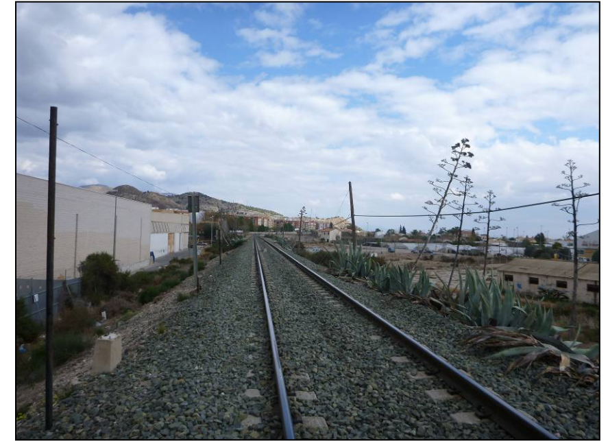
Foto 79. Vista de la línea en sentido San Diego, desde el estribo del viaducto sobre el río Guadalentín.
