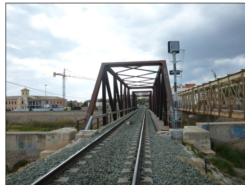
Foto 84. Vista del viaducto desde el estribo de entrada.
