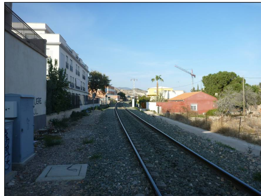
Foto 116. Vista de la línea ferroviaria entre Fajardo el Bravo y Santa Clara.
