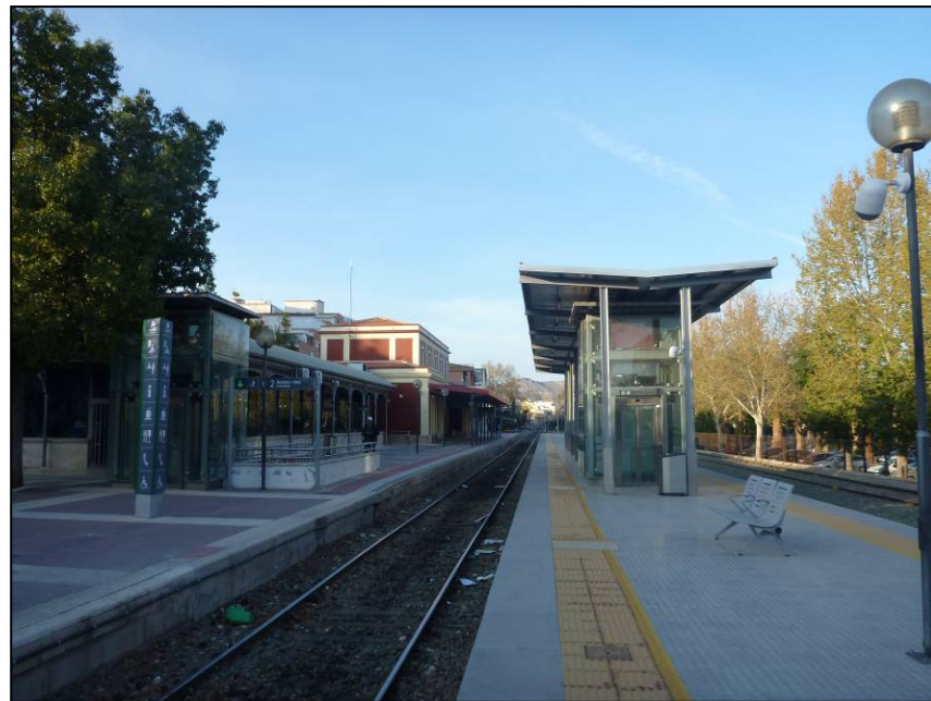
Foto 151. Panorámica de la estación a la altura del paso inferior entre andenes. Vía general.
