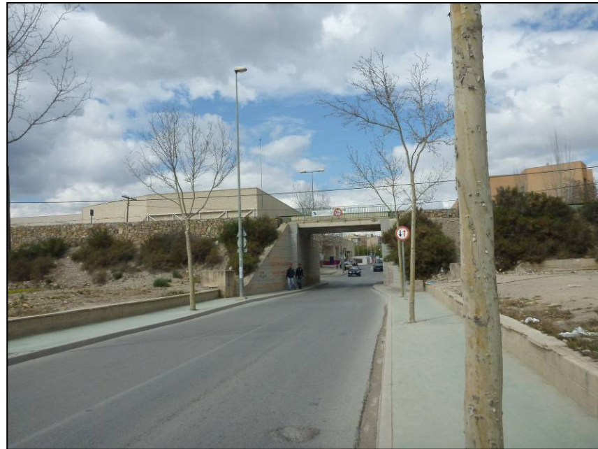
Foto 70. Otra vista del vial de acceso al paso inferior anterior, esta vez desde la margen izquierda. Se observa un muro de escollera antes y después del paso.
