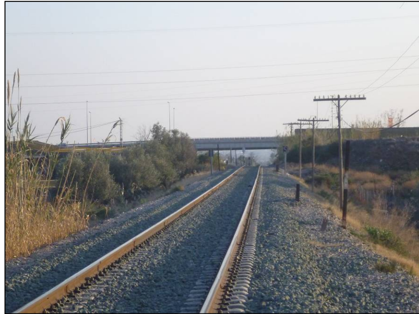
Foto 199. Panorámica de la línea ferroviaria desde el P.K. 51+600 (204+450), sentido Baza.
