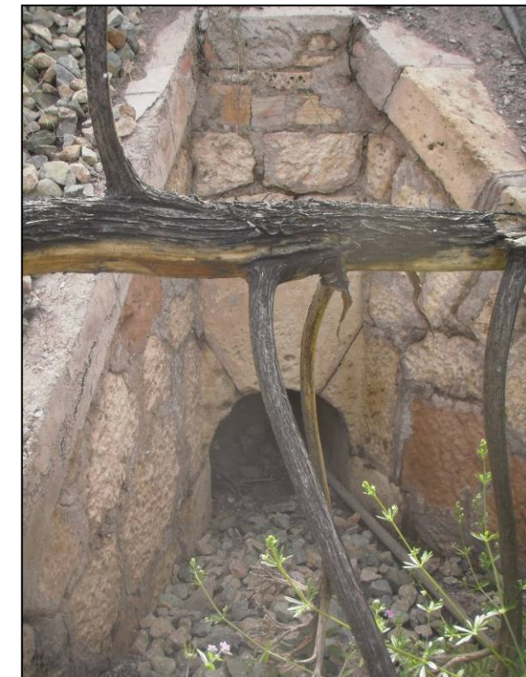
TAJEA Bóveda 0,3x0,5 m
