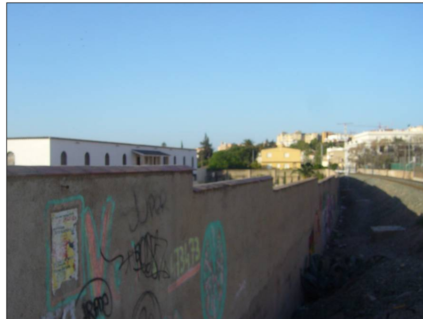
Foto 110. Vista de la línea ferroviaria y el muro de Santa Clara, tras el nuevo paso inferior.
