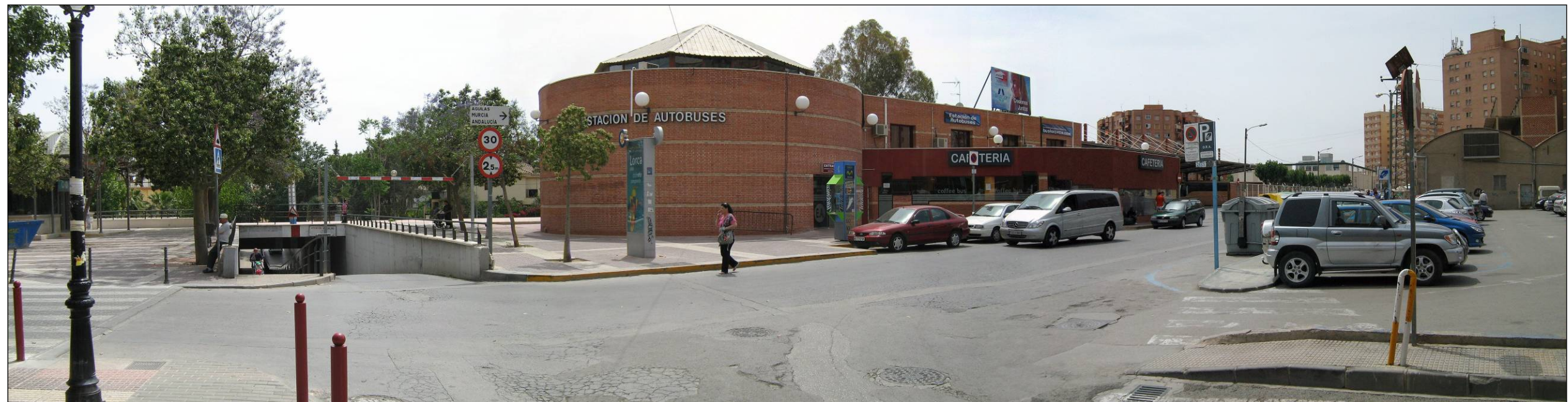
Foto 141. Vista del acceso a la estación de Lorca Sutullena, que está situada junto a la estación de autobuses.
