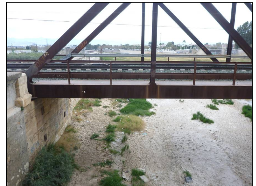
Foto 90. Detalle del estribo de entrada.
