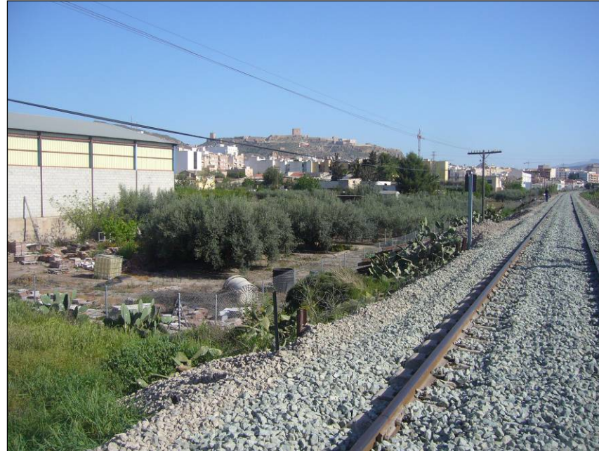
Foto 200. Panorámica de la línea ferroviaria sentido Lorca, desde el P.K. 51+700 (204+550).
