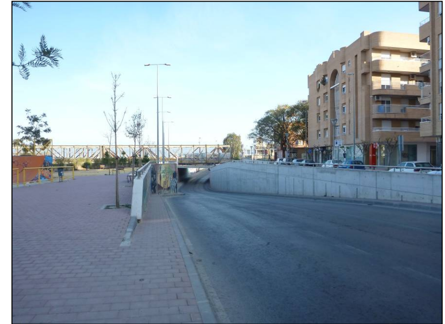
Foto 102. Otra panorámica del paso inferior, junto con la zona peatonal a su izquierda.
