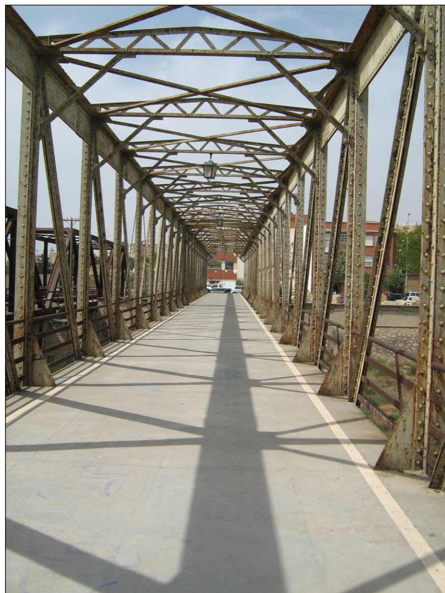
Foto 82. Vista de la pasarela peatonal sobre el Guadalentín.
