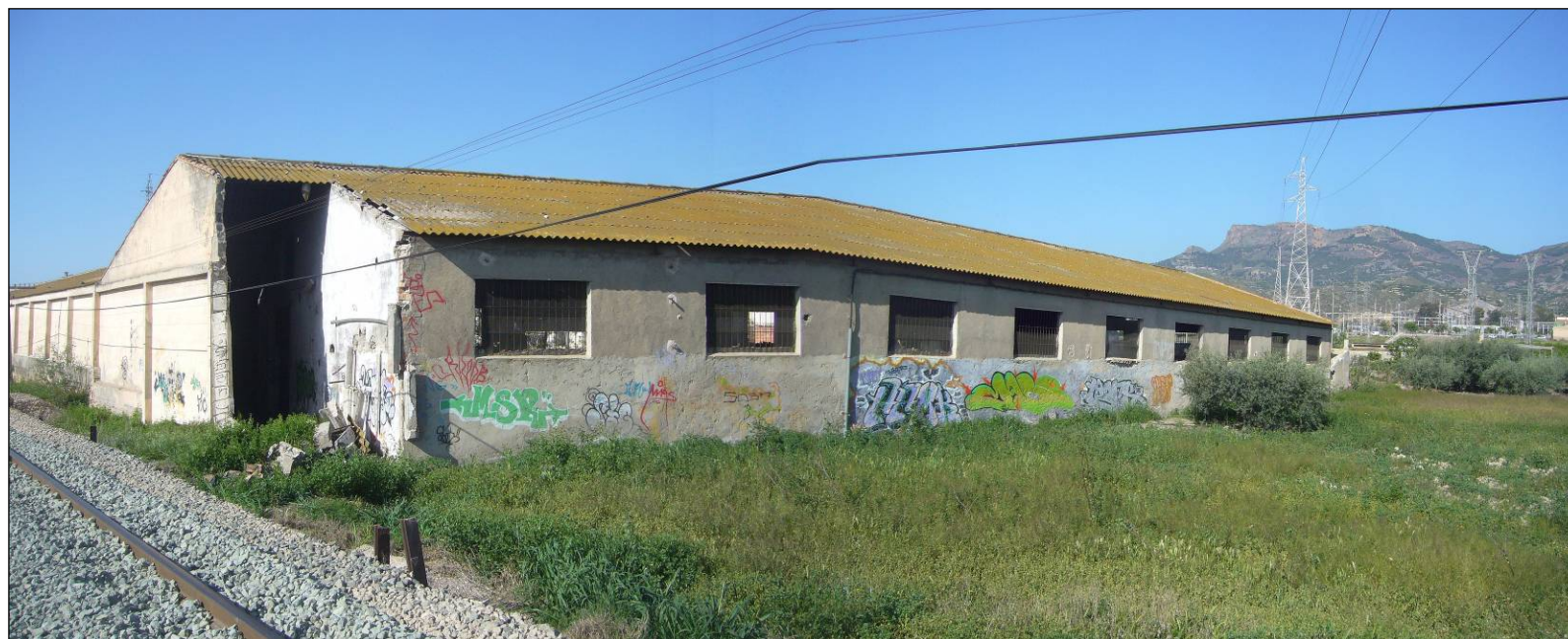
Foto 205. Vista de la nave existente en el P.K. 51+800 (204+650), margen derecha.
