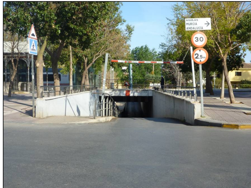
Foto 142. Vista del paso inferior que cruza bajo la estación de Lorca Sutullena, hacia la plaza de toros. Desde este paso se accede también a los andenes.
