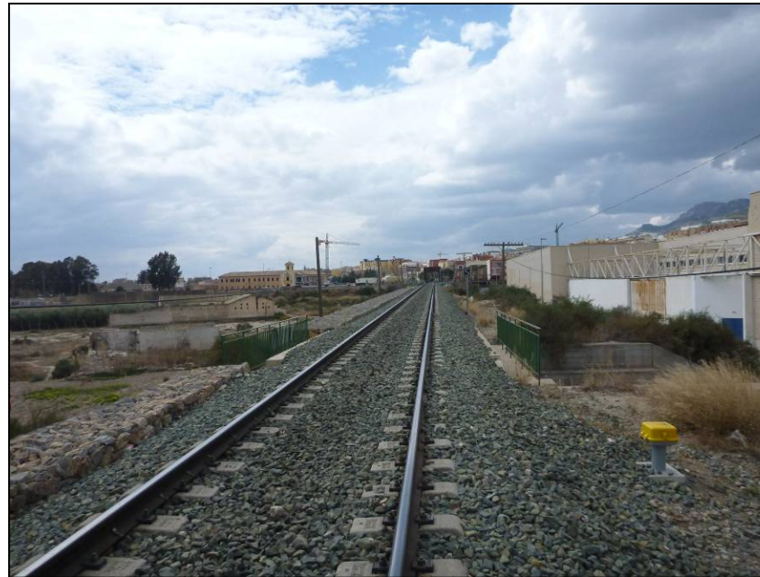
Foto 71. Vista desde la línea ferroviaria del paso inferior P.K. 49+220 (202+070). Se observa la estructura prevista para la duplicación por la derecha y un muro de escollera en el lado izquierdo.
