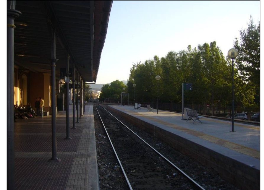
Foto 150. Panorámica de la estación de Lorca Sutullena, al inicio del andén central. Existe marquesina junto al edificio de viajeros.
