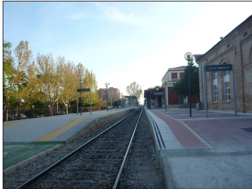
Foto 138. Vista del inicio de los andenes de Sutullena, donde se ha levantado un paso a nivel entre andenes.
