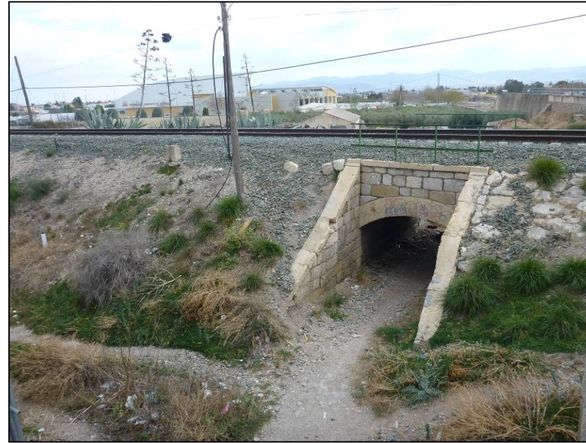
Foto 78. Otra vista de la obra de drenaje P.K. 49+400 (202+250), esta vez desde la margen derecha.
