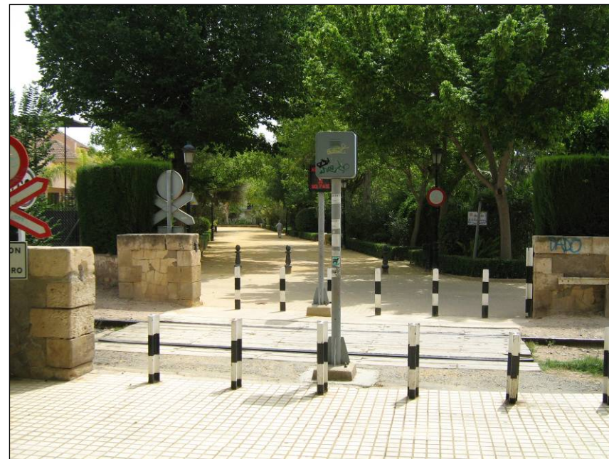
Foto 131. Vista del paso a nivel peatonal de la Alameda de la Constitución, P.K. 49+960 (0/005) (202+815).
