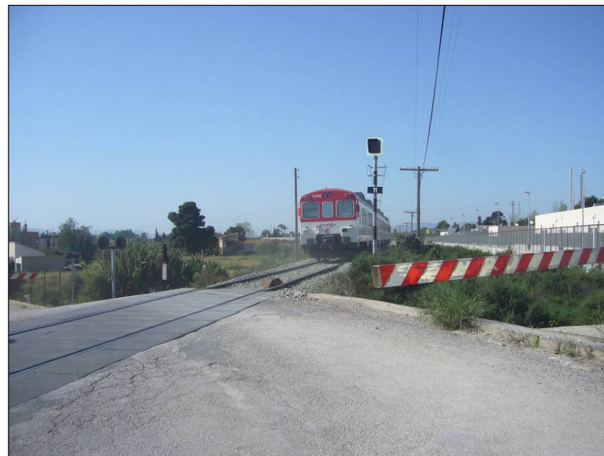
Foto 184. Panorámica del paso a nivel de la calle Martín Morata, en sentido Baza. Se observa una nueva nave en la margen derecha.
