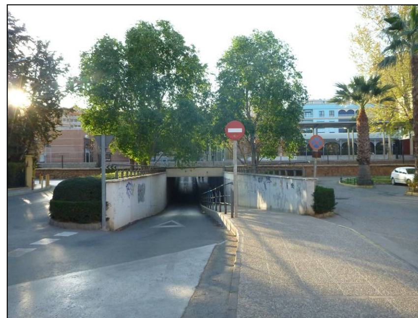
Foto 146. Otra vista del paso inferior anterior, desde la margen izquierda.
