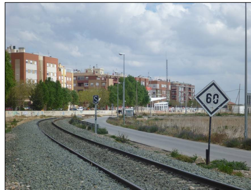
Foto 62. Vista de la línea ferroviaria a la salida de San Diego, en sentido a la estación.
