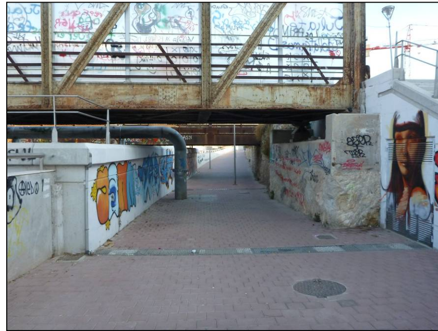
Foto 107. Detalle del paso peatonal bajo la pasarela metálica.
