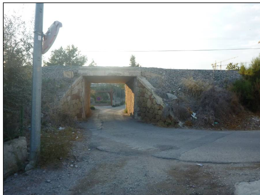
Foto 193. Vista del paso inferior P.K. 51+500 (204+350), desde la margen izquierda.
