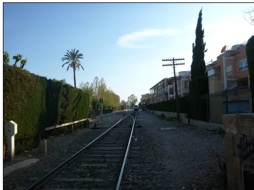
Foto 133. Vista de la entrada a la estación de Lorca Sutullena, desde el paso a nivel peatonal de la Alameda de la Constitución.
