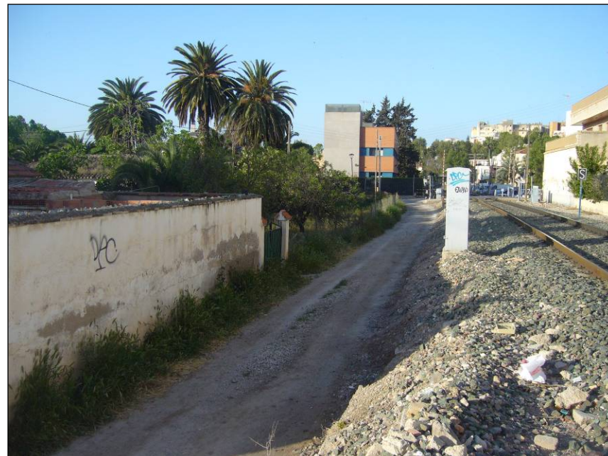
Foto 115. Vista del acceso a las edificaciones anteriores, en dirección a Fajardo el Bravo. Se observa su proximidad a la línea ferroviaria.
