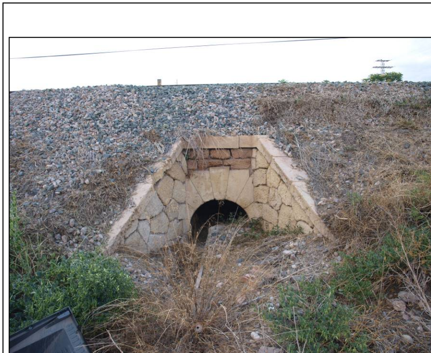
TAJEA Bóveda 1x0,7 m
