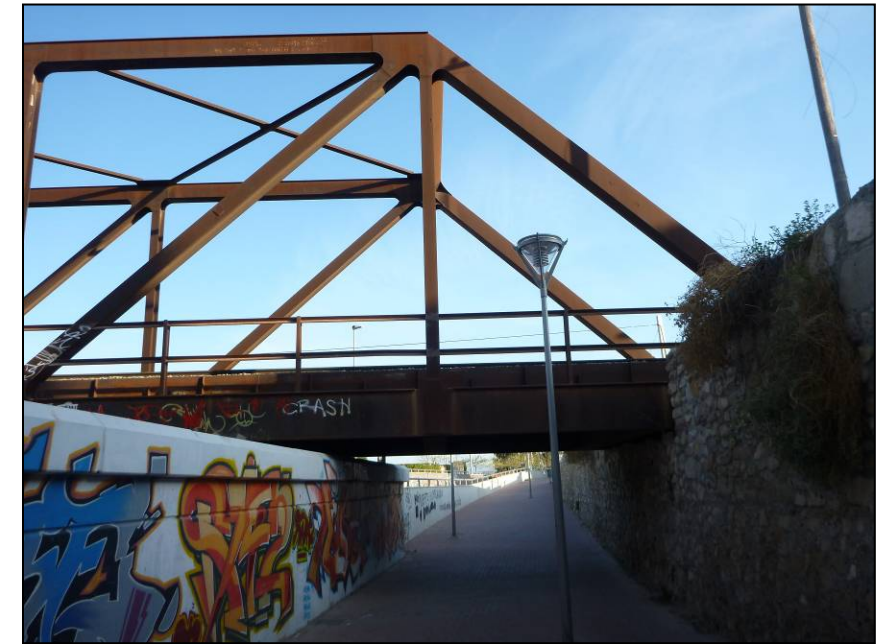
Foto 108. Detalle del paso peatonal bajo el puente metálico ferroviario.
