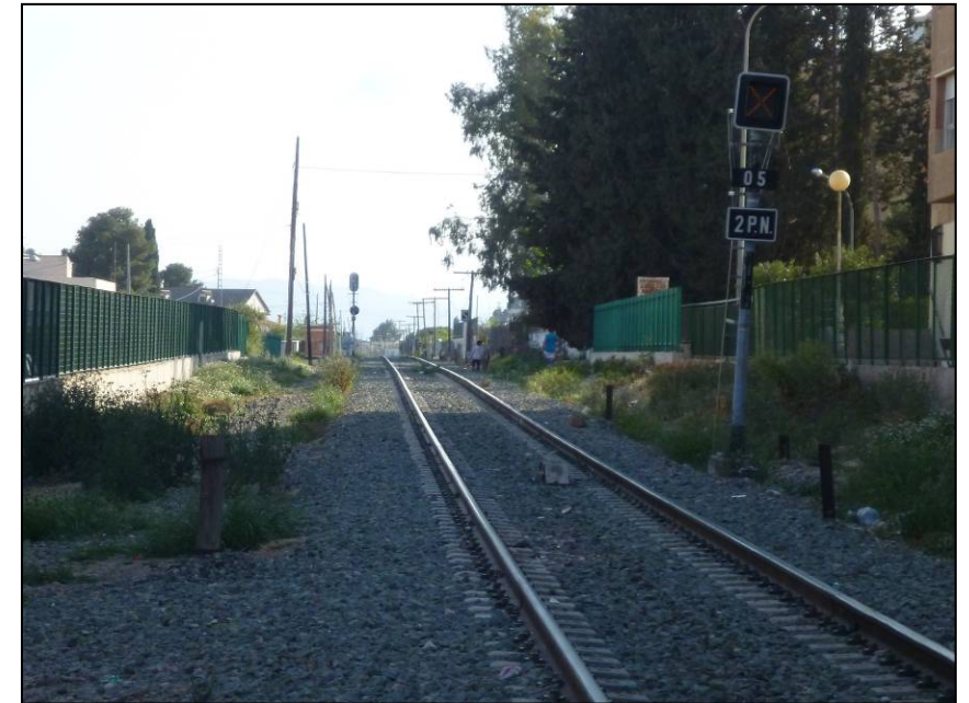
Foto 172. Vista de la línea ferroviaria entre Avenida de Cervantes y Camino Marín.
