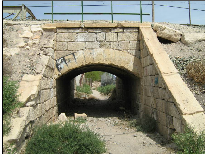
Foto 77. Vista de la obra de drenaje indicada en la fotografía anterior, situada en el P.K. 49+400 (0/565 de la línea Lorca Sutullena - Lorca San Diego). (202+250)
