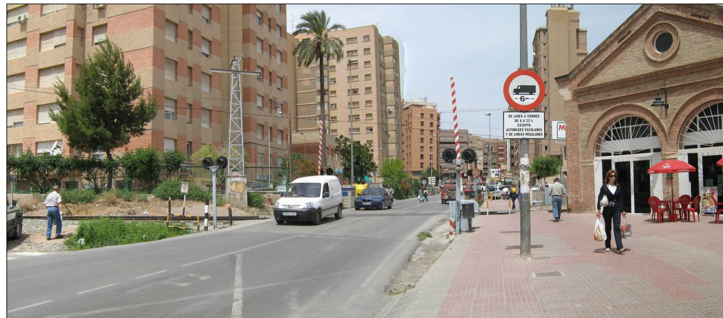
Foto 165. Panorámica del paso a nivel de la Avenida de Cervantes, P.K. 50+480 (0/493 de la línea Lorca - Baza) (203+320).
