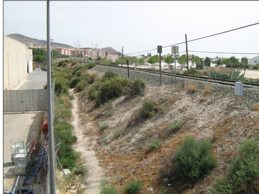
Foto 80. Vista del vial paralelo a la línea en sentido San Diego, desde el estribo de la pasarela peatonal sobre el río Guadalentín.
