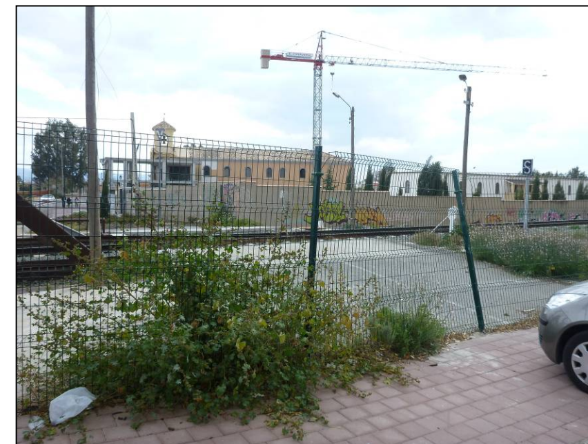
Foto 93. Vista del antiguo paso a nivel de Santa Clara, repuesto con un paso inferior.
