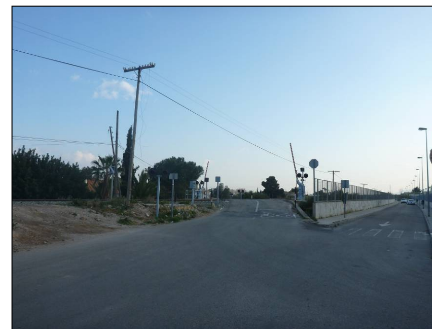
Foto 187. Vista del paso a nivel de la calle Martín Morata, desde la margen derecha.
