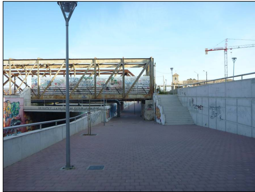
Foto 106. Vista de la zona peatonal derecha, con escaleras a la pasarela metálica y paso bajo ésta.
