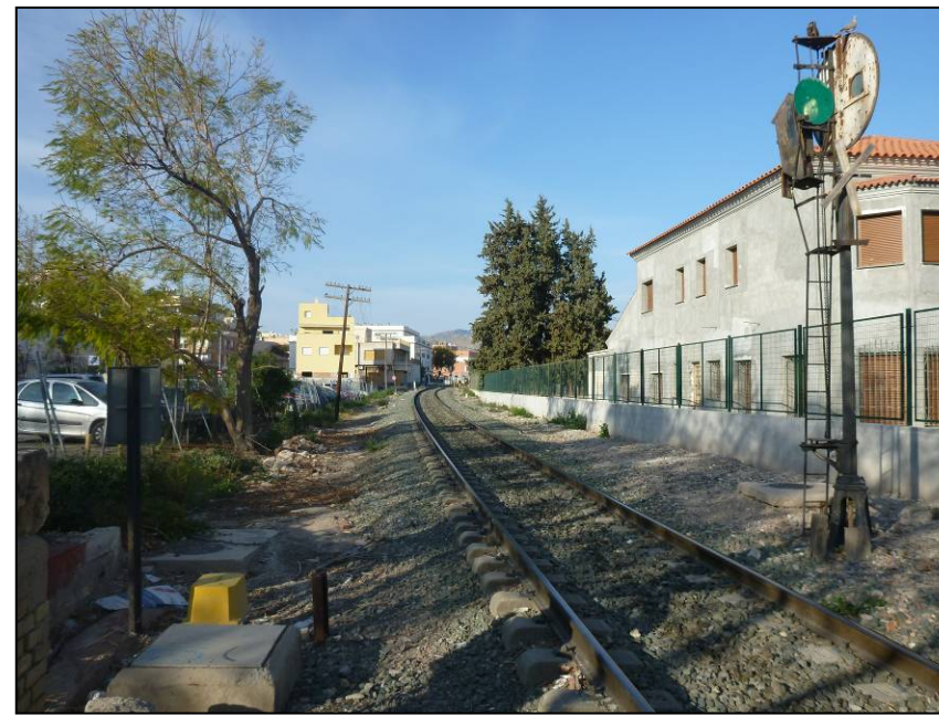
Foto 124. Vista de la línea ferroviaria entre Ramón y Cajal y Fajardo el Bravo.
