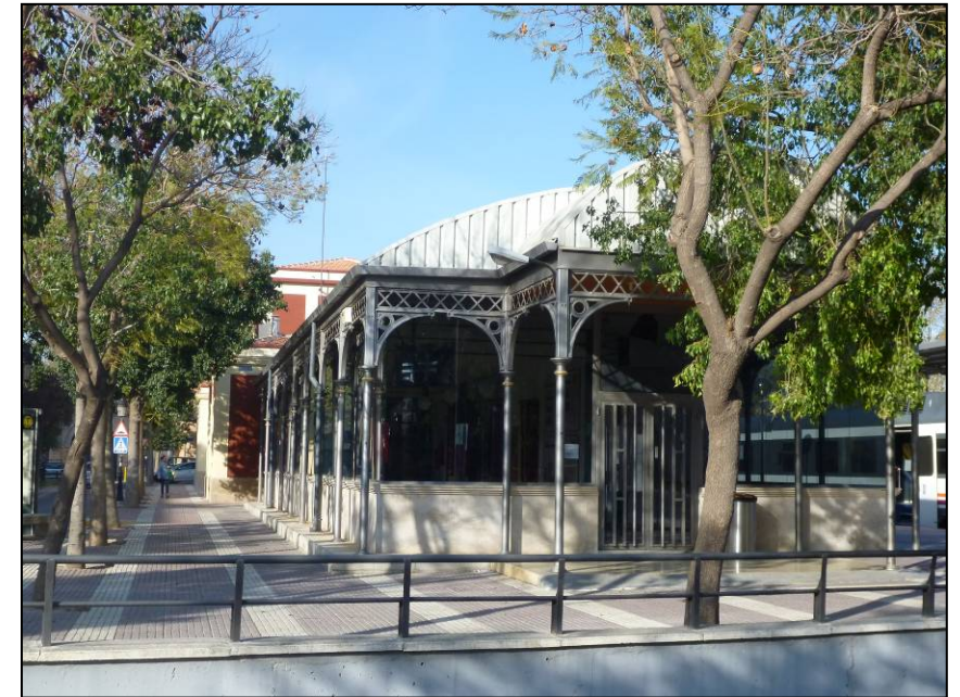
Foto 140. Edificación anexa al edificio de viajeros de Sutullena.
