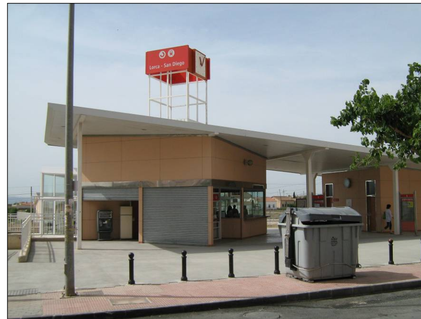
Foto 58. Edificio de viajeros de Lorca San Diego, visto desde la calle de acceso a la estación.
