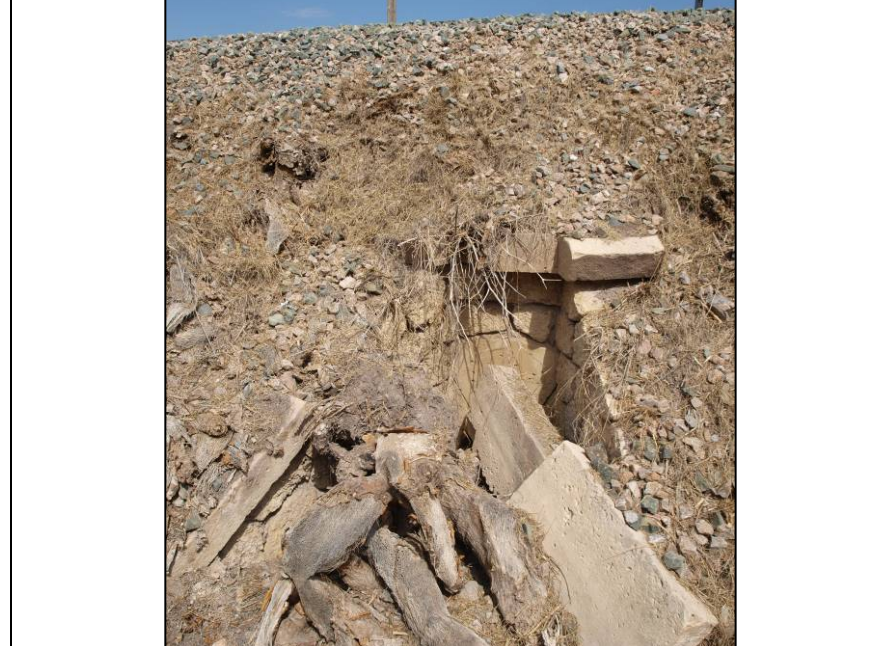
TAJEA Bóveda 0,5x0,9 m 51+240 204+095
