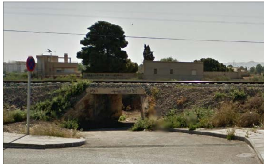
Foto 190. Paso inferior P.K. 51+350 (204+205).
