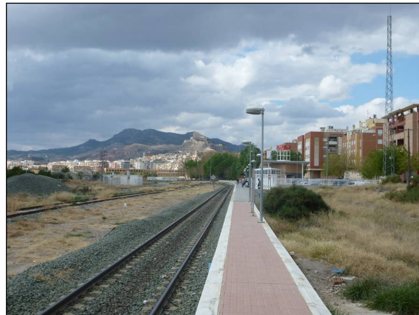
Foto 51. Panorámica de la estación de San Diego desde el inicio del andén. Se observa la antigua vía mango izquierda, ahora abandonada como la vía derecha.
