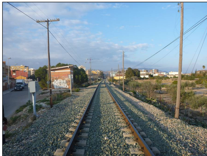
Foto 181. Vista de la línea sentido Lorca desde la calle Martín Morata.
