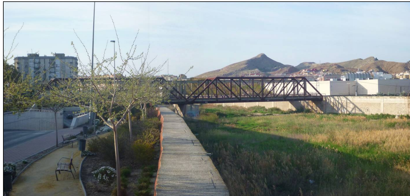
Foto 95. Panorámica del viaducto desde aguas abajo.
