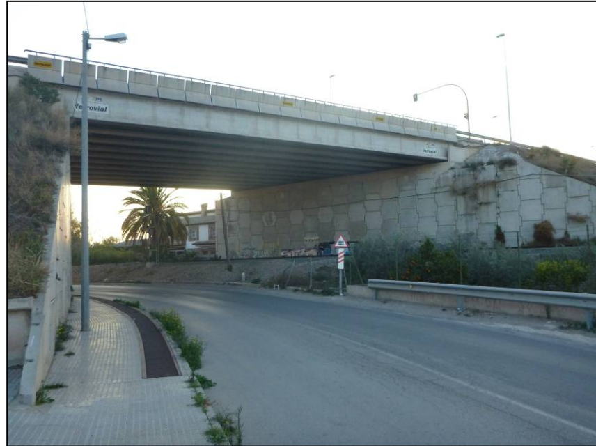
Foto 209. Otra vista del paso superior de la RM-11, desde el vial urbano paralelo a la línea ferroviaria por el lado izquierdo.
