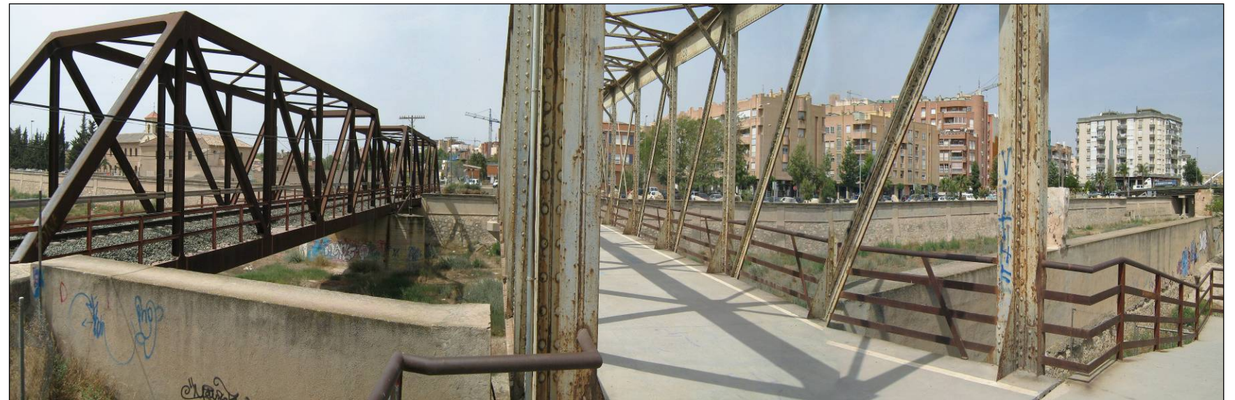
Foto 81. Panorámica del viaducto ferroviario metálico y la pasarela peatonal sobre el río Guadalentín, desde el estribo de entrada.
