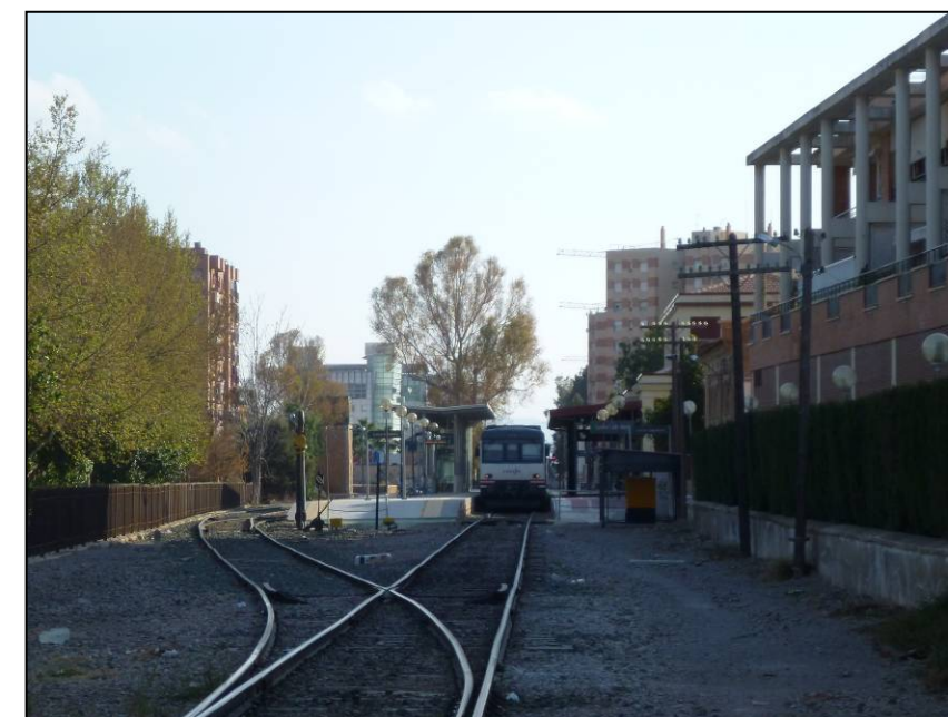
Foto 137. Vista de la entrada a la estación de Lorca Sutullena. Se observa el andén central y la vía de apartado izquierda.
