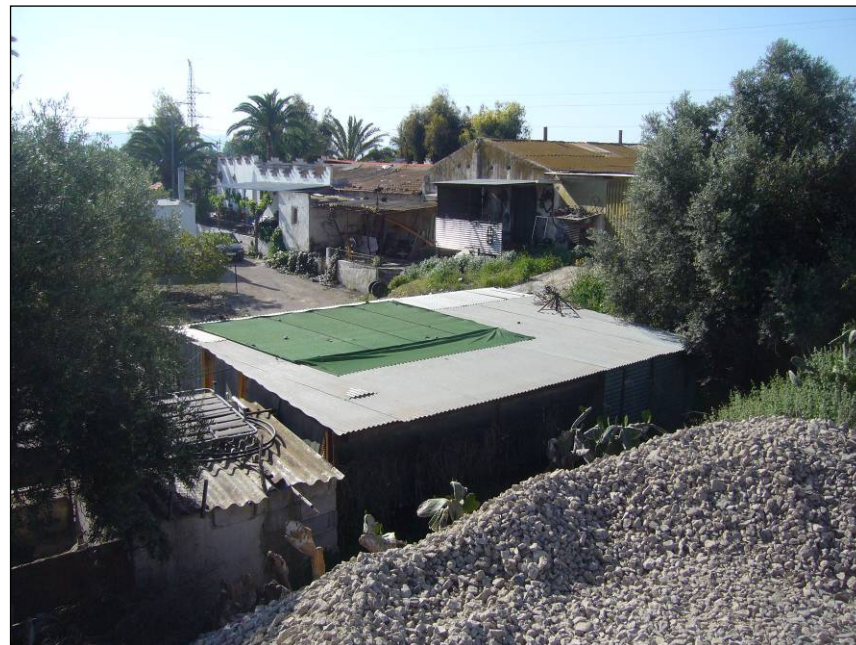
Foto 202. Panorámica de las edificaciones de la margen izquierda en el P.K. 51+700 (204+550). Se observa la altura de la línea ferroviaria respecto a ellas.
