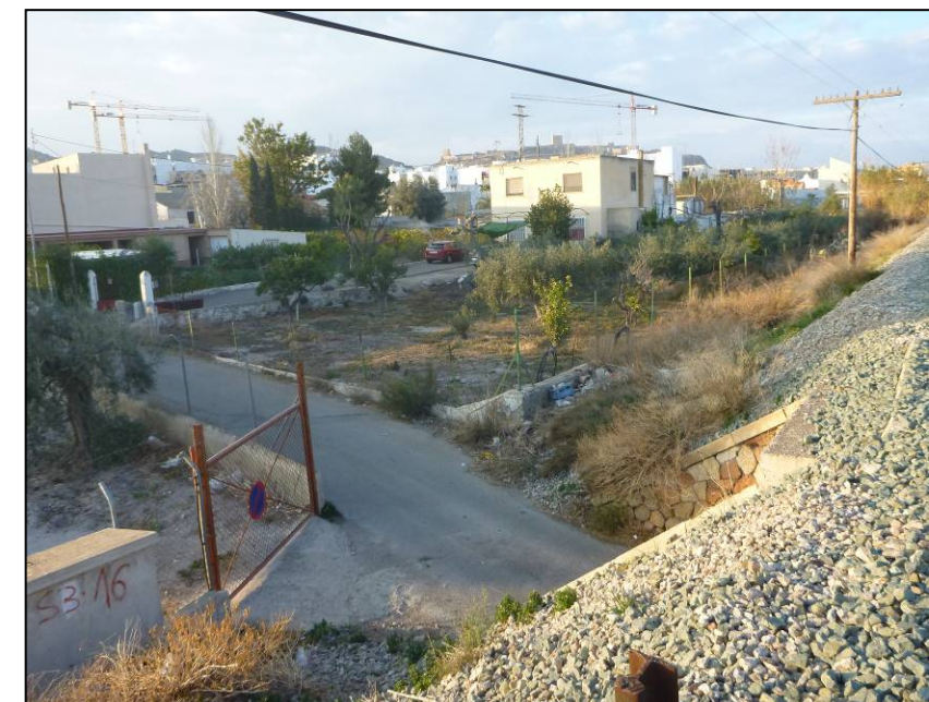
Foto 195. Vista de la margen derecha, P.K. 51+500 (204+350).
