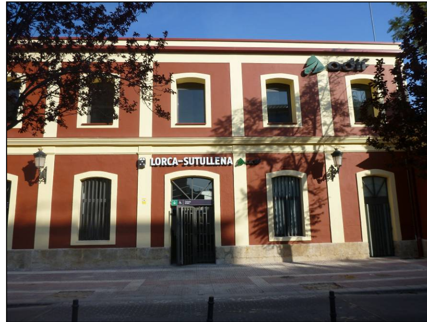
Foto 139. Edificio remodelado de la estación de Sutullena. Acceso exterior.
