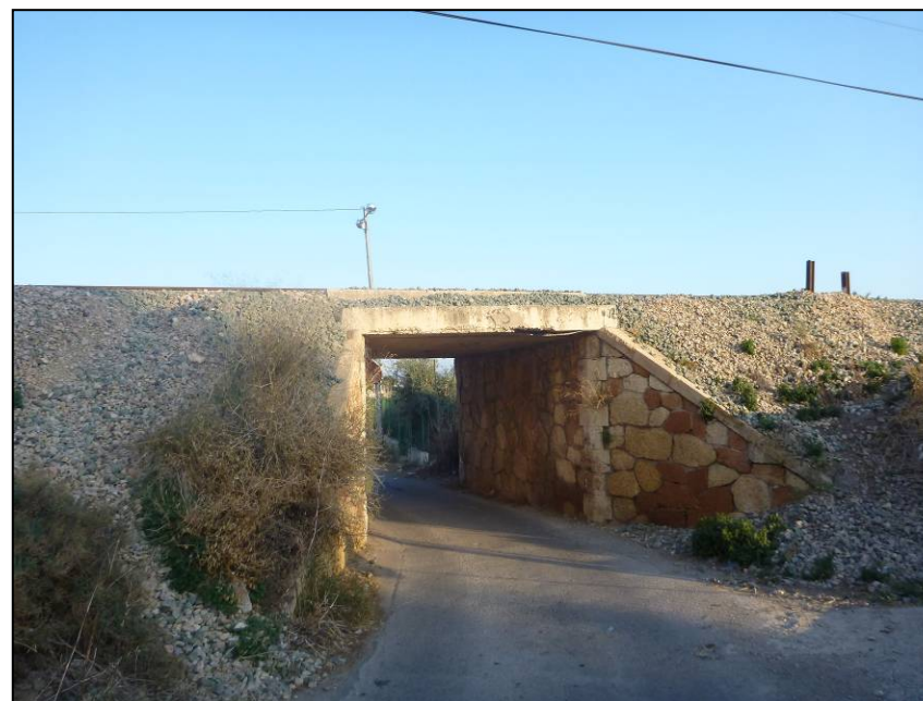
Foto 194. Otra vista del paso inferior P.K. 51+500 (204+350), desde la margen derecha.
