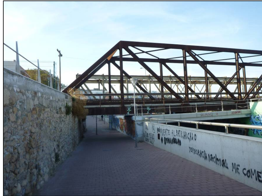
Foto 100. Detalle del paso peatonal, margen izquierda.
