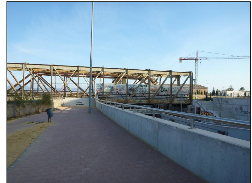
Foto 105. Detalle del nuevo acceso a la pasarela metálica, del lado del río.
