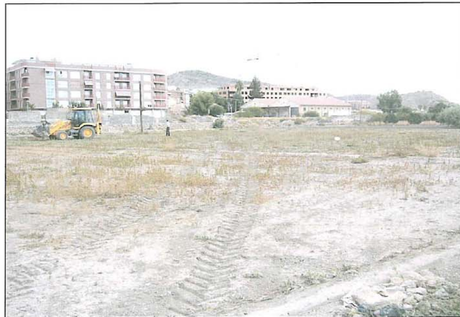
Emplazamiento de la calicata nº 2
