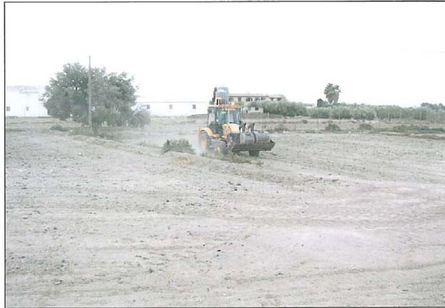
Emplazamiento de la calicata nº1
