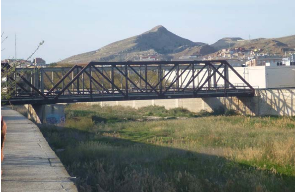
Fotografía 4.2.1.1.a.- Viaducto de la Línea actual de ferrocarril sobre el Río Guadalentín.
