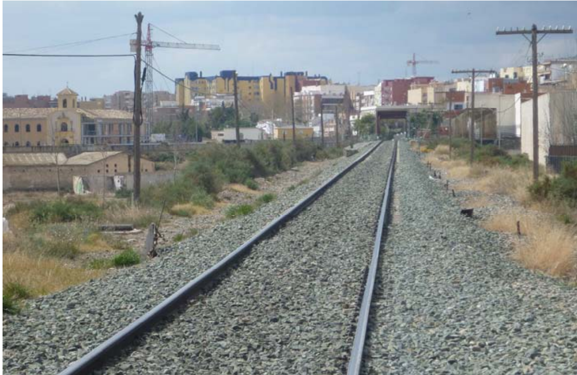
Fotografía 4.2.1.2.a.- Comienzo del soterramiento, en el P.K.202+050 del Estudio, Alternativa 2.
