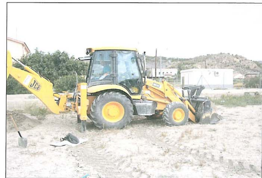
Emplazamiento de la calicata nº 4
