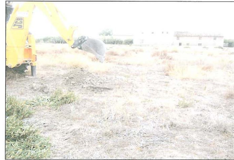
Emplazamiento de la calicata nº3
