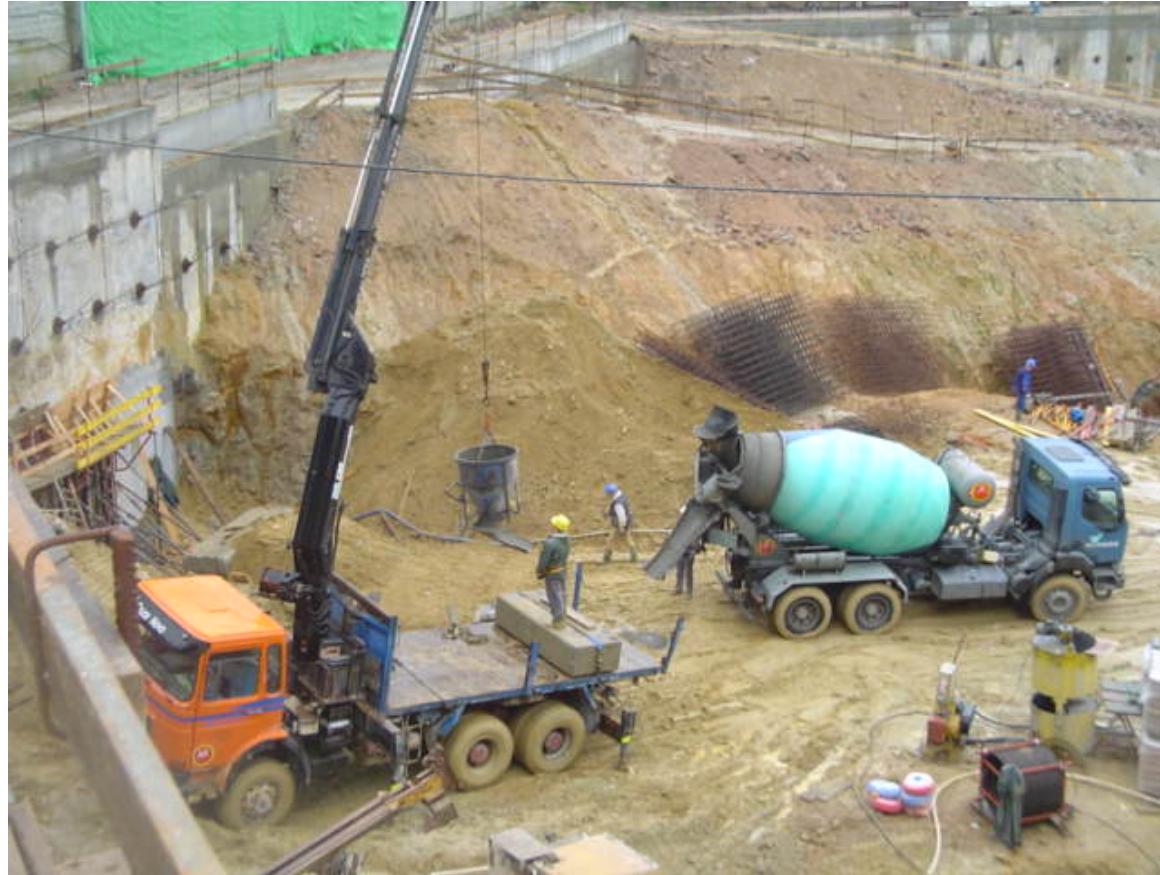
Figura 6.a.- Pantalla acodalada con berma de tierras.
