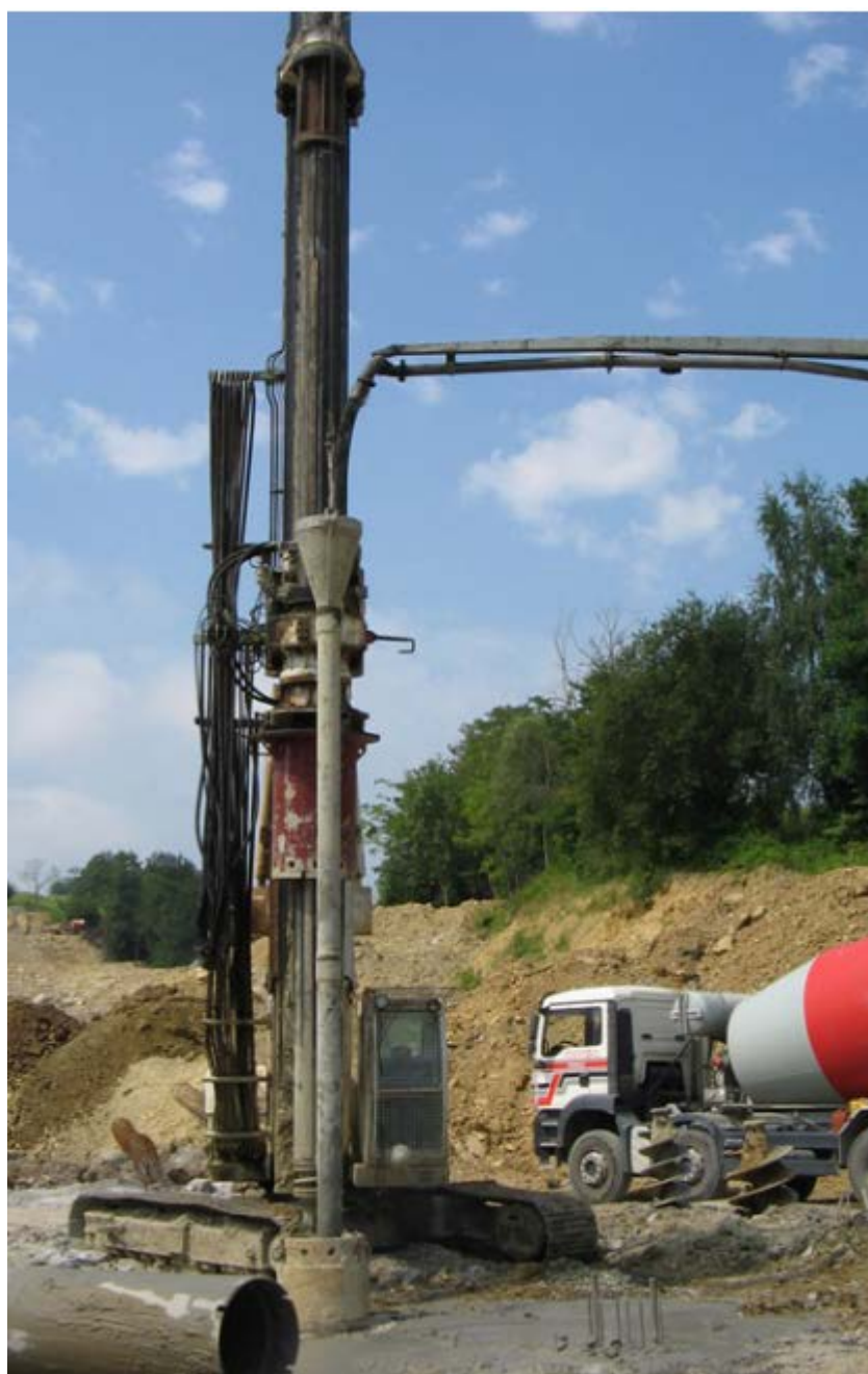
Figura 5.1.a – Hormigonado de pantallas con tubo tremie.
