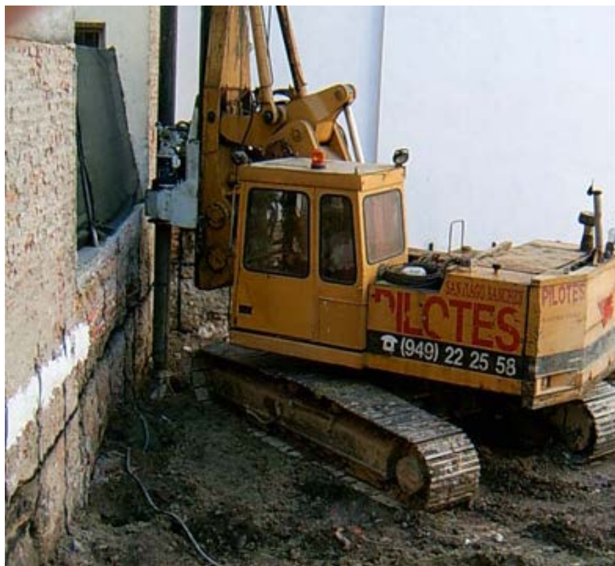
Figura 5.2.1.b – Ejemplo de operatividad de equipos de ejecución de pilotes.
