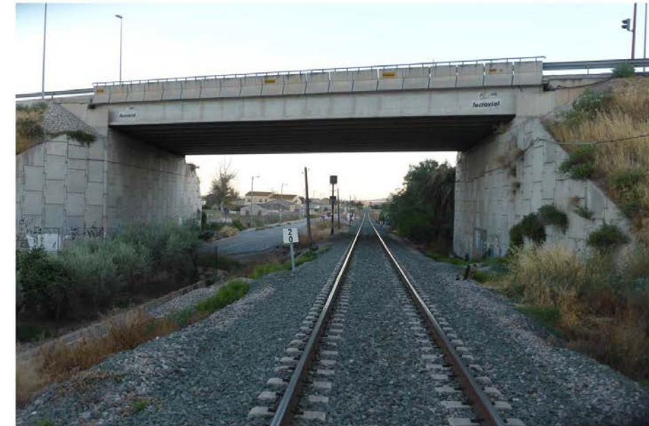
Autovía Lorca – Águilas (RM-11). Estructura de cruce con el FFCC.
