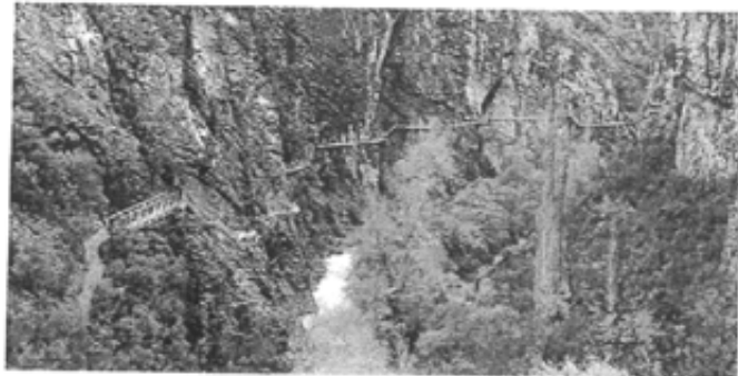
Tramo afectado de la Ruta de las Pasarelas de Alquézar tras los desprendimientos.
