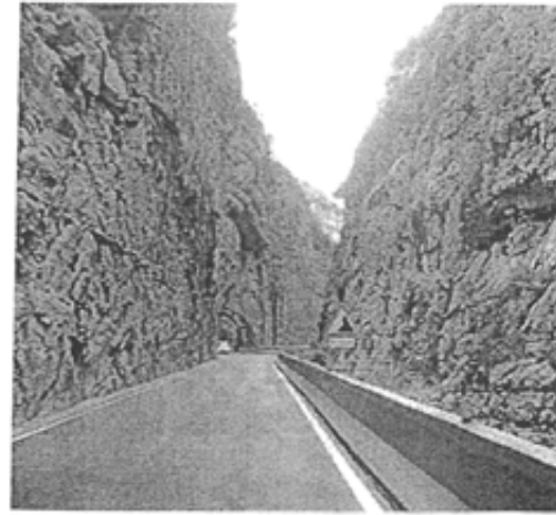
Tramo de la N-260 en el Congosto de Ventamillo. L.A.
