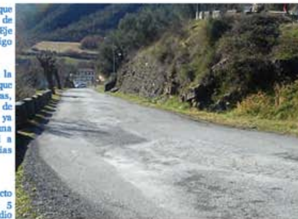
FOTO: Imagen de la N-260 a la salida de Fiscal, hacia los túneles de Balupor.
