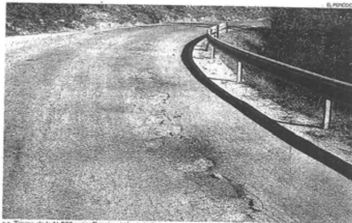
Tramo de la N-260 entre Fiscal y el túnel de Balupor.
