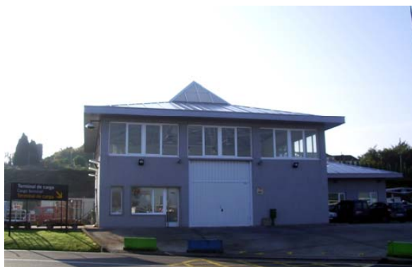
Ilustración 2.23.- Edificio Terminal de Carga
