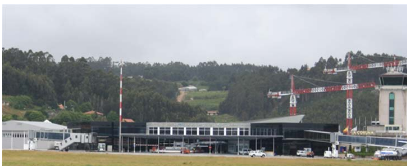
Ilustración 2.7.- Edificio Terminal de pasajeros
