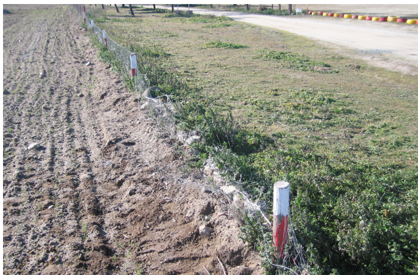
Figura 7. Valla metálica que rompió la aeronave
